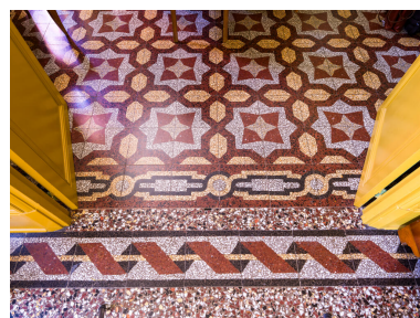
Carreaux de terrazzo du vestibule et de la salle à manger. Phot. Asseline Stéphane IVR11_20259100473NUC4A
