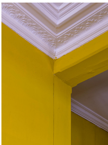
Détail des moulures du plafond du vestibule. Phot. Asseline Stéphane IVR11_20259100478NUC4A
