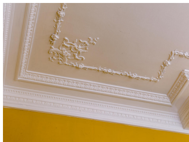
Détail d'un plafond mouluré du rez-de-chaussée. Phot. Asseline Stéphane IVR11_20259100477NUC4A
