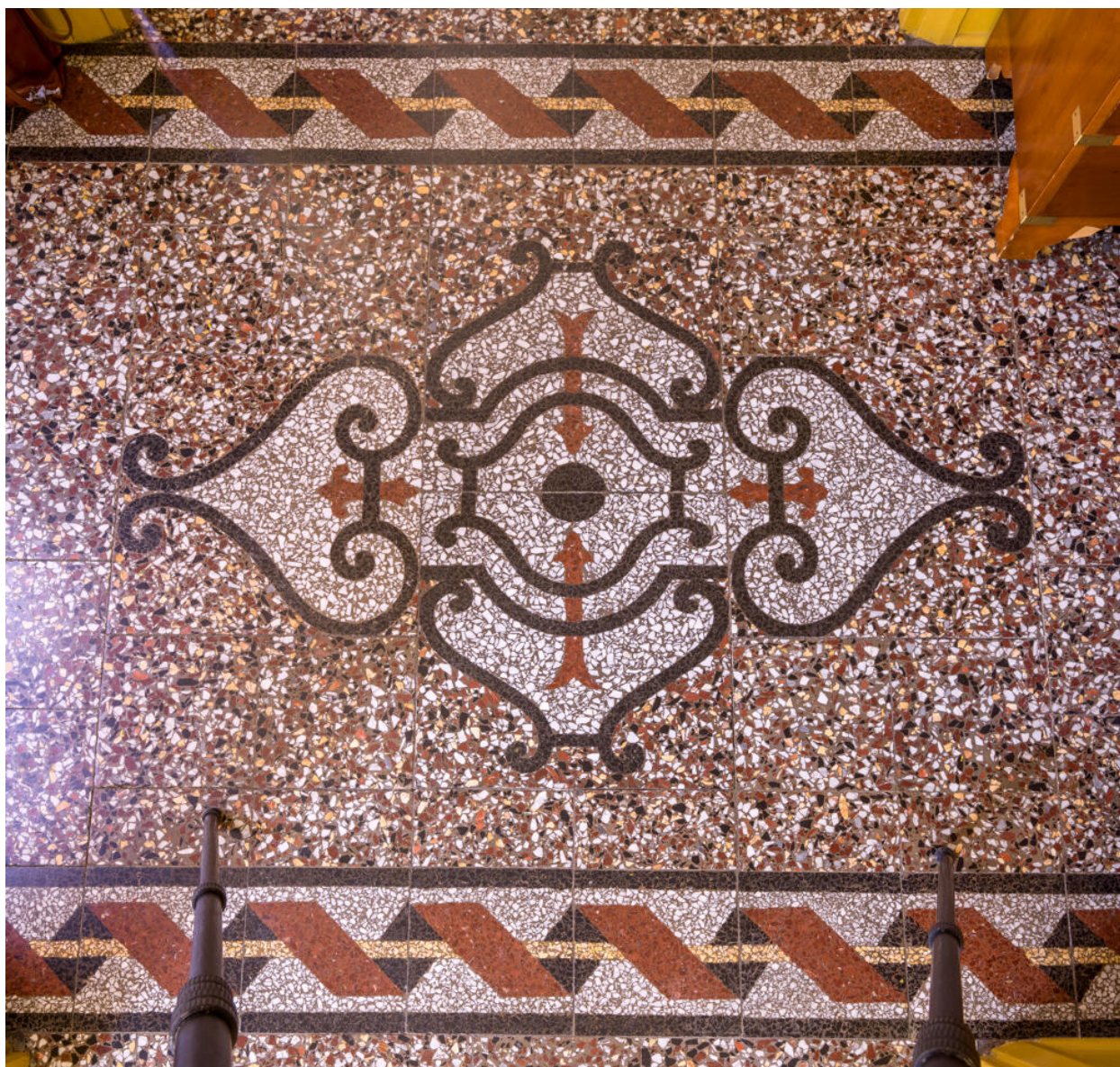
Carreaux de terrazzo du vestibule.
