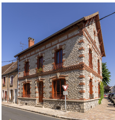
Vue générale depuis le sud-est. Phot. Asseline Stéphane IVR11_20259100462NUC4A
