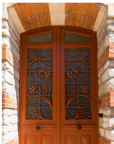
Détail de la porte d'entrée située rue Langlois. Phot. Asseline Stéphane IVR11_20259100464NUC4A
