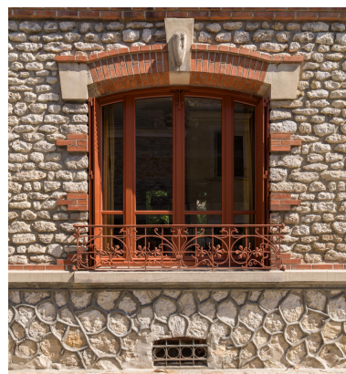
Fenêtre du rez-de-chaussée. Phot. Asseline Stéphane IVR11_20259100465NUC4A
