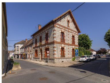
Vue générale depuis le sud-est. Phot. Asseline Stéphane IVR11_20259100463NUC4A
