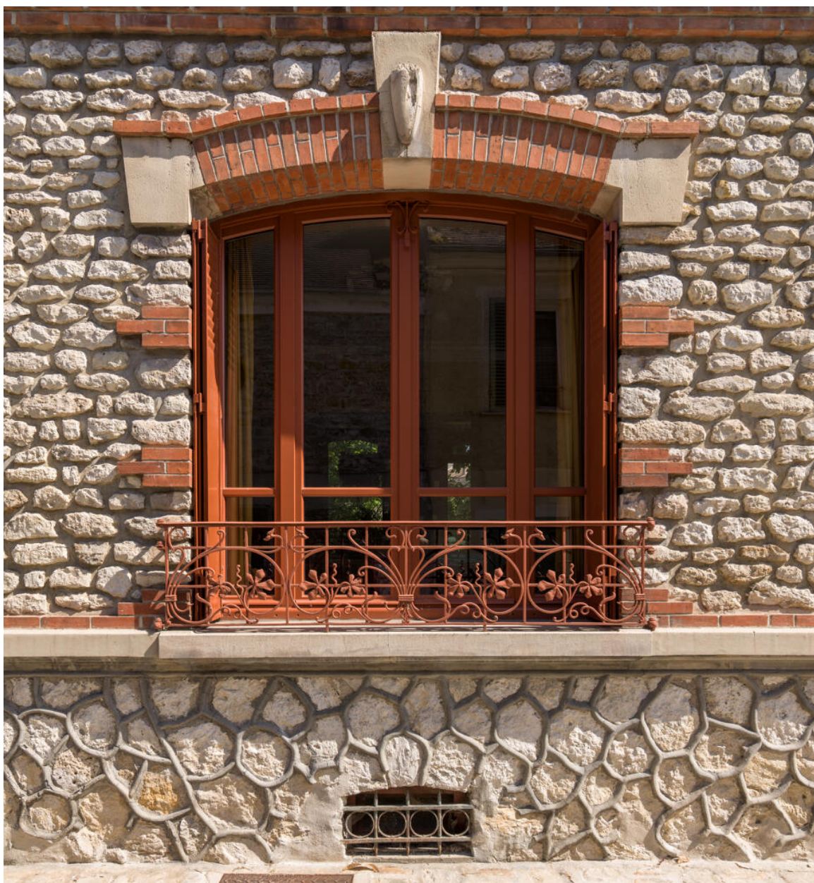
Fenêtre du rez-de-chaussée.
