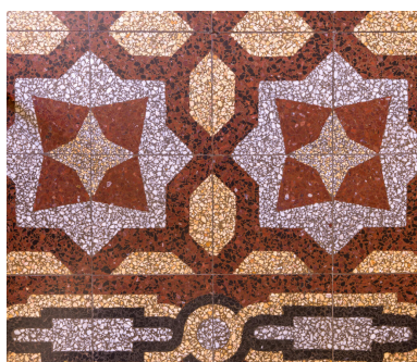
Détail des carreaux de terrazzo de la salle à manger. Phot. Asseline Stéphane IVR11_20259100475NUC4A
