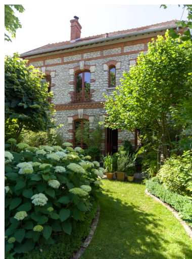
Vue générale de la façade arrière depuis le nord-ouest. Phot. Asseline Stéphane IVR11_20259100480NUC4A
