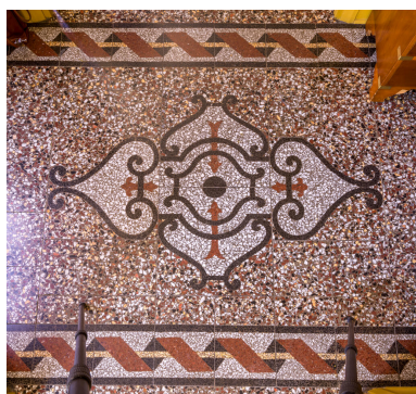
Carreaux de terrazzo du vestibule. Phot. Asseline Stéphane IVR11_20259100474NUC4A
