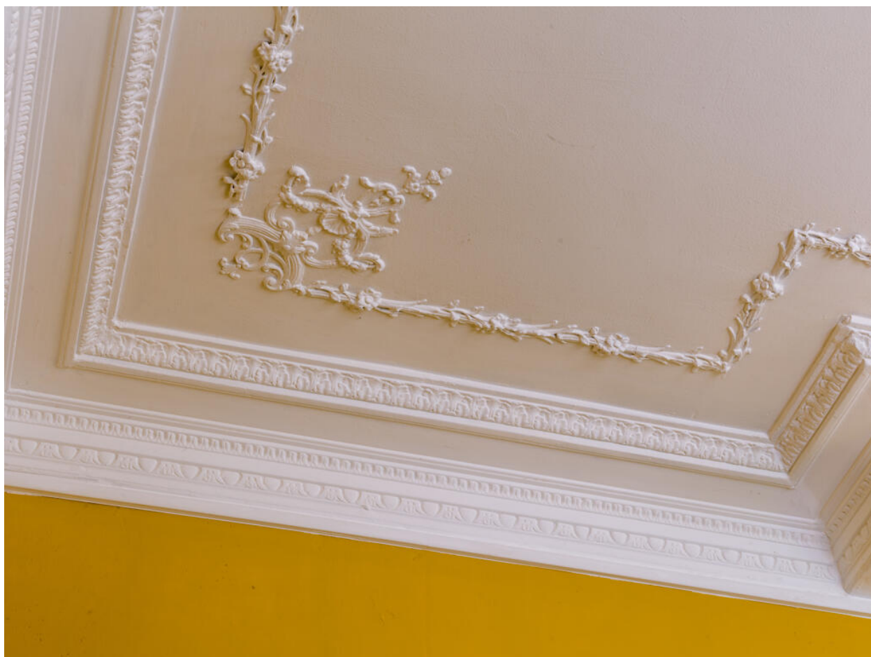
Détail d'un plafond mouluré du rez-de-chaussée.
