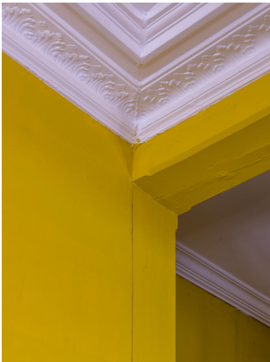
Détail des moulures du plafond du vestibule.
