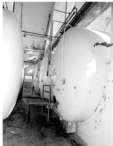
Intérieur du bâtiment de cuvage : cuves portant la plaque : ""Etablissements métallurgiques Louis Granger et cie, Agen, 1947-9"". Photographie avant destruction, 1989. (Ministère de la culture, Inventaire général. 89SG680X) Phot. Philippe Ayrault, Autr. Philippe Fortin IVR11_20037700018NUCB
