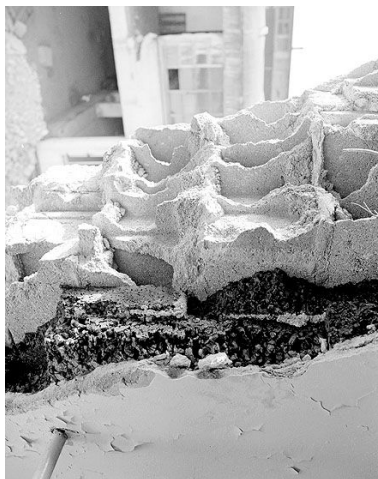
Détails des matériaux des murs du cuvage : ciment, liège, parpaing. Photographie avant destruction, 1989. (Ministère de la culture, Inventaire général. 89SG691X) Phot. Philippe Ayrault, Autr. Philippe Fortin IVR11_20037700017NUCB
