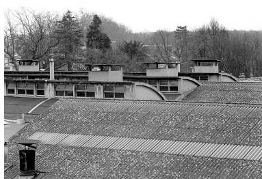
Couverture du hall d'embouteillage. Photographie avant destruction,
