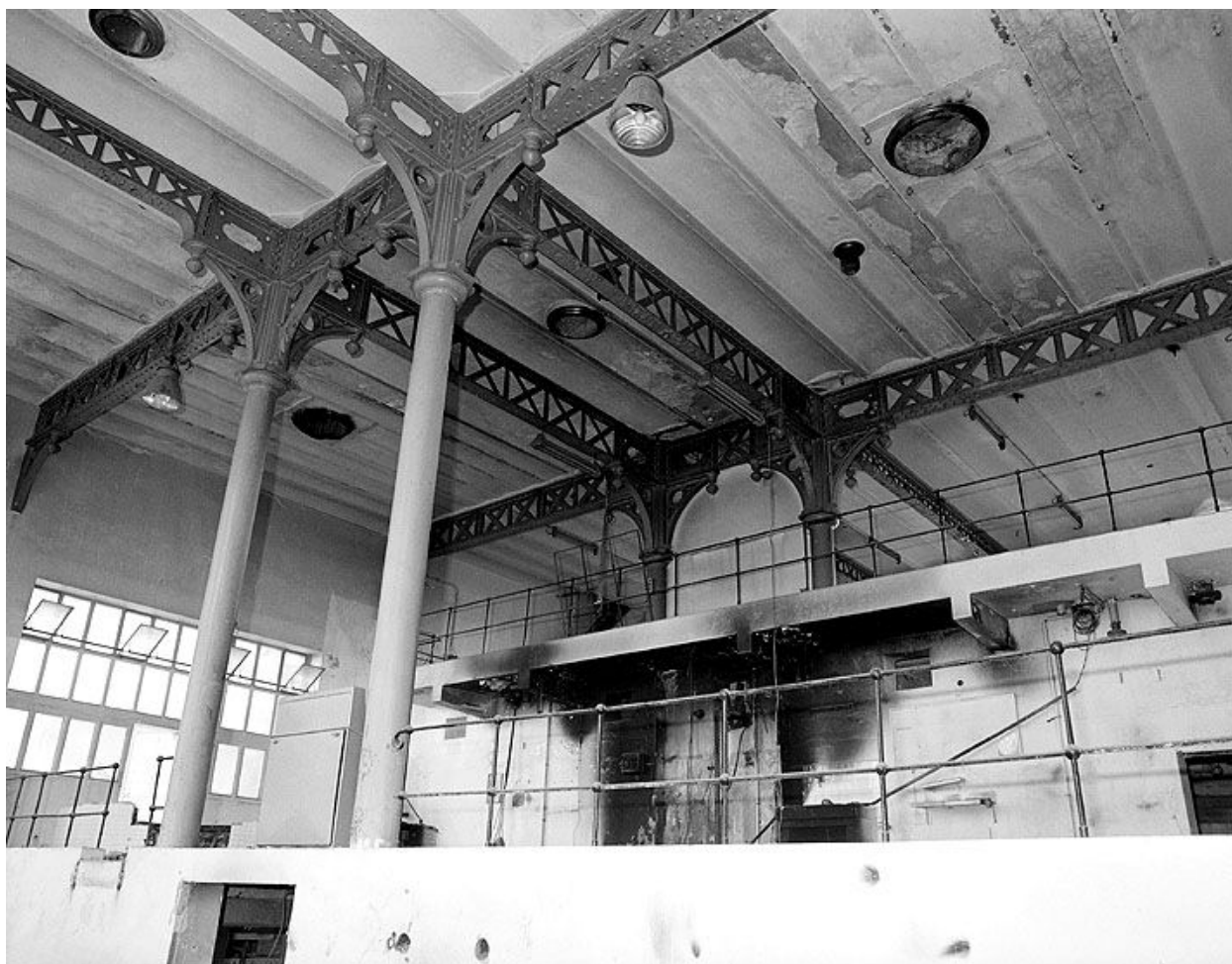
La salle à brasser : colonnes et couvrement. Photographie avant destruction, 1989. (Ministère de la culture, Inventaire général. 89SG703X)
