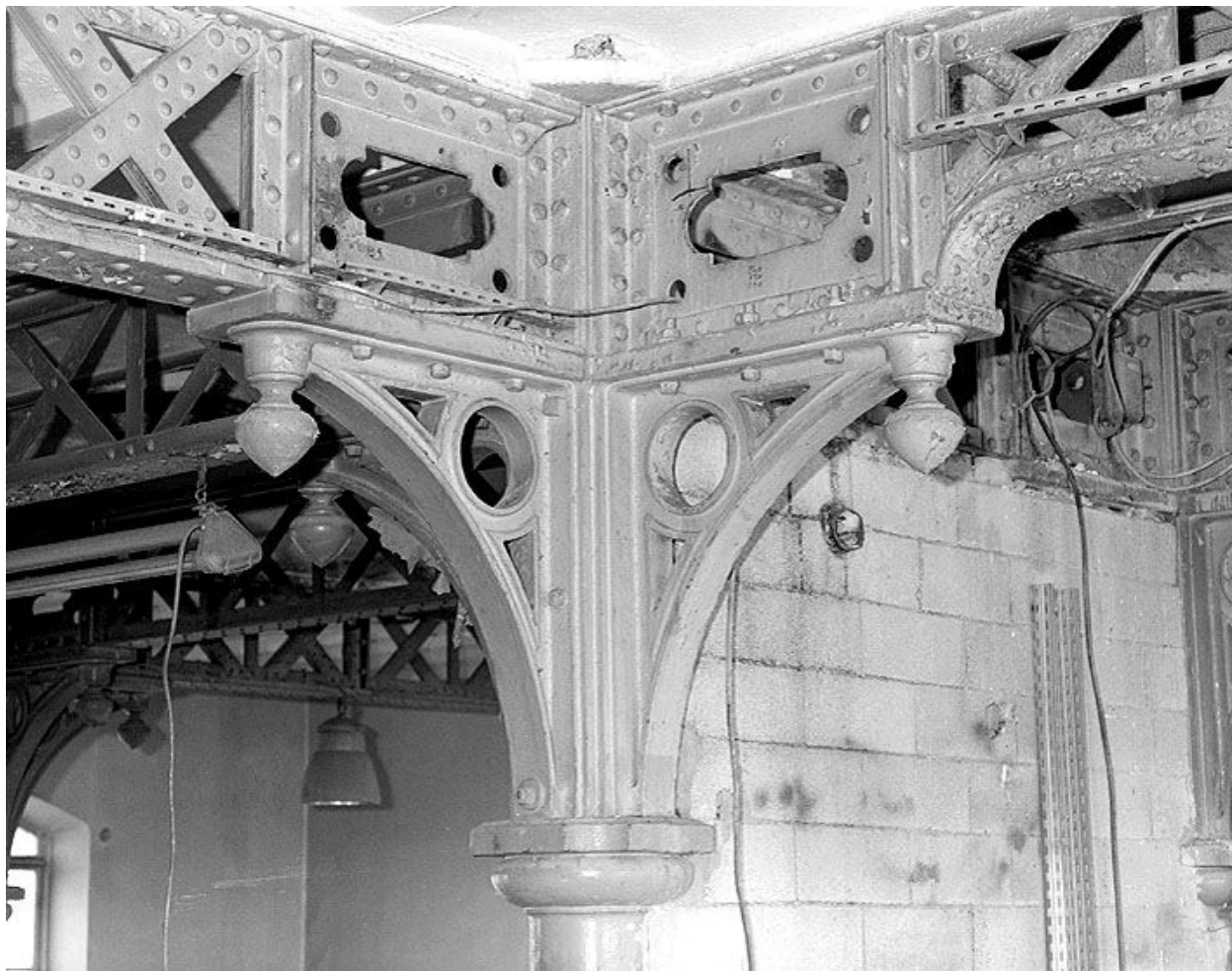
La salle à brasser : détail de la structure en fonte. Photographie avant destruction, 1989. (Ministère de la culture, Inventaire général. 89SG708X)
