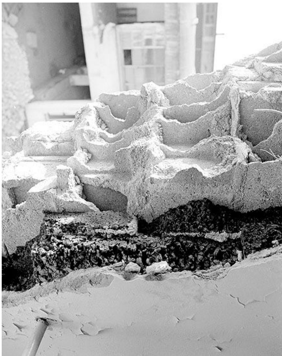
Détails des matériaux des murs du cuvage : ciment, liège, parpaing. Photographie avant destruction, 1989. (Ministère de la culture, Inventaire général. 89SG691X)
