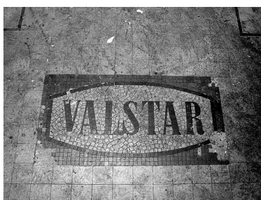
Intérieur du bâtiment de cuvage : détail de la mosaïque du plancher du deuxième étage, avec le logo de la marque ""Valstar"" (boissons gazeuses, années 1960). Photographie avant destruction, 1989. (Ministère de la culture, Inventaire général. 89SG685X) Phot. Philippe Ayrault, Autr. Philippe Fortin IVR11_20037700020NUCB
