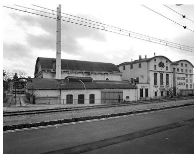
Vue d'ensemble, depuis la voie ferrée au nord : partie ouest de la brasserie Gruber. On voit, de gauche à droite : la passerelle ferroviaire, la chaufferie (et derrière, le cuveau), la salle à brasser et les silos. Photographie avant destruction, 1989. (Ministère de la culture, Inventaire général. 89SG722X) Phot. Philippe Ayrault, Autr. Philippe Fortin IVR11_20037700001NUCB
