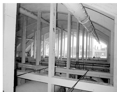
Intérieur du bâtiment de cuvage : structure des combles. Photographie avant destruction, 1989. (Ministère de la culture, Inventaire général. 89SG694X) Phot. Philippe Ayrault, Autr. Philippe Fortin IVR11_20037700021NUCB
