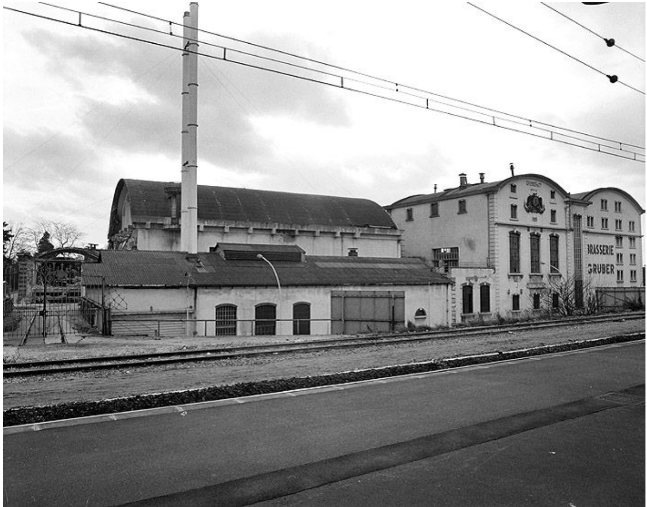
Vue d'ensemble, depuis la voie ferrée au nord : partie ouest de la brasserie Gruber. On voit, de gauche à droite : la passerelle ferroviaire, la chaufferie (et derrière, le cuvage), la salle à brasser et les silos. Photographie avant destruction, 1989. (Ministère de la culture, Inventaire général. 89SG722X)
