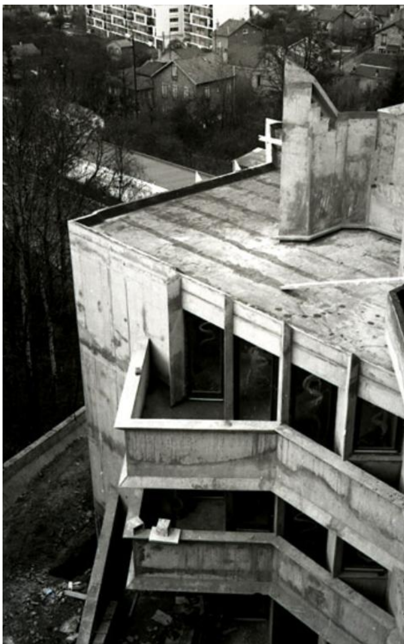
Vue ancienne du toit et des balcons.
