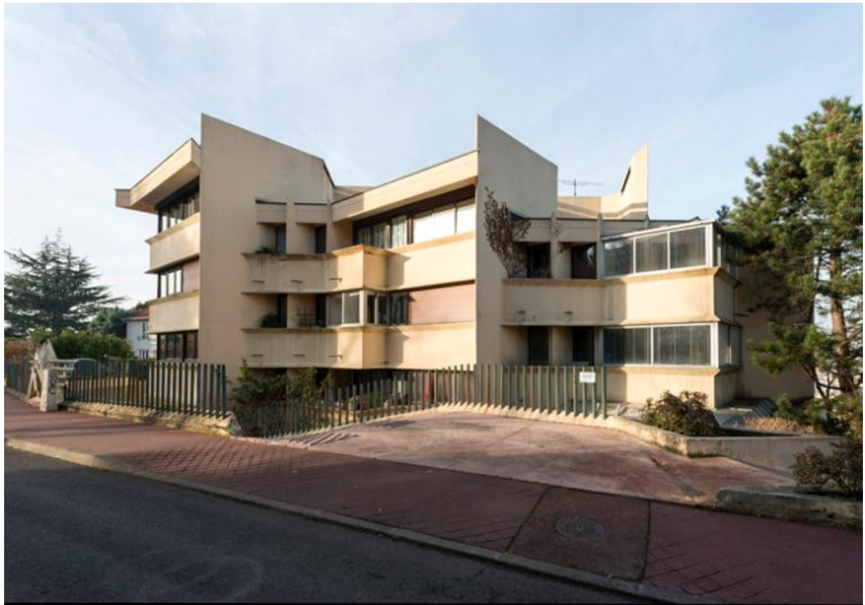
Vue latérale de la façade.
