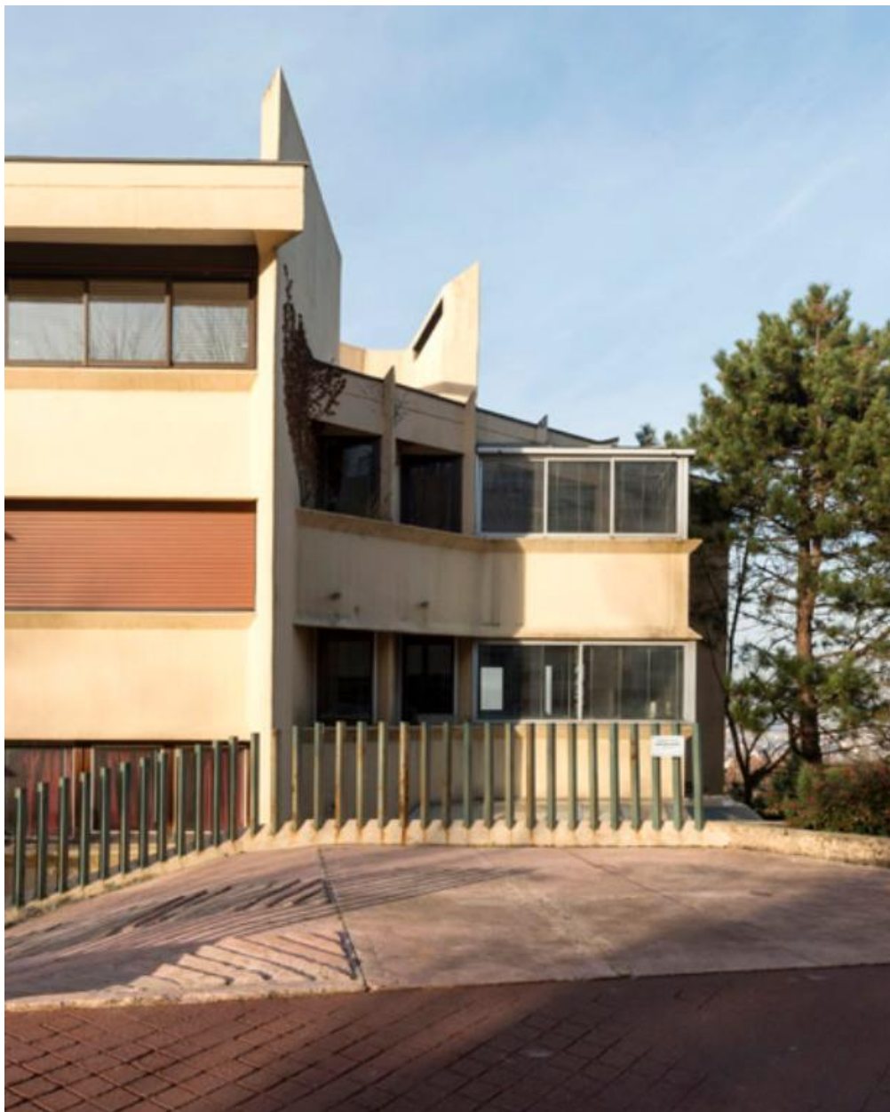
Vue rapprochée de la façade côté droit.
