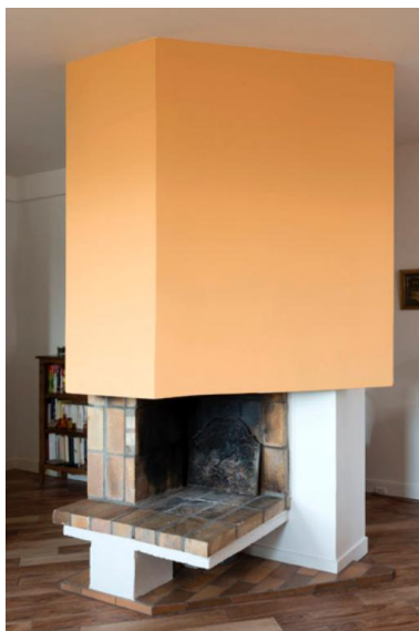
Vue de la cheminée centrale de l'un des appartements. Phot. Laurent Kruszyk IVR11_20169200266NUC4A
