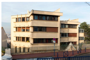
Vue de la façade prise depuis la rue. Phot. Laurent Kruszyk IVR11_20169200251NUC4A
