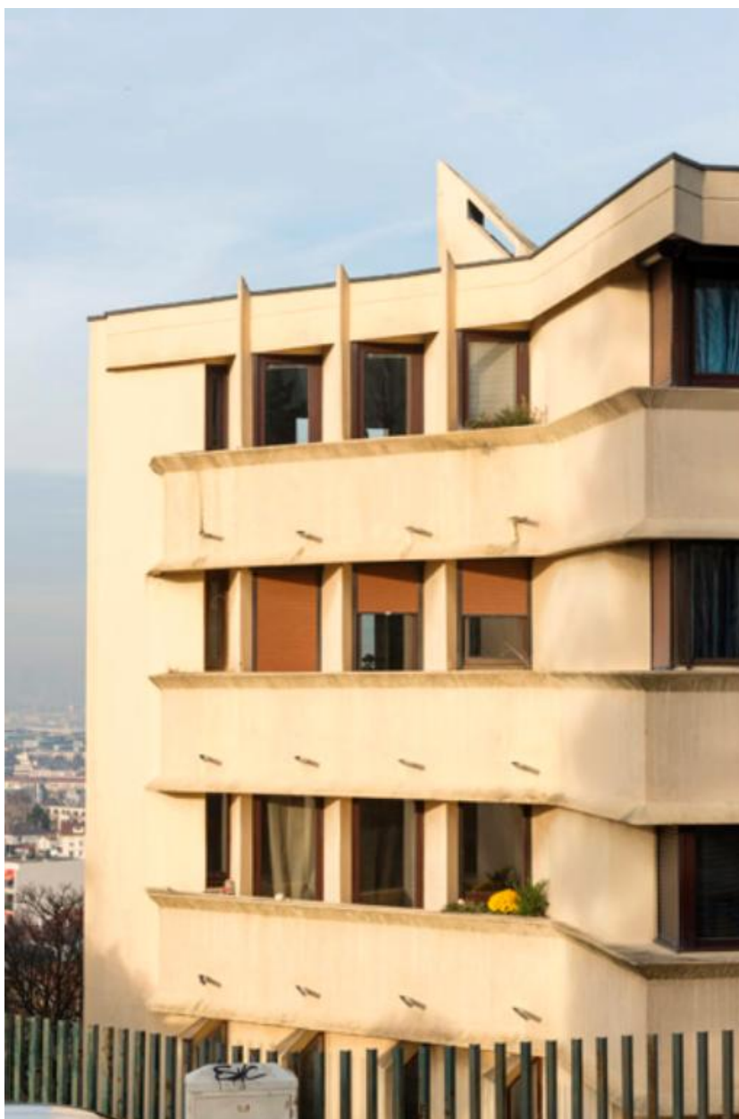
Vue rapprochée de la partie gauche de la façade.
