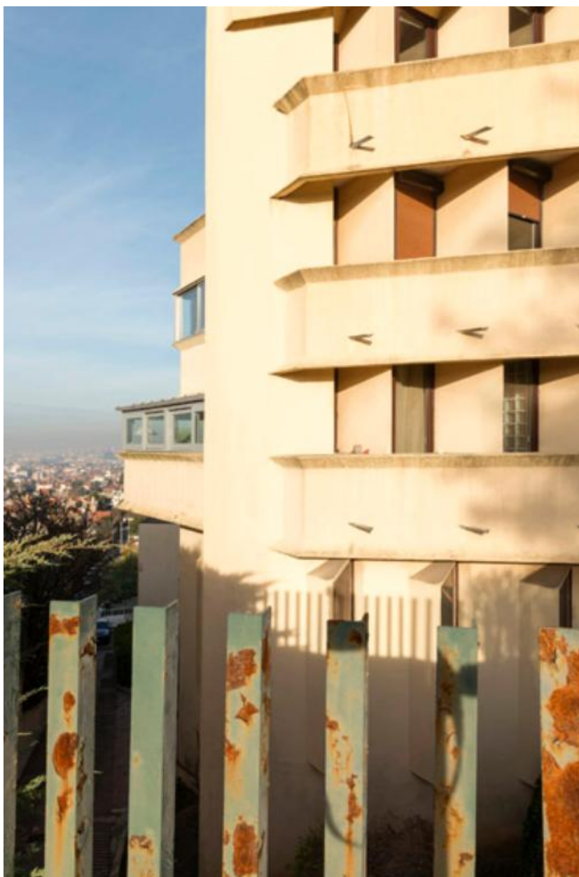
Vue rapprochée de la façade prise du côté gauche.
