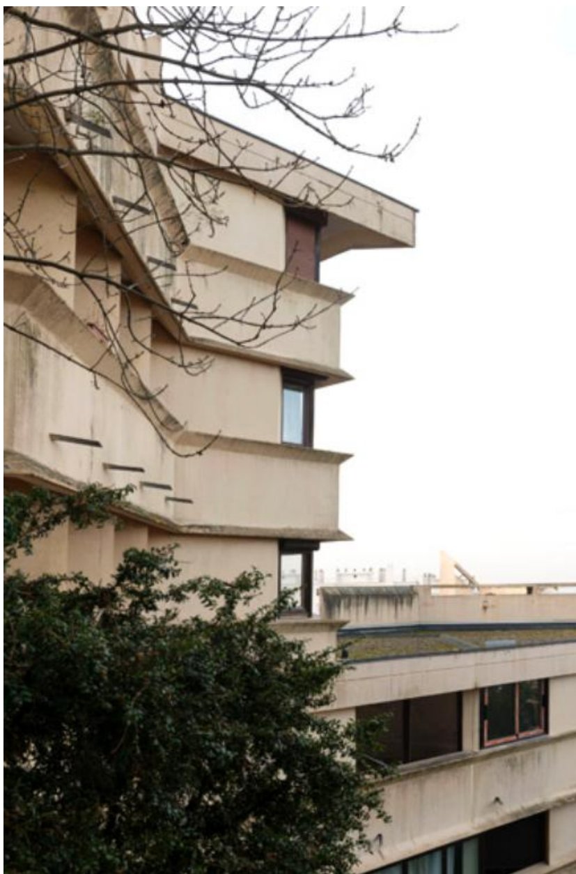
Détail de la vue latérale de l'immeuble.
