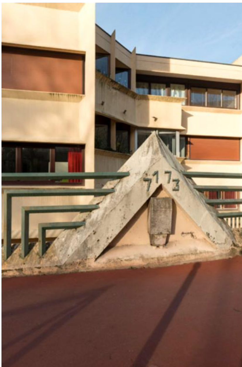
Vue frontale de l'élément portant le numéro de la rue.
