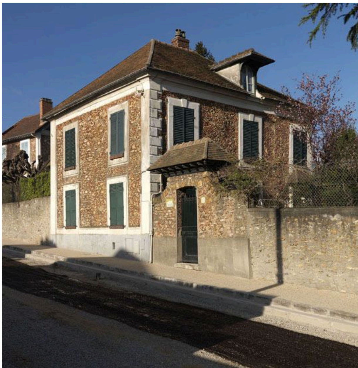
La façade principale.
