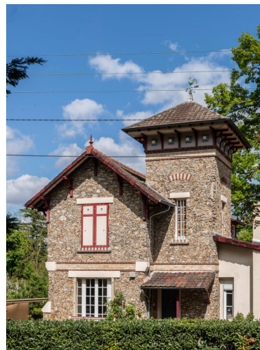
La façade principale côté chemin de la Nourrée. Phot. Kruszyk Laurent IVR11_20247800267NUC4A
