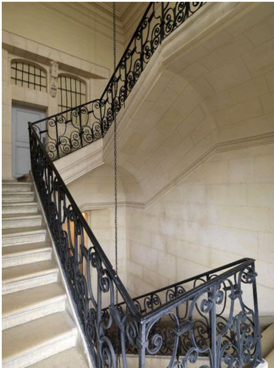
Vue d'ensemble d'une volée de cet escalier suspendu sur voûte de pierre.
