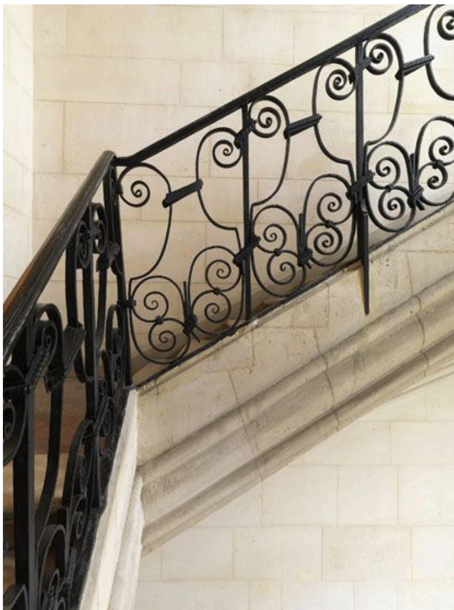
Détail des panneaux de balustres.
