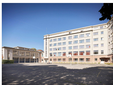
Le plan en U de l'établissement, autour d'une grande cour, est directement calqué sur celui des lycées-modèles de Paris intra-muros, en particulier le lycée Camille-Sée, presque contemporain (1934). Phot. Stéphane Asseline
