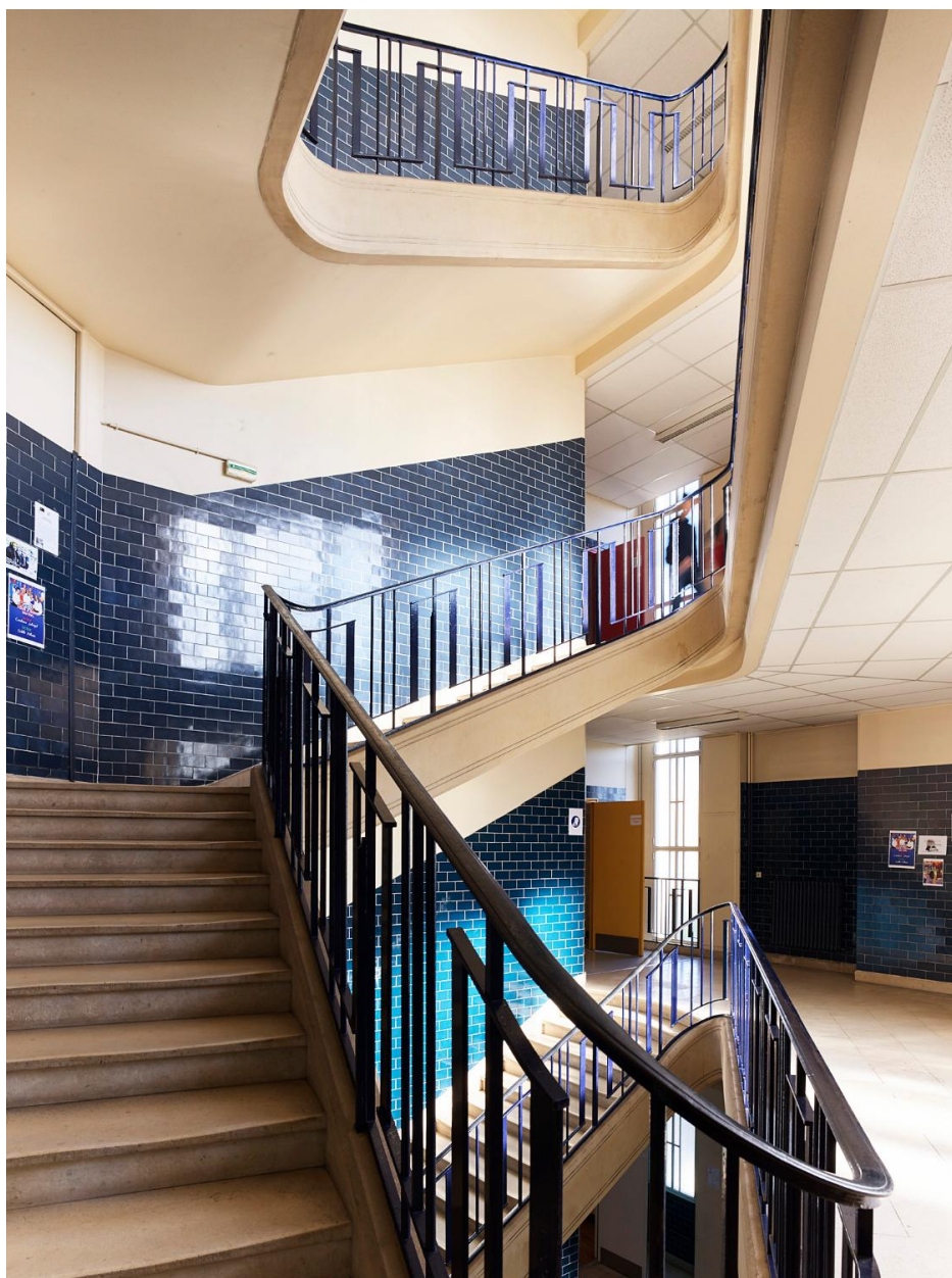
Vue générale des escaliers qui desservent les étages et les salles de classes.
