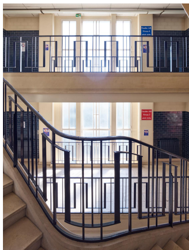
Les rampes d'appui des escaliers et les garde-corps des paliers sont particulièrement travaillés bien que décorés de motifs simples et géométriques. Phot. Stéphane Asseline IVR11_20189400517NUC6A
