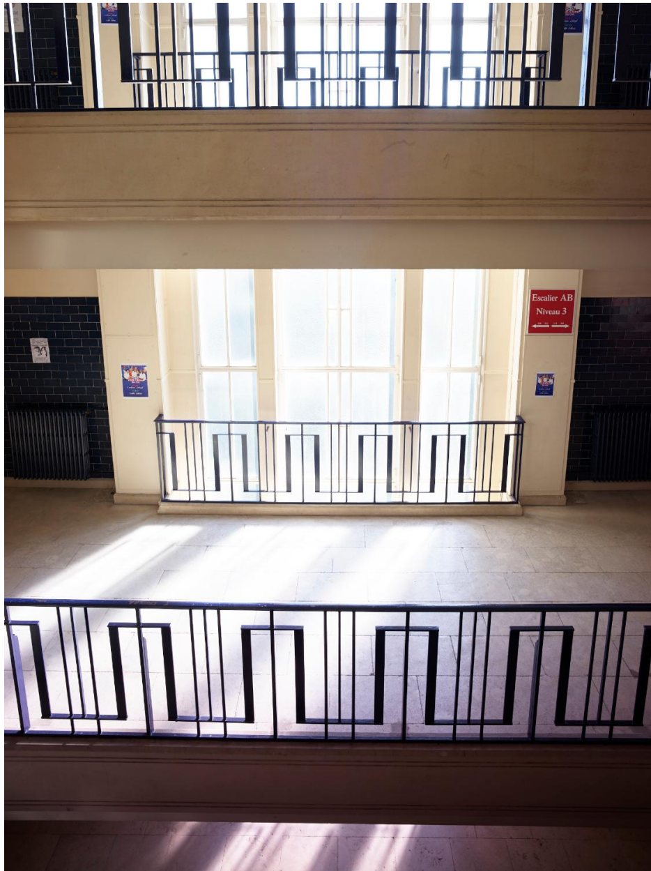
Détail des motifs des garde-corps et des rampes d'appui des escaliers.
