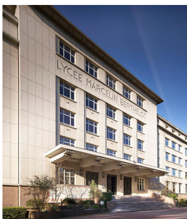
L'entrée du lycée est signalée par un perron surmonté d'une marquise. Il est desservi par un escalier de douze marches en marbre. Phot. Stéphane Asseline IVR11_20189400485NUC6A
