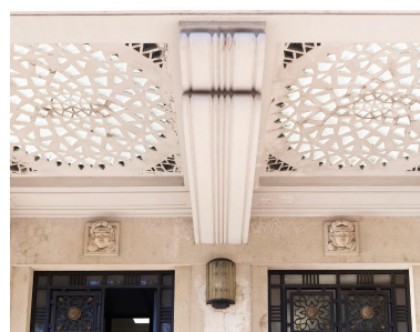
Détail de la marquise ajourée et des allégories sculptées de Bouchard : à droite les Sciences et à gauche, les Arts, avec une colonne dorique, un violon et une palette de peintures. Phot. Stéphane Asseline IVR11_20189400495NUC6A
