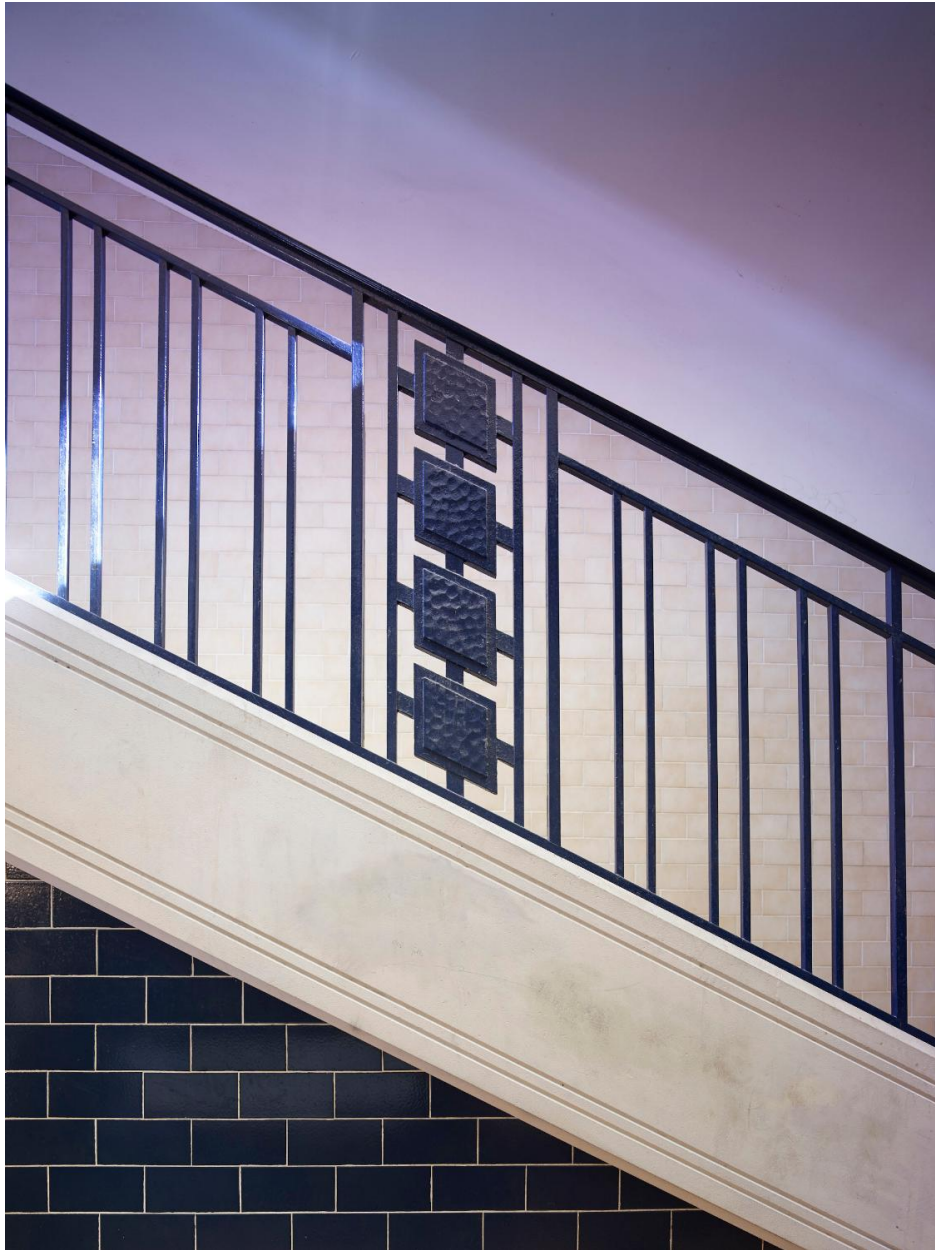
Détail d'un motif en fer forgé, sur l'une des rampes d'appui d'un escalier.
