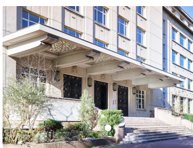
L'entrée de l'établissement, sous la marquise ajourée. Phot. Stéphane Asseline IVR11_20189400497NUC6A
