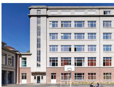
Les élévations se caractérisent par un parement de panneaux de mignonnette grise. Le calepinage de ces panneaux forme une grille de composition qui scande les façades, créant un rythme visuel. Phot. Stéphane Asseline
