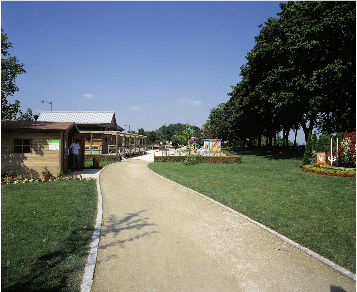
Les bâtiments situés à l'entrée du jardin.
