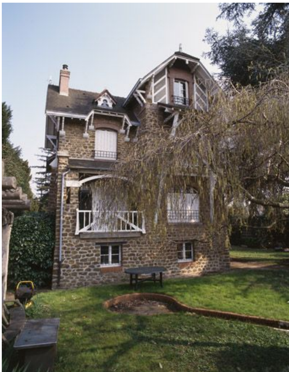
Maison, 9 avenue Libert. Vue de la façade tournée vers le quai des Dames.
