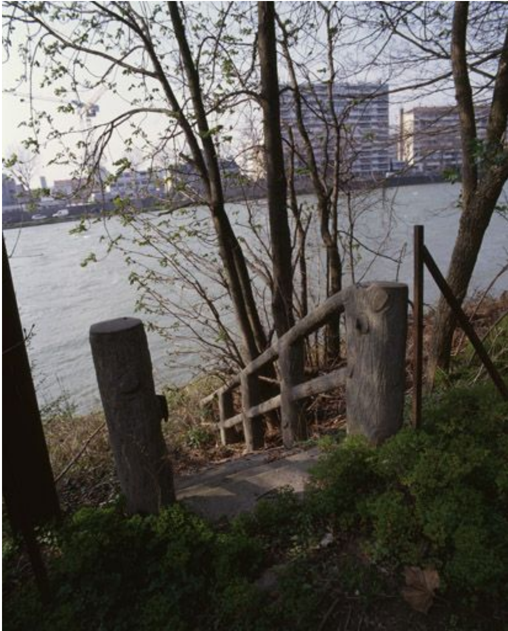
Maison située au 19, avenue Libert : l'escalier édifié sur le talus du chemin de contre-halage, aujourd'hui quai des Dames. Le ciment des rambardes imite le bois écoté.
