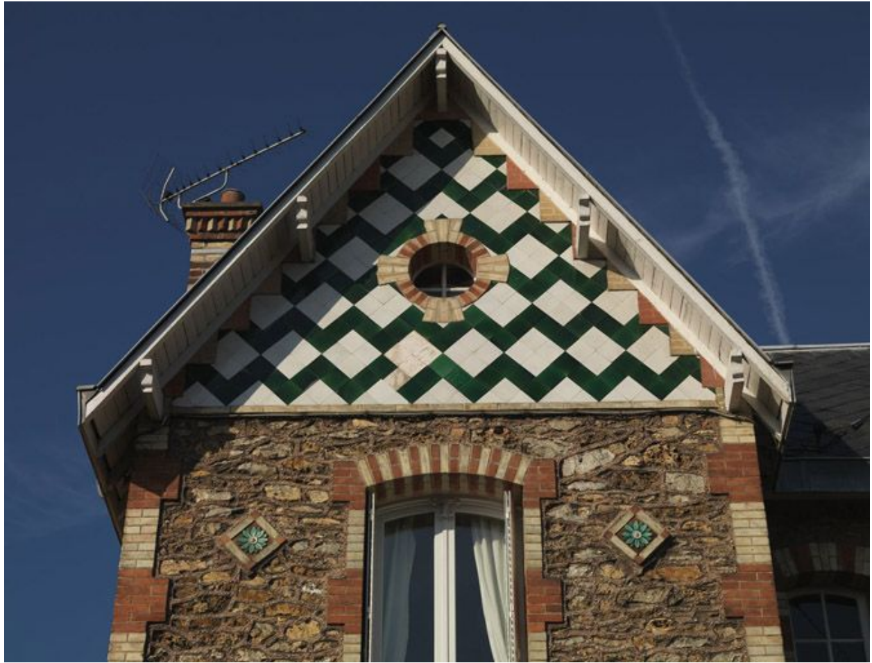
Détail du pignon de la maison, 31 avenue Emile-Fruchart. Des carreaux de céramique identiques ornent le surcroît de la maison du 42, avenue de Bellevue.
