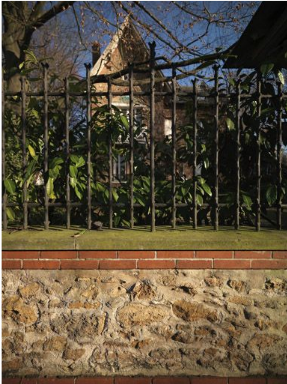
Maison, 34 avenue de Bellevue. Détail de la grille surmontant le mur de clôture : les barreaux en ferronnerie imitent le bois écoté.
