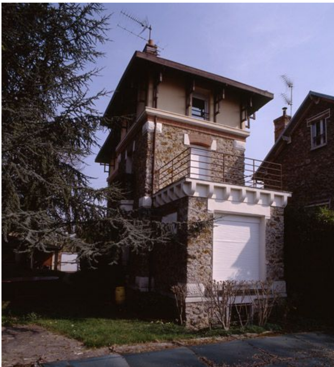
Vue d'ensemble d'une maison de la Villa-Draveil.
