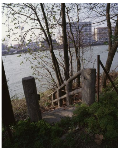
Maison située au 19, avenue Libert : l'escalier édifié sur le talus du chemin de contre-halage, aujourd'hui quai des Dames. Le ciment des rambardes imite le bois écoté.
