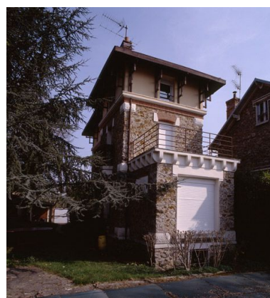
Vue d'ensemble d'une maison de la Villa-Draveil.
