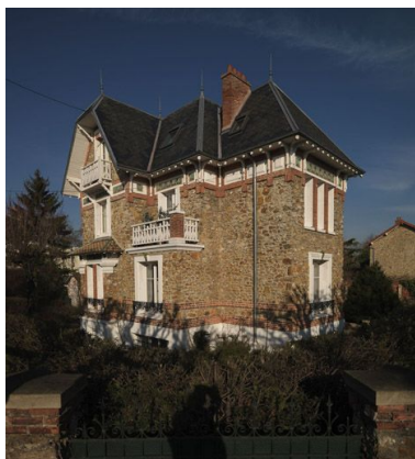
Vue d'ensemble de la maison à l'angle du 31 avenue Emile-Fruchart et du 13 avenue de Beauséjour.
