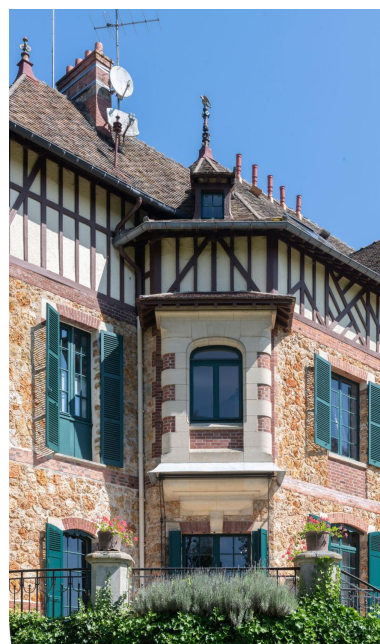
Corps de logis, fenêtre en encorbellement sur la façade principale
