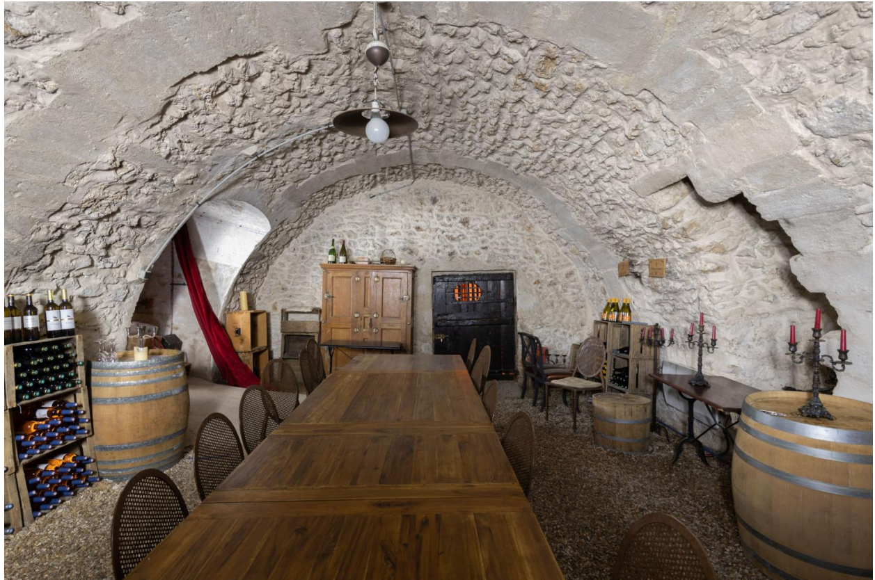
Cave semi-enterrée sous l'aile nord du bâtiment principal. Sa voûte en berceau est maintenue par des chaînages en pierre de taille.
