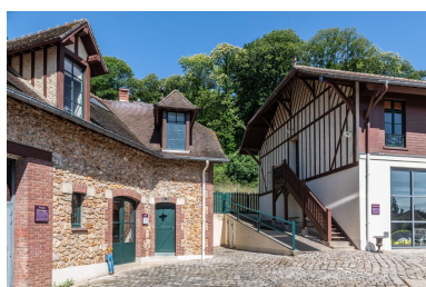
Cour arrière des communs. On aperçoit le bâtiment abritant la piscine. Phot. Laurent Kruszyk IVR11_20227800315NUC4A
