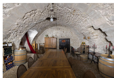
Cave semi-enterrée sous l'aile nord du bâtiment principal. Sa voûte en berceau est maintenue par des chaînages en pierre de taille. Phot. Laurent Kruszyk IVR11_20227800340NUC4A
