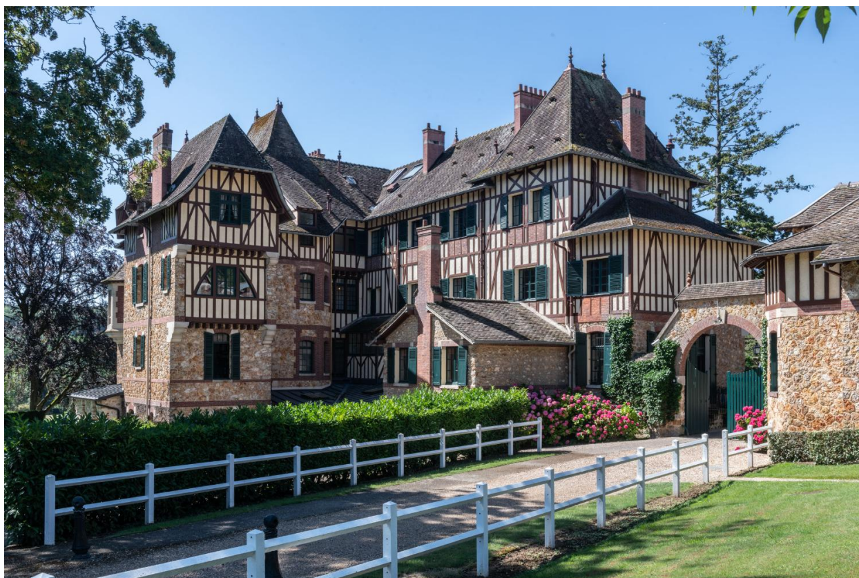
Entrée du domaine et façades arrières du corps de logis principal
