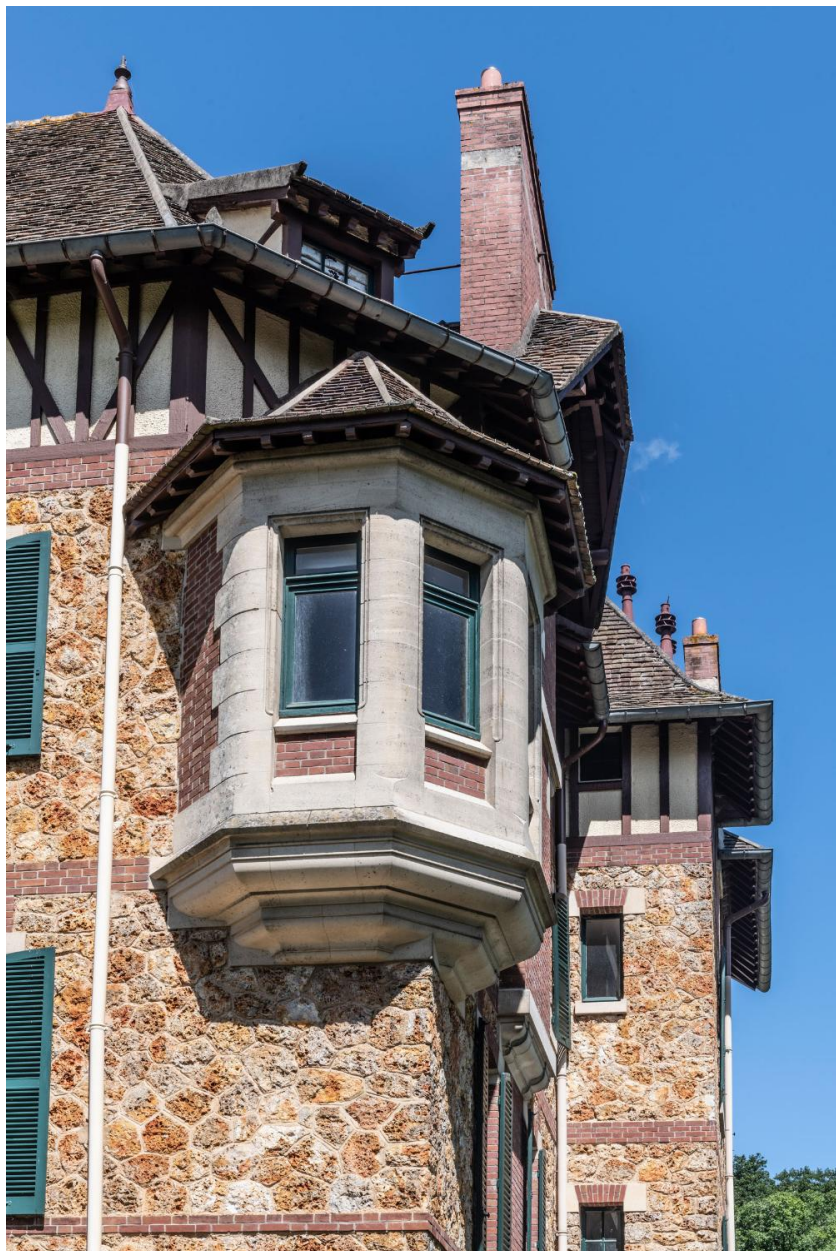
Détail de la façade principale, angle sud-est : échauguette
