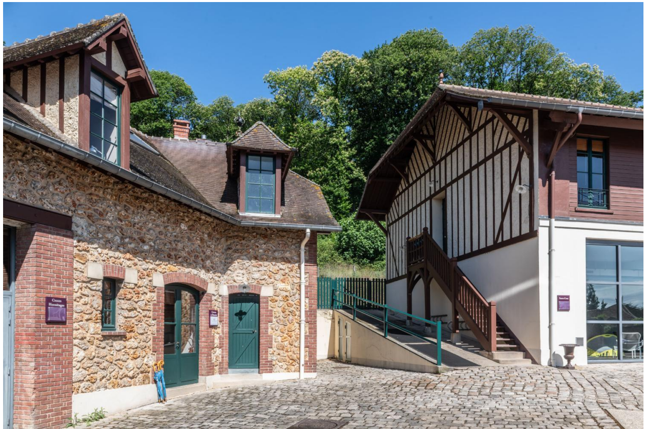
Cour arrière des communs. On aperçoit le bâtiment abritant la piscine.
