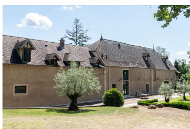
Façade arrière du théâtre Phot. Laurent Kruszyk IVR11_20227800314NUC4A
