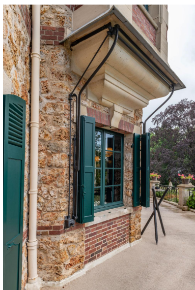
Le système de store d'origine a été conservé sur l'une des fenêtres du rez-de-chaussée.
