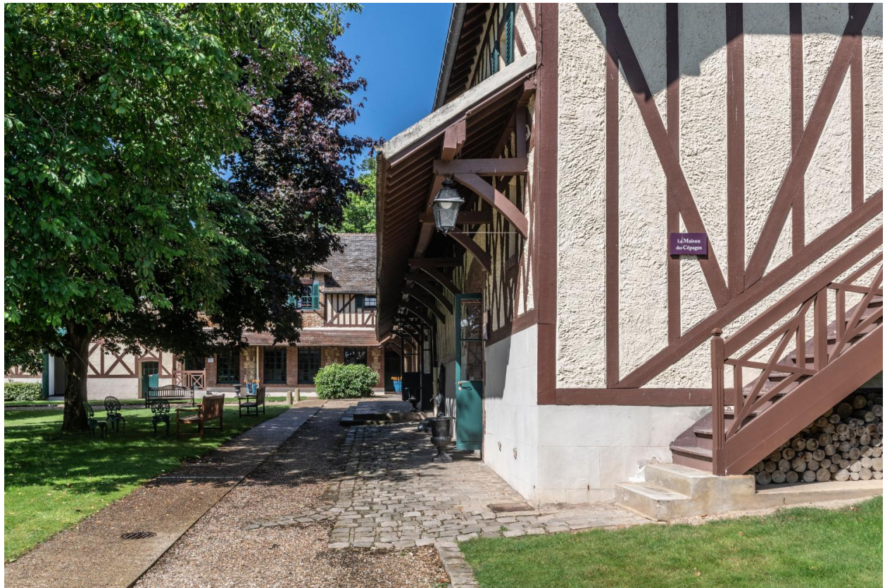
Dépendance coté nord de la cour. Départ de l'escalier droit extérieur.
