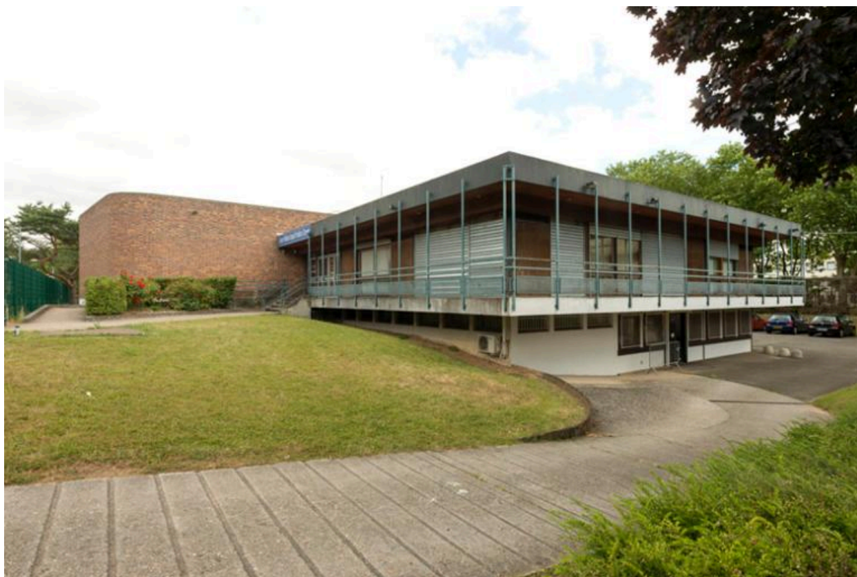
Vue du bâtiment sud du centre. Au fond le mur en brique de la salle de projection.
