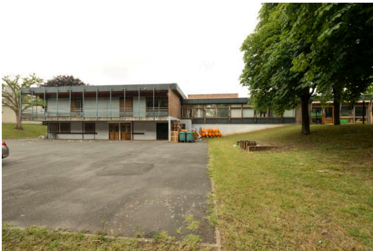
Vue de la façade arrière.
