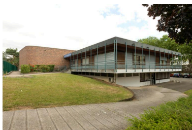
Vue du bâtiment sud du centre. Au fond le mur en brique de la salle de projection. Phot. Philippe Ayrault IVR11_20177800711NUC4A
