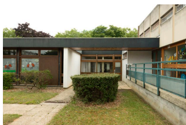
Portique faisant la jonction entre le centre social et la crèche. Phot. Philippe Ayrault IVR11_20177800713NUC4A
