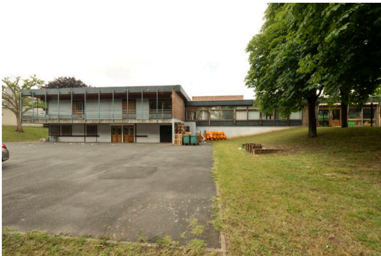
Vue de la façade arrière.
