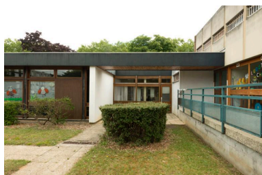
Portique faisant la jonction entre le centre social et la crèche. Phot. Philippe Ayrault IVR11_20177800713NUC4A
