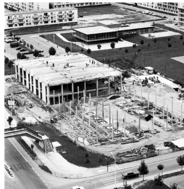
Vue d'ensemble du centre vers 1970. Au premier plan le gymnase-piscine en construction. (Fonds Bertin) Phot. Bertin IVR11_20177800546NUC2B
