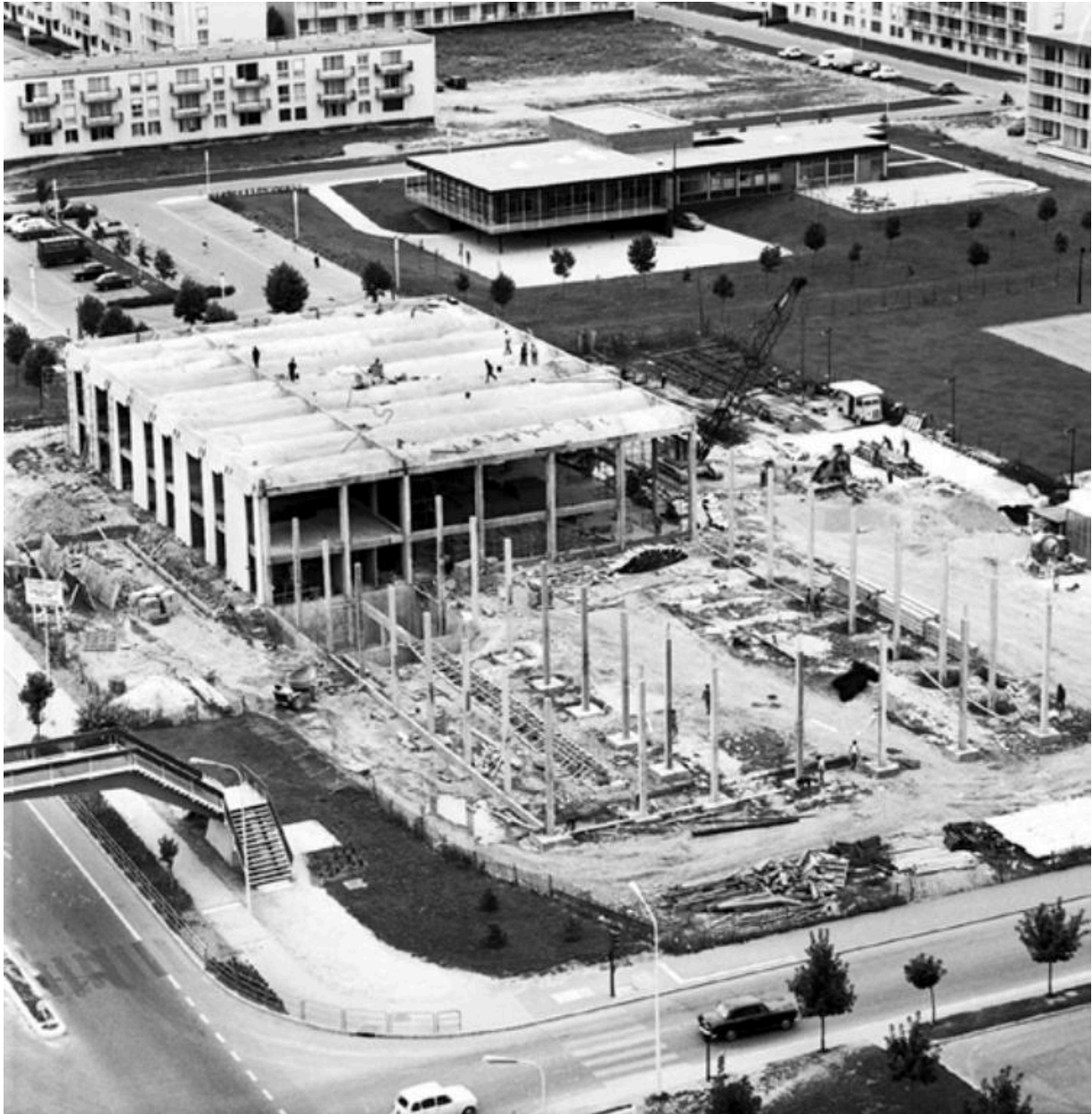
Vue d'ensemble du centre vers 1970. Au premier plan le gymnase-piscine en construction. (Fonds Bertin)
