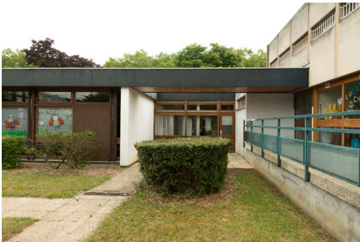
Portique faisant la jonction entre le centre social et la crèche.
