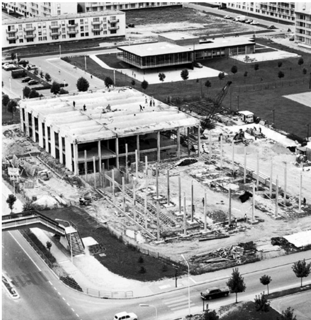
Vue d'ensemble du centre vers 1970. Au premier plan le gymnase-piscine en construction. (Fonds Bertin)
