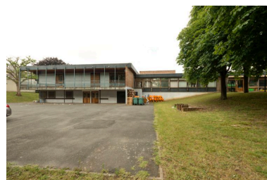
Vue de la façade arrière. Phot. Philippe Ayrault IVR11_20177800712NUC4A
