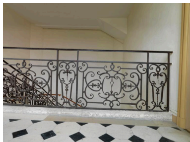
pilastres et panneau rectangulaire de la rampe d'appui. Phot. Laurent Kruszyk IVR11_20177800820NUC4A
