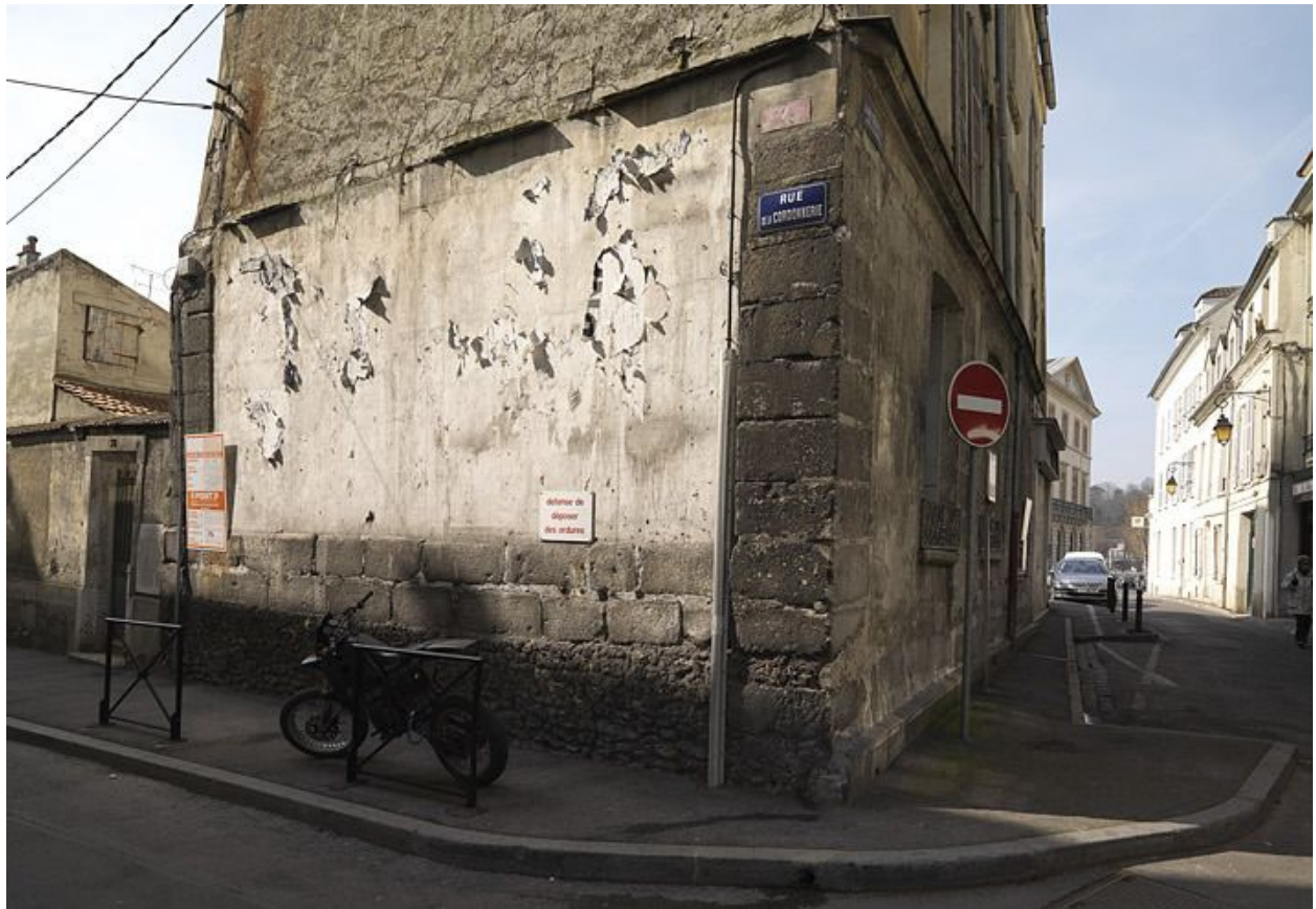
Détail de la mise en oeuvre du mur pignon oriental, avec ses gros blocs de grès.
