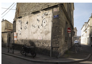
Détail de la mise en oeuvre du mur pignon oriental, avec ses gros blocs de grès. Phot. Stéphane Asseline IVR11_20097700277NUC4A
