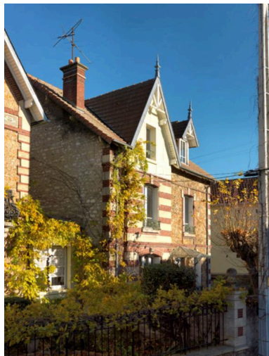
Façade de la maison. Phot. Philippe Ayrault IVR11_20167800802NUC4A
