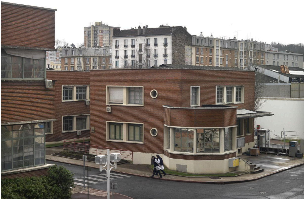
Site Sanofi. Vue extérieure du bâtiment d'accueil.
