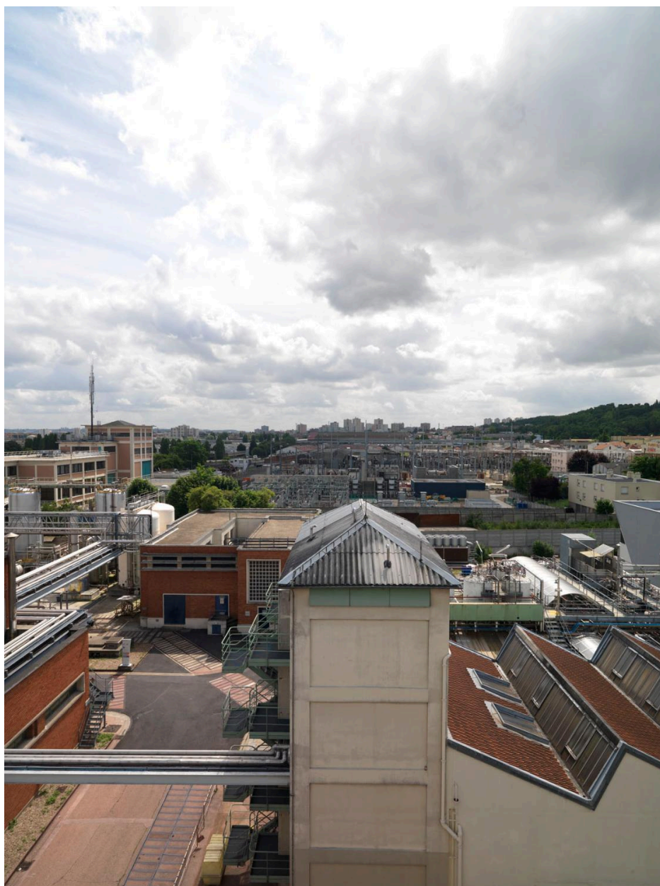
Site Sanofi. Vue des toits.
