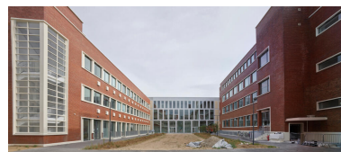
L'ancien site Roussel-UCLAF regroupant aujourd'hui la fondation Fiminco et le FRAC Île-de-France. Phot. Asseline Stéphane IVR11_20209300647NUC4A
