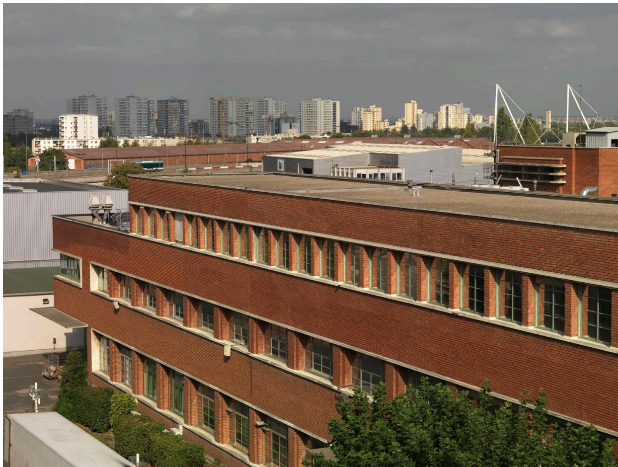
Site Sanofi. Vue du bâtiment de la recherche, depuis le toit de la chaufferie.
