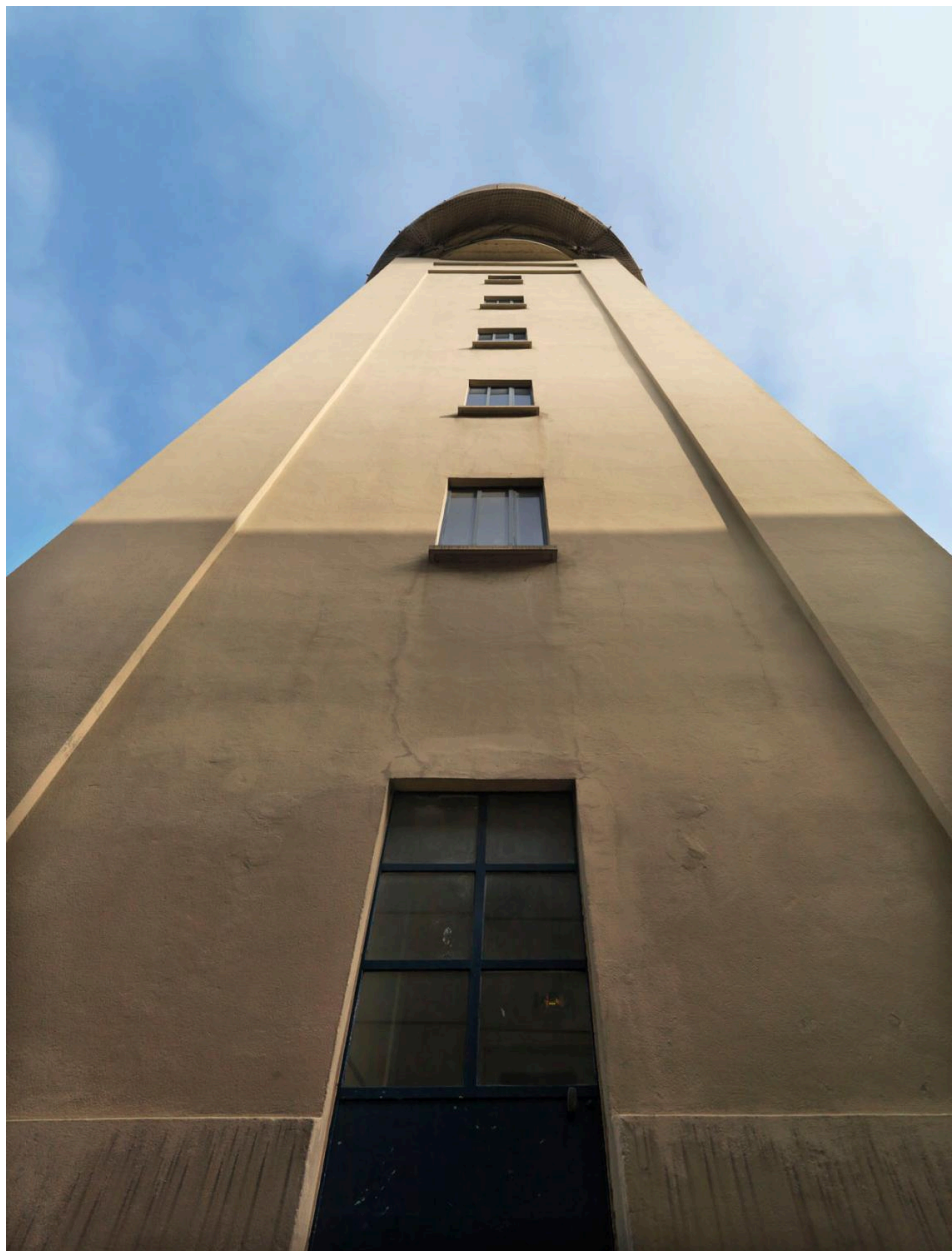
Site Biocitech. Vue du château d'eau depuis sa base.
