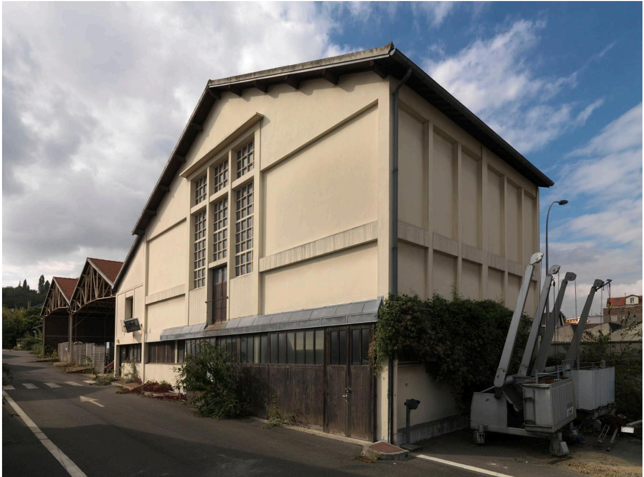
Site Biocitech. Vue des bâtiments désaffectés.
