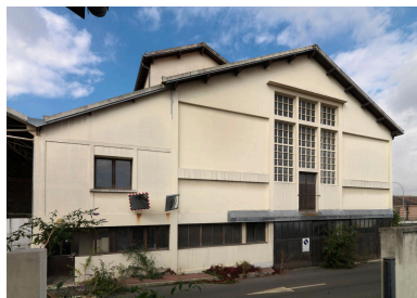
Site Biocitech. Vue des bâtiments désaffectés. Phot. Laurent Kruszyk IVR11_20099300478NUC4A
