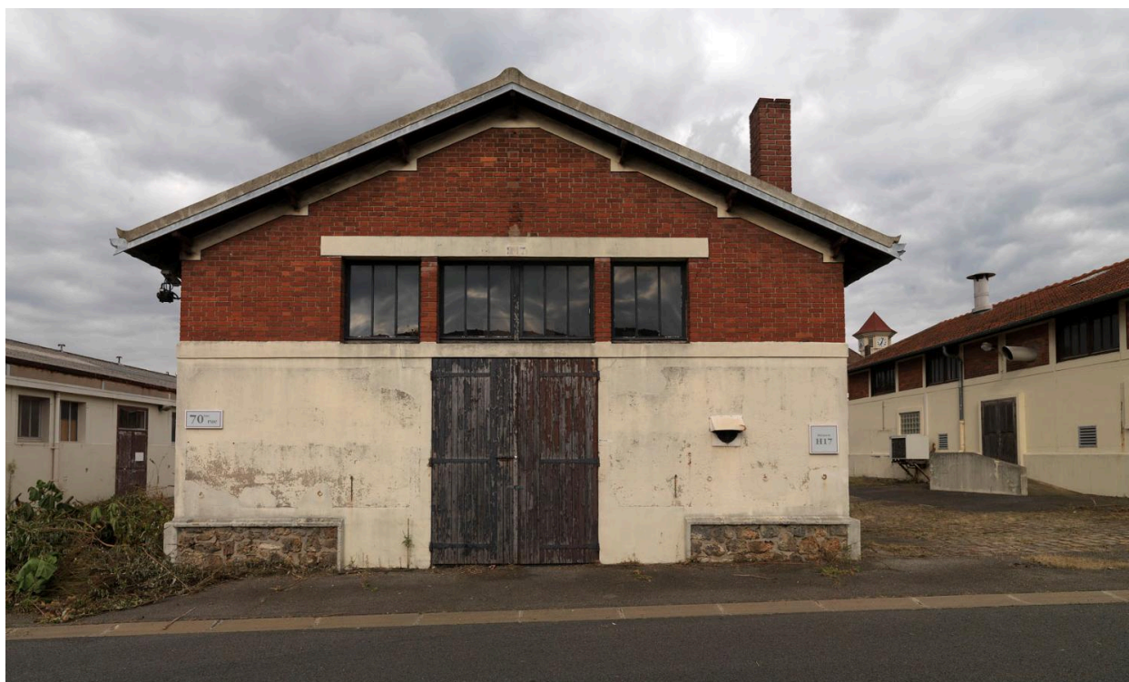
Site Biocitech. Vue des écuries désaffectées.
