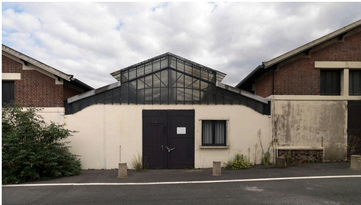
Site Biocitech. Bâtiment éclairé par un lanterneau.
