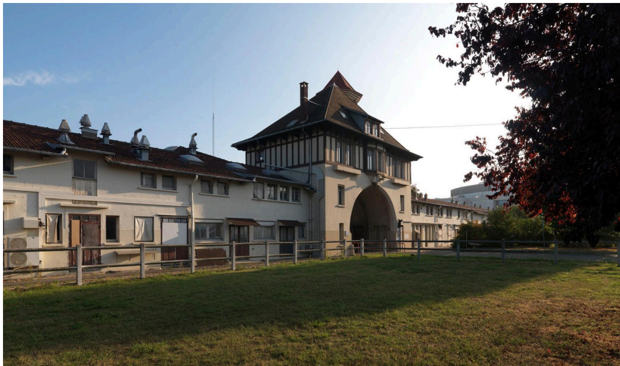
Site Biocitech. Vue de l'entrée-porche monumentale dite Tour de l'Horloge et des enclos.
