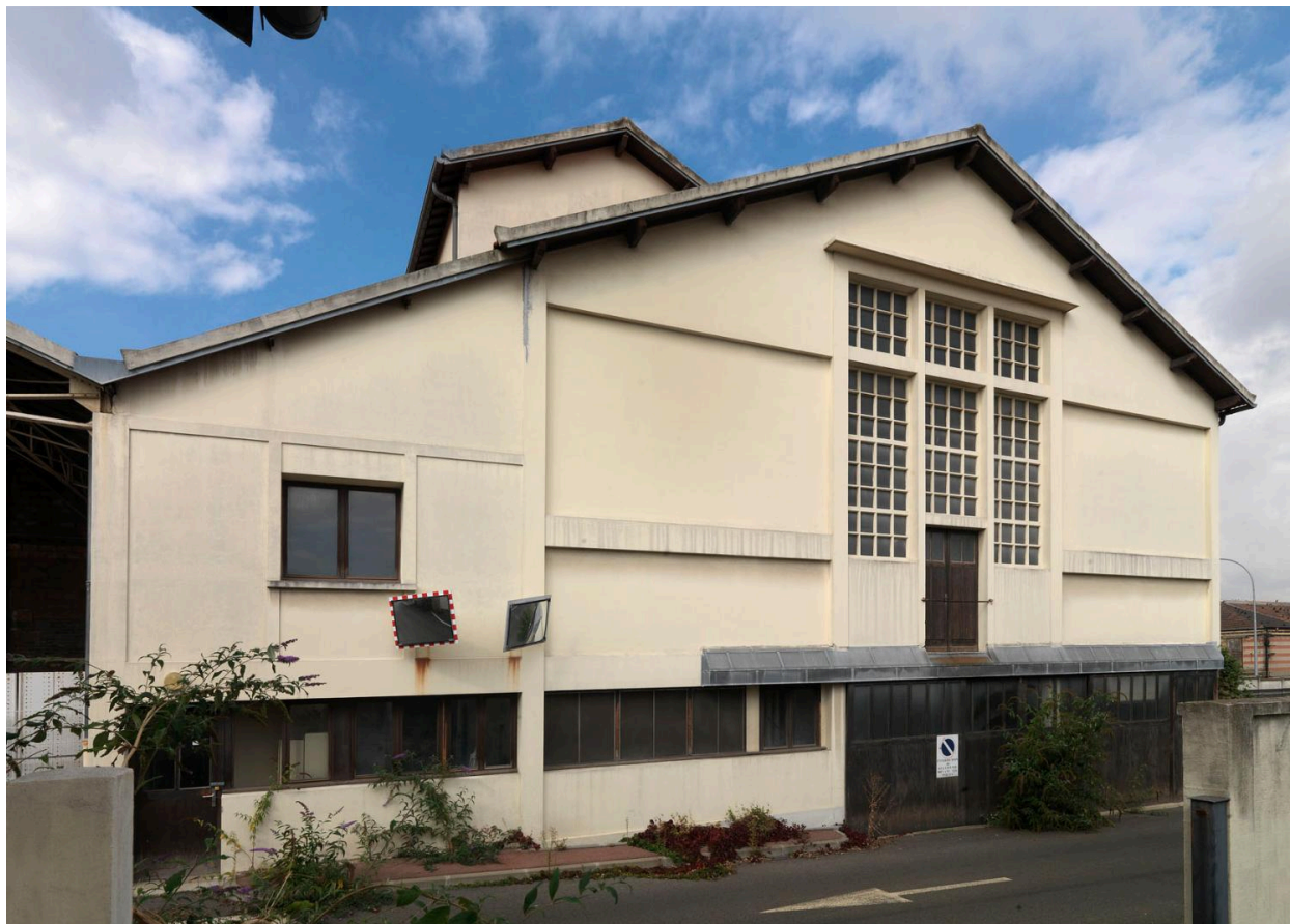
Site Biocitech. Vue des bâtiments désaffectés.
