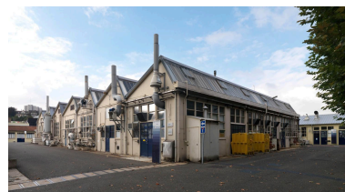
Site Biocitech, vue des bâtiments de production. Phot. Laurent Kruszyk IVR11_20099300483NUC4A
