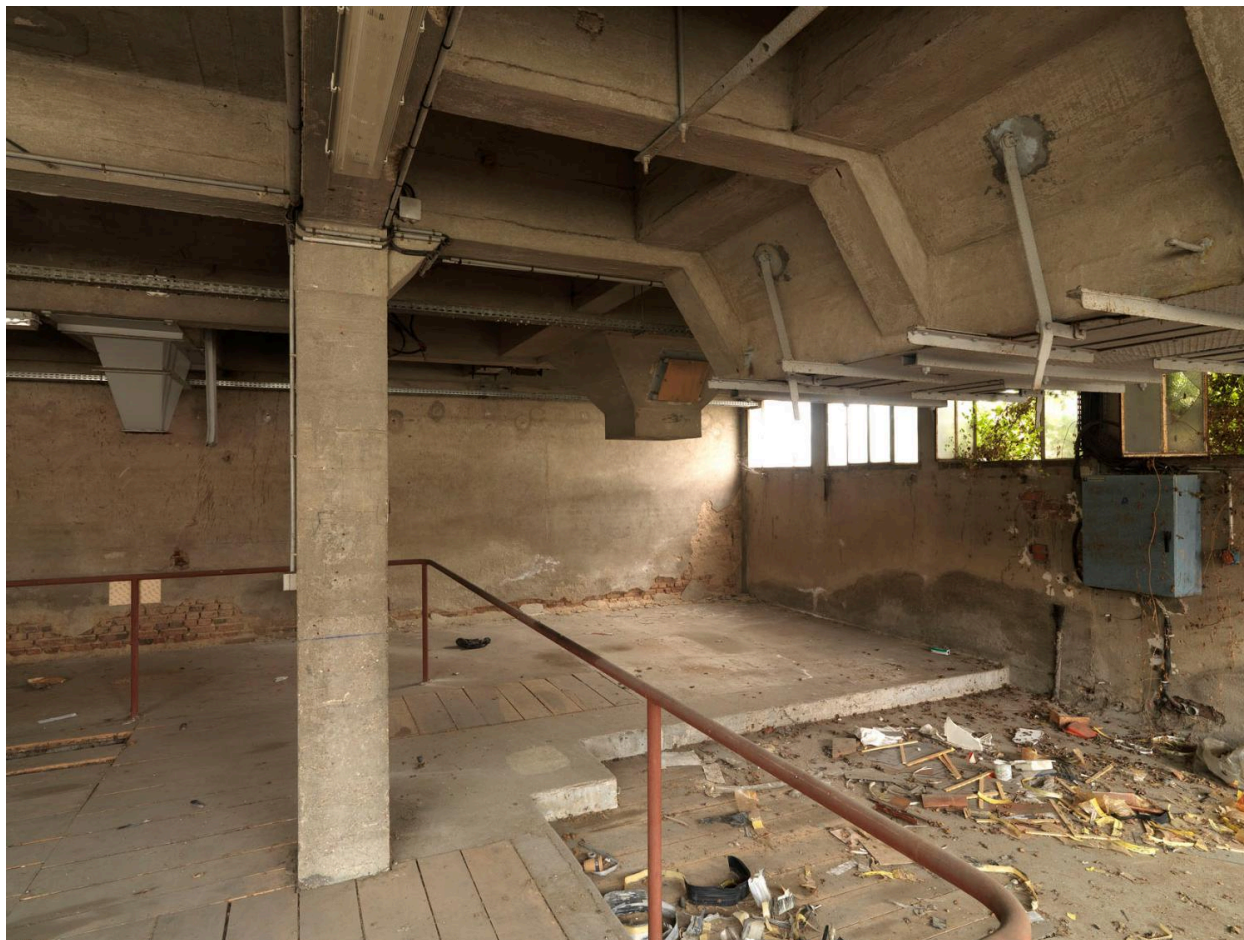
Site Biocitech. Vue intérieure des bâtiments désaffectés.
