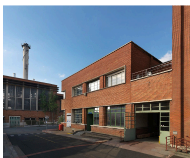
Site Sanofi, vue du bâtiment renfermant les cuves de fermentation. Bâtiment de la chaufferie en fond. Phot. Laurent Kruszyk IVR11_20099300537NUC4A
