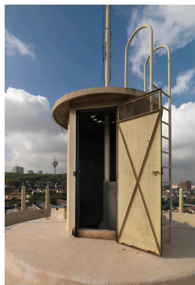
Site Biocitech. Vue du sommet du château d'eau. Phot. Laurent Kruszyk IVR11_20099300498NUC4A
