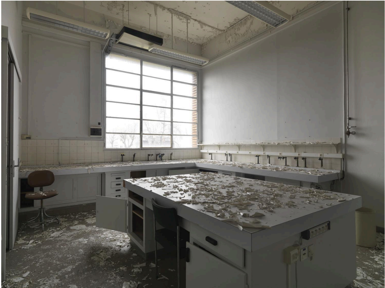
Site Sanofi. Vue des laboratoires. Bâtiment Nocard.
