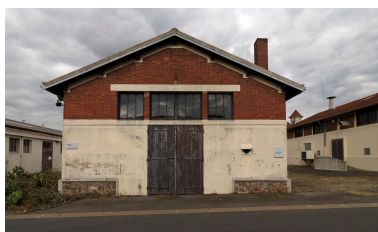
Site Biocitech. Vue des écuries désaffectées. Phot. Laurent Kruszyk IVR11_20099300473NUC4A
