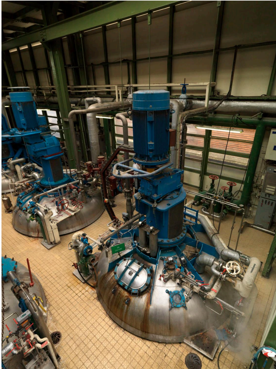
Site Sanofi. Bâtiment de transformation. Cuves.
