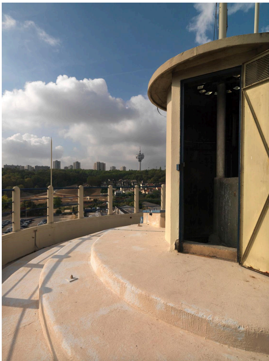
Site Biocitech. Vue du sommet du château d'eau.
