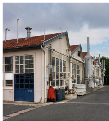
Site Biocitech, vue des bâtiments de production. Phot. Laurent Kruszyk IVR11_20099300485NUC4A
