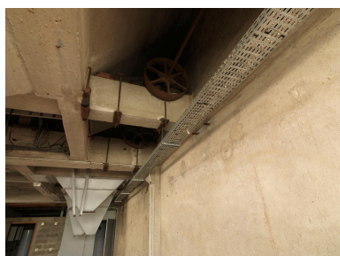
Site Biocitech. Vue intérieure des bâtiments désaffectés. Détail d'installation. Phot. Laurent Kruszyk IVR11_20099300481NUC4A
