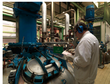
Site Sanofi. Bâtiment de transformation. Agent effectuant le contrôle d'une cuve. Phot. Laurent Kruszyk IVR11_20099300336NUC4A
