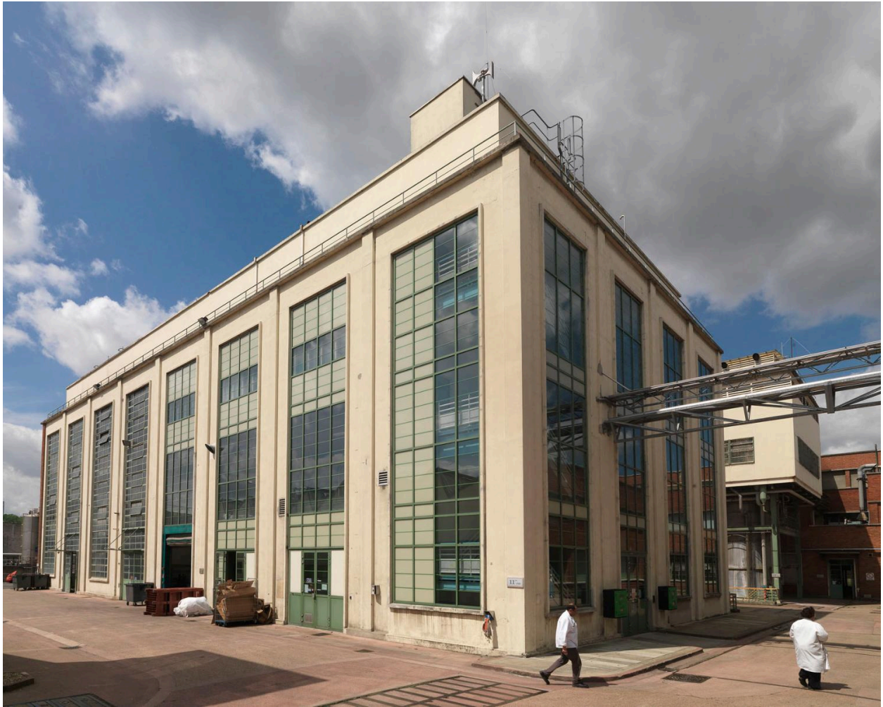
Site Sanofi. Vue du bâtiment de transformation.
