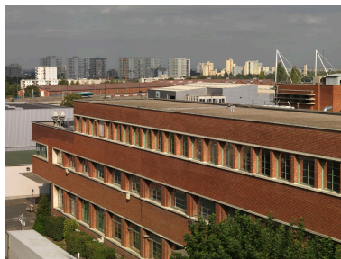
Site Sanofi. Vue du bâtiment de la recherche, depuis le toit de la chaufferie. Phot. Laurent Kruszyk IVR11_20099300525NUC4A
