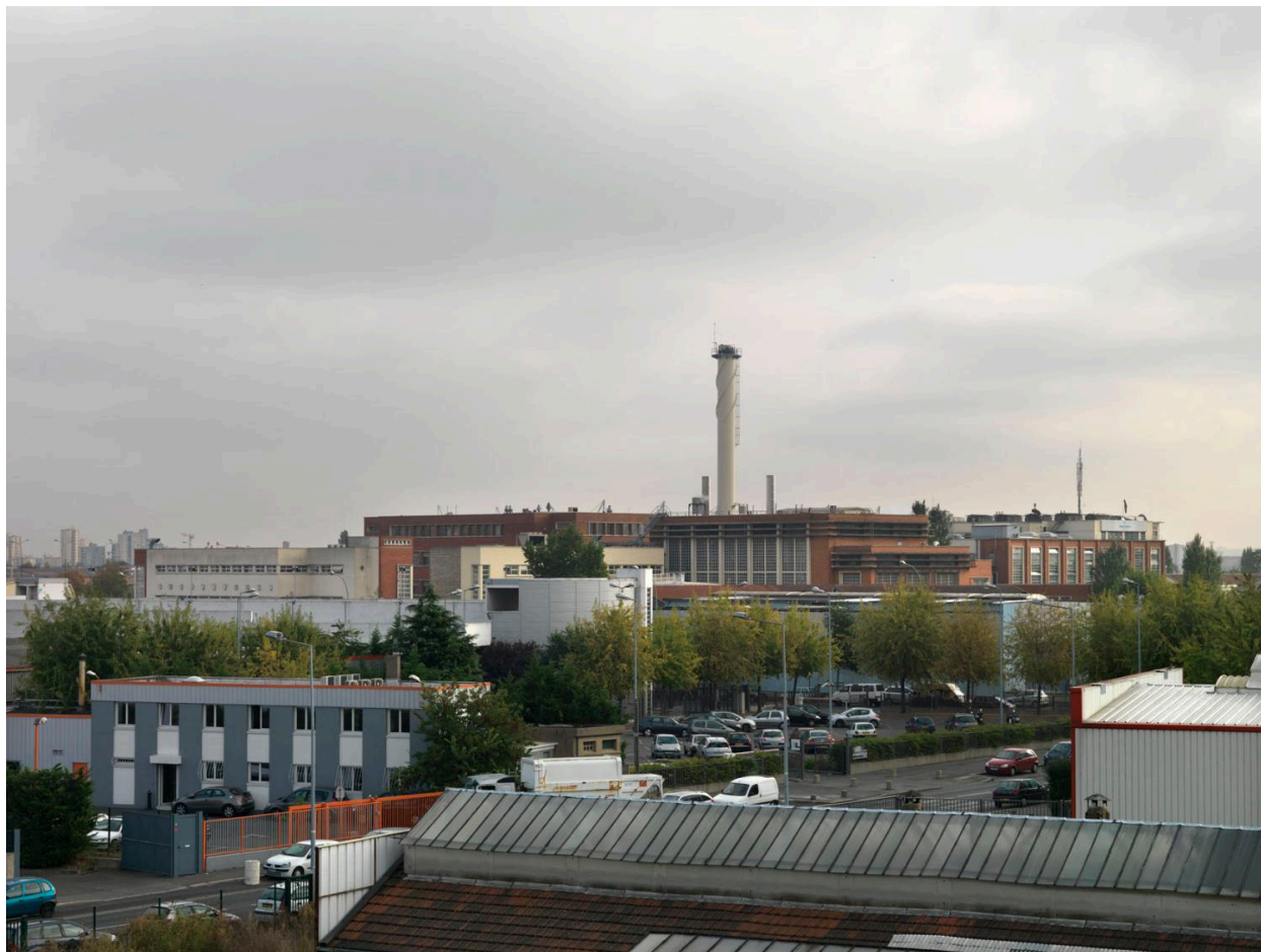
Site Sanofi. Vue générale du site.
