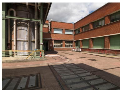
Site Sanofi. Vue des circulations intérieures entre les bâtiments de transformation. Phot. Laurent Kruszyk IVR11_20099300313NUC4A
