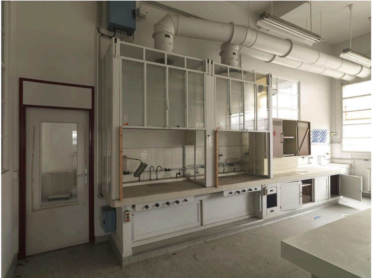
Site Sanofi. Vue des laboratoires. Bâtiment Nocard.
