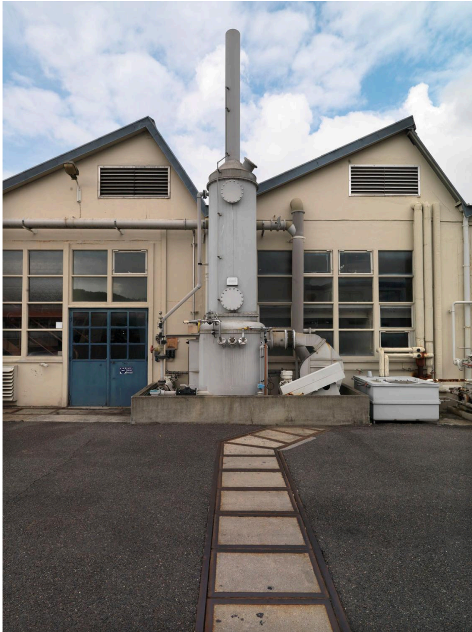
Site Biocitech, vue rapprochée d'un bâtiment de production et d'un équipement en façade.
