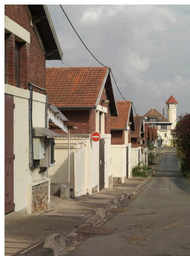
Site Biotech. Alignement des écuries de l'ancien site d'expérimentation animale de l'entreprise. Phot. Laurent Kruszyk
