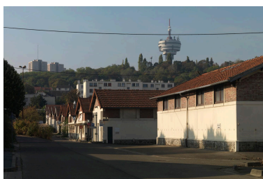
Site Biocitech. Alignement des écuries de l'ancien site d'expérimentation animale de l'entreprise. Phot. Laurent Kruszyk IVR11_20099300468NUC4A
