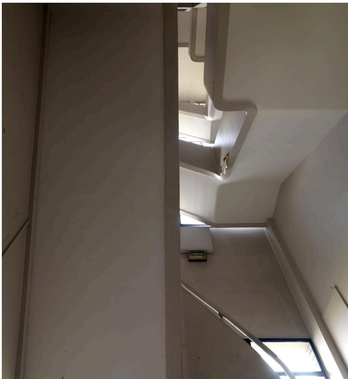
Site Sanofi. Escalier du bâtiment Nocard.
