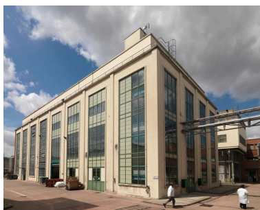
Site Sanofi. Vue du bâtiment de transformation. Phot. Laurent Kruszyk IVR11_20099300316NUC4A
