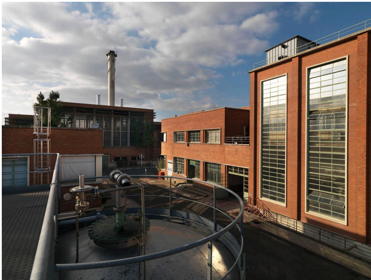
Site Sanofi, vue du bâtiment renfermant les cuves de fermentation.
