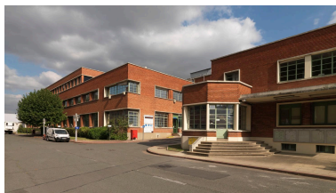
Site Sanofi. Vue du bâtiment de la direction. Phot. Laurent Kruszyk IVR11_20099300526NUC4A
