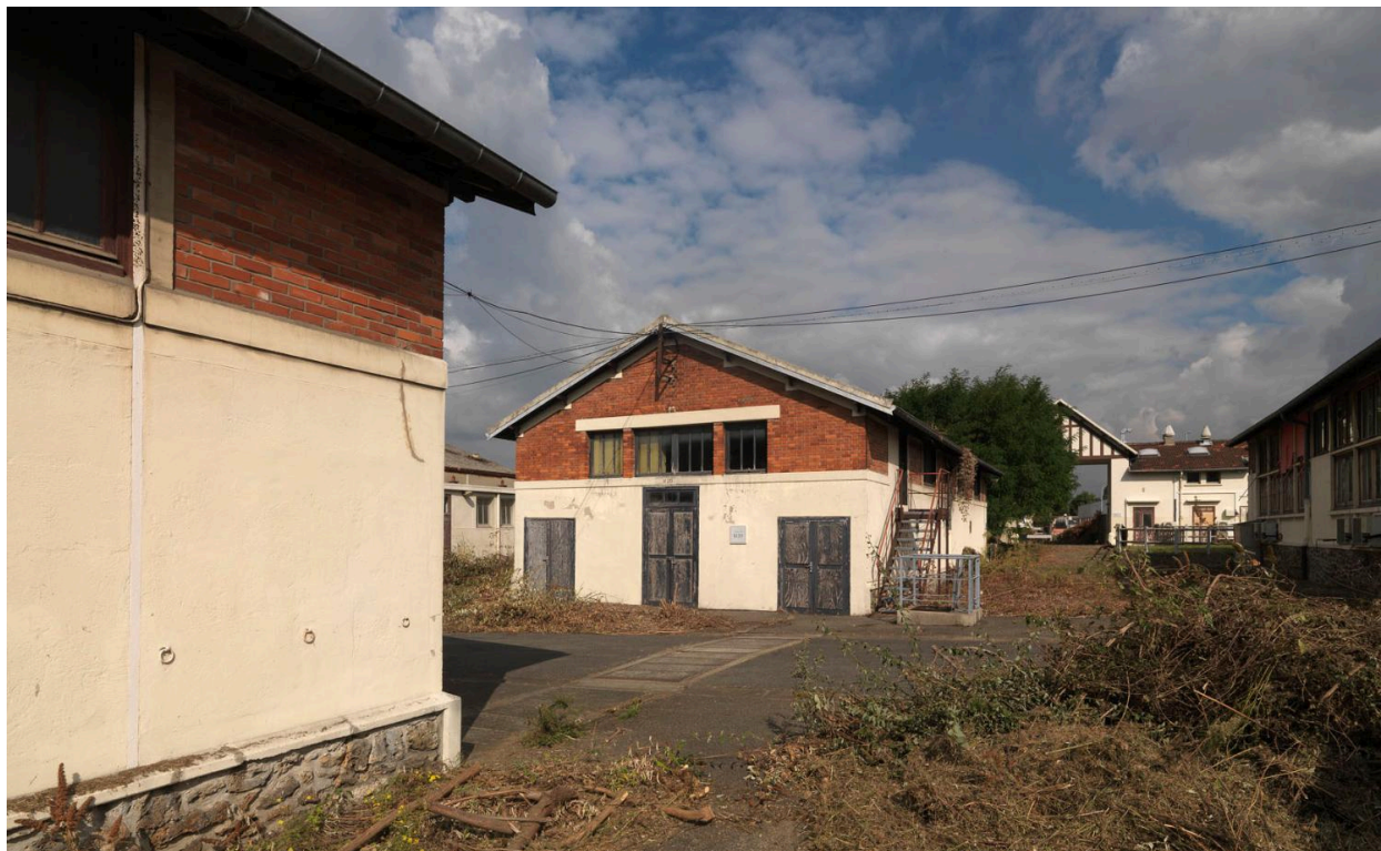
Site Biocitech. Vue des écuries désaffectées.
