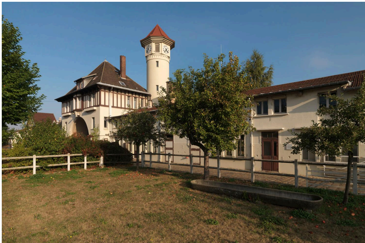
Site Biocitech. Vue de l'entrée-porche monumentale dite Tour de l'Horloge et des enclos.
