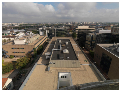
Site Biocitech. Vue générale du site depuis les toits. Phot. Laurent Kruszyk IVR11_20099300505NUC4A
