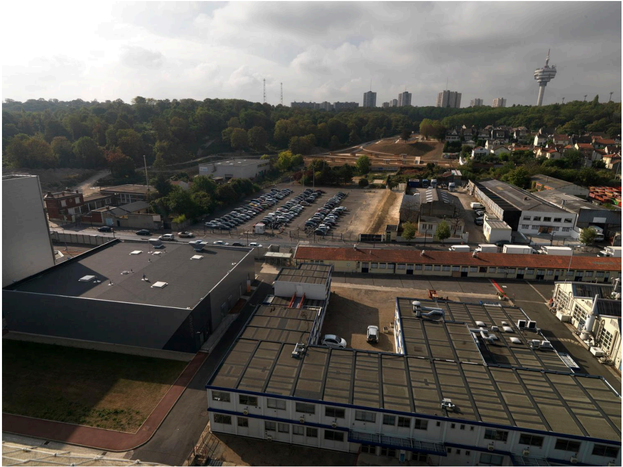
Site Biocitech. Vue générale du site depuis les toits.
