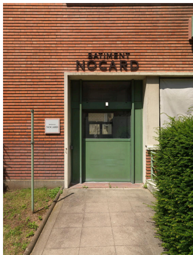
Site Sanofi. Entrée du bâtiment Nocard. Phot. Laurent Kruszyk IVR11_20099300304NUC4A
