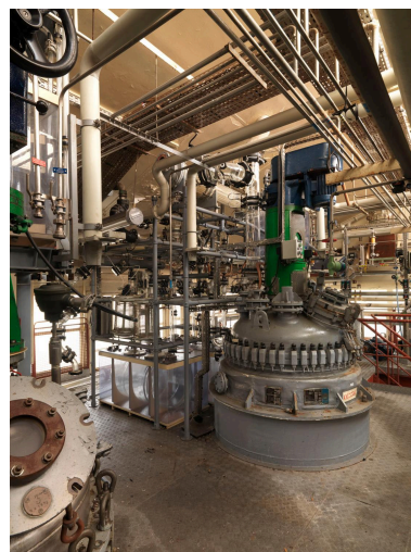
Site Biocitech, vue intérieure des équipements et machines. Phot. Laurent Kruszyk IVR11_20099300491NUC4A
