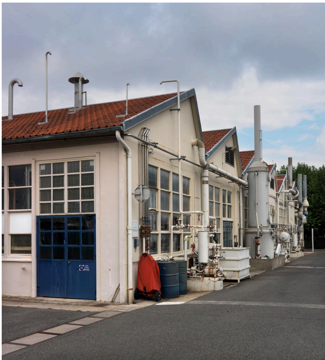
Site Biocitech, vue des bâtiments de production.
