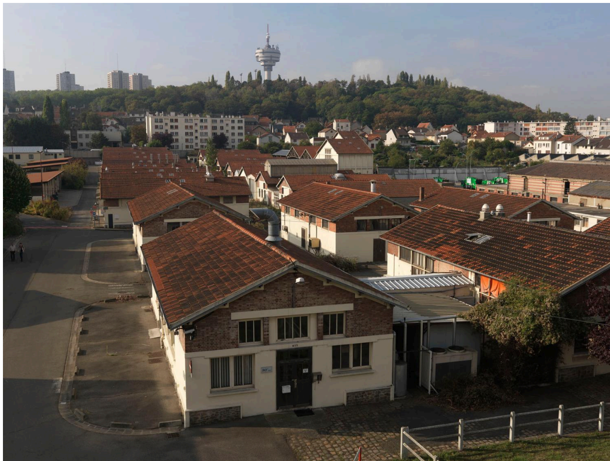
Site Biocitech. Vue générale.
