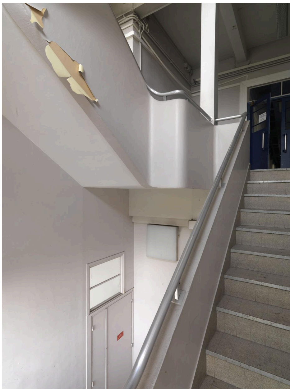
Site Sanofi. Escalier du bâtiment Nocard.
