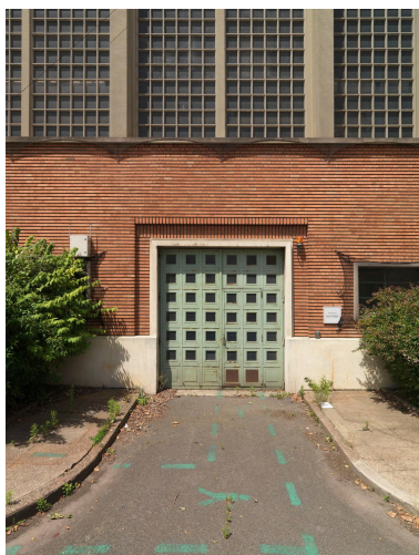
Site Sanofi. Vue de la portée d'entrée principale du bâtiment de la chaufferie. Phot. Laurent Kruszyk IVR11_20099300307NUC4A
