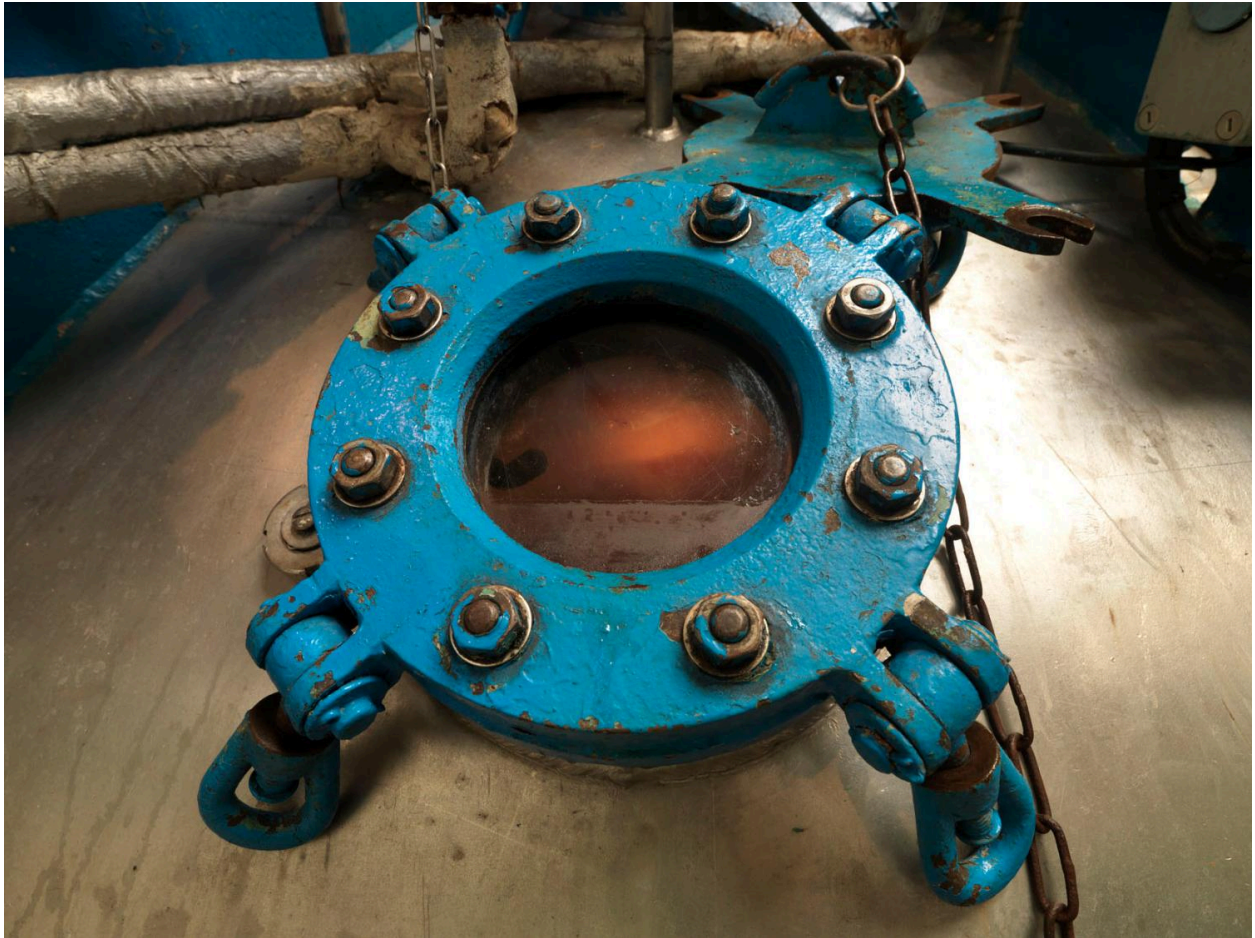
Site Sanofi. Bâtiment de transformation. Vue rapprochée d'une cuve.
