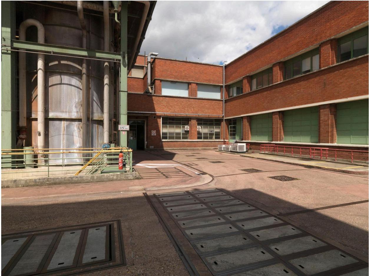
Site Sanofi. Vue des circulations intérieures entre les bâtiments de transformation.
