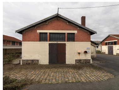
Site Biocitech. Vue des écuries désaffectées. Phot. Laurent Kruszyk IVR11_20099300474NUC4A
