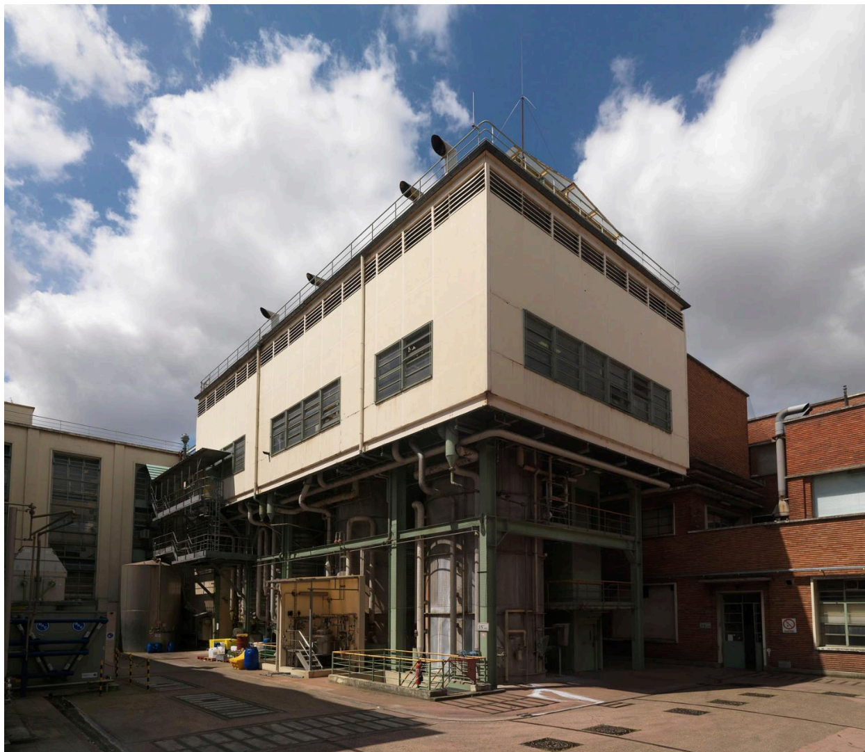
Site Sanofi. Vue d'un bâtiment de transformation.
