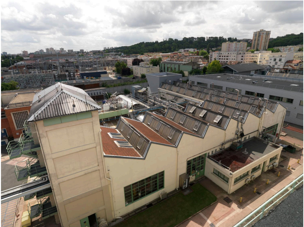
Site Sanofi. Vue des toits en shed.
