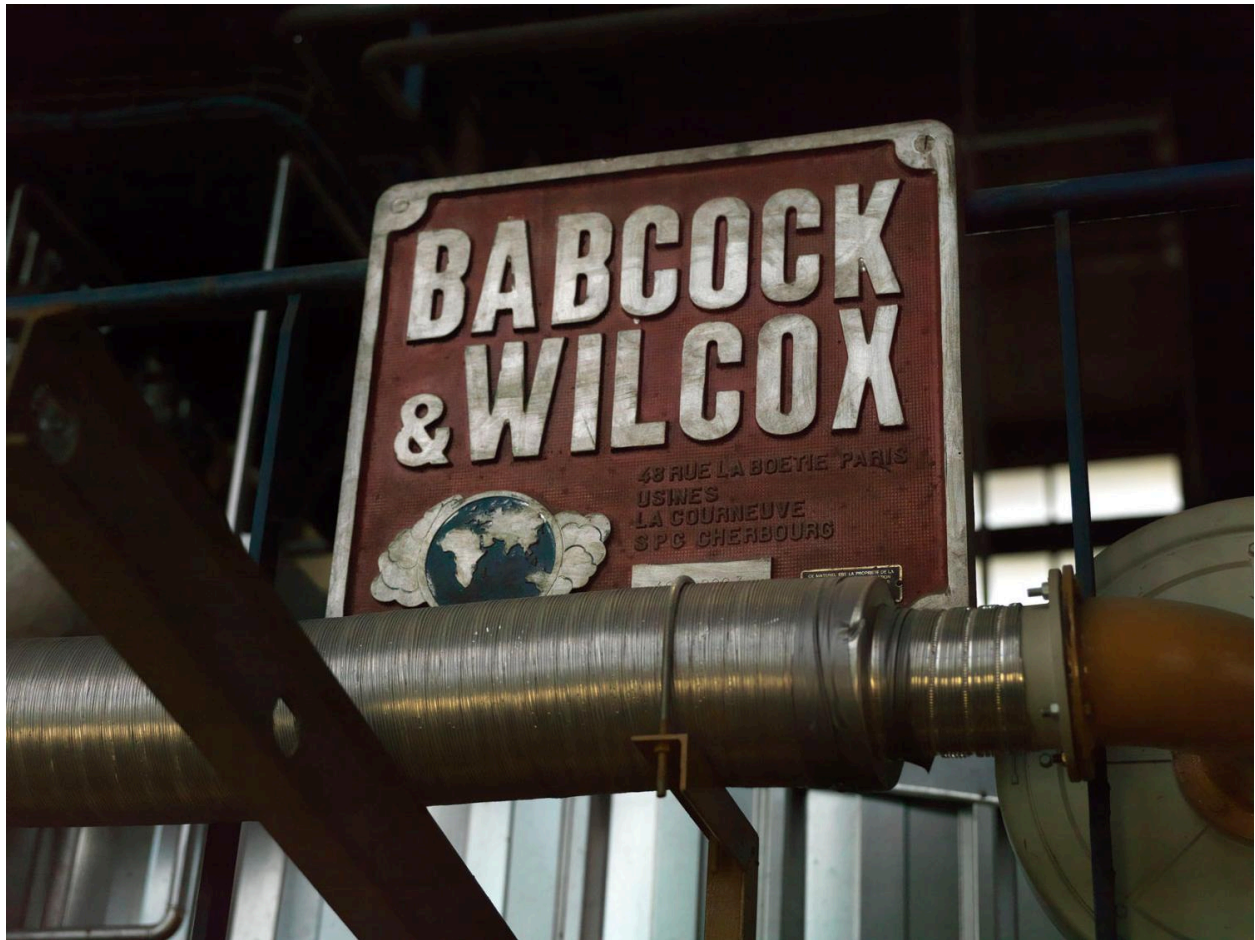
Site Sanofi. Plaque Bacoock et Wilcox, bâtiment de la chaufferie.
