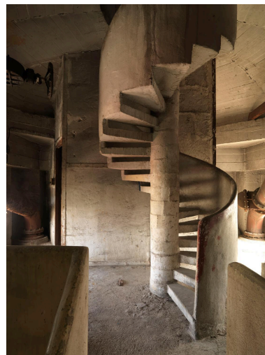
Site Biocitech. Vue de l'escalier du château d'eau. Phot. Laurent Kruszyk IVR11_20099300496NUC4A
