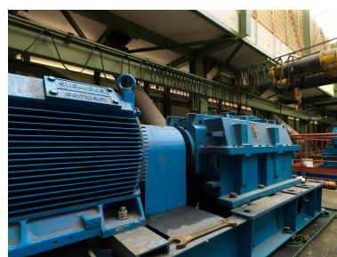
Site Sanofi. Bâtiment de transformation. Cuves. Phot. Laurent Kruszyk IVR11_20099300326NUC4A
