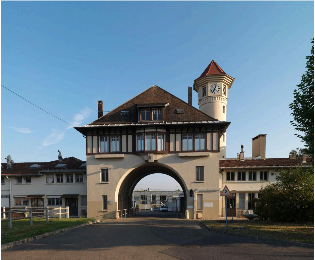
Site Biocitech. Vue de l'entrée-porche monumentale dite Tour de l'Horloge et des enclos.
