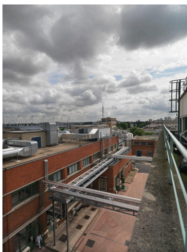
Site Sanofi. Vue depuis les toits des liaisons entre bâtiments. Phot. Laurent Kruszyk
