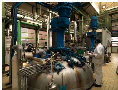
Site Sanofi. Bâtiment de transformation. Agent effectuant le contrôle d'une cuve. Phot. Laurent Kruszyk IVR11_20099300335NUC4A
