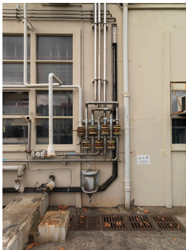
Site Biocitech, détail d'un équipement en façade. Phot. Laurent Kruszyk IVR11_20099300487NUC4A
