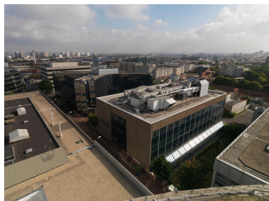
Site Biocitech. Vue générale du site depuis les toits. Phot. Laurent Kruszyk IVR11_20099300506NUC4A
