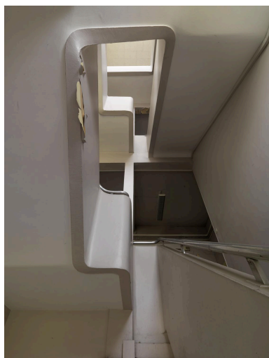
Site Sanofi. Escalier du bâtiment Nocard. Phot. Laurent Kruszyk
