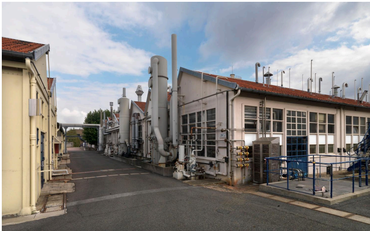
Site Biocitech, vue des rues intérieures.
