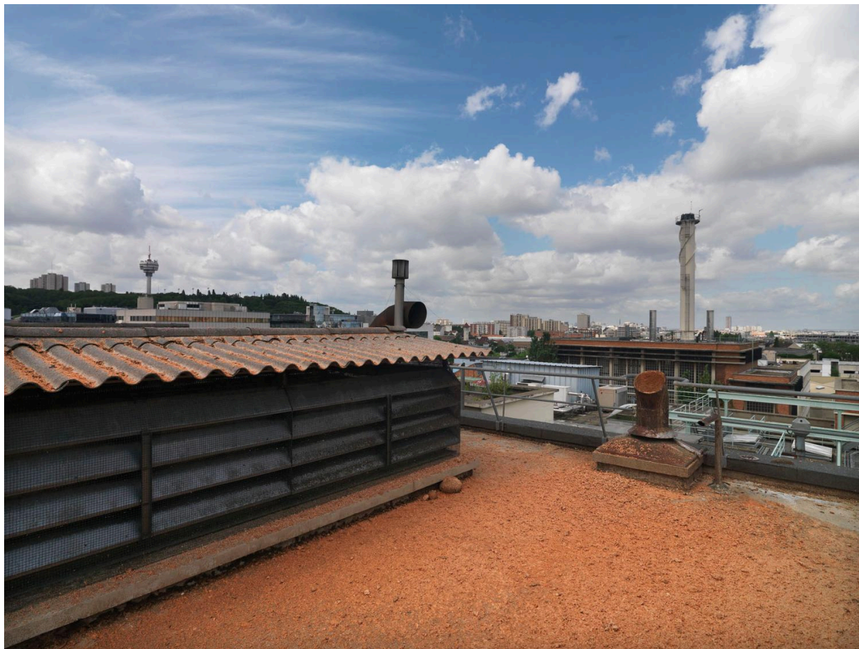
Site Sanofi. Vue des toits.
