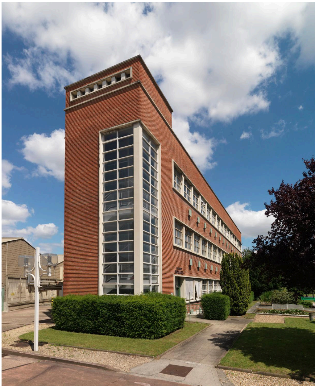
Site Sanofi. Vue extérieure. Bâtiment de la recherche.
