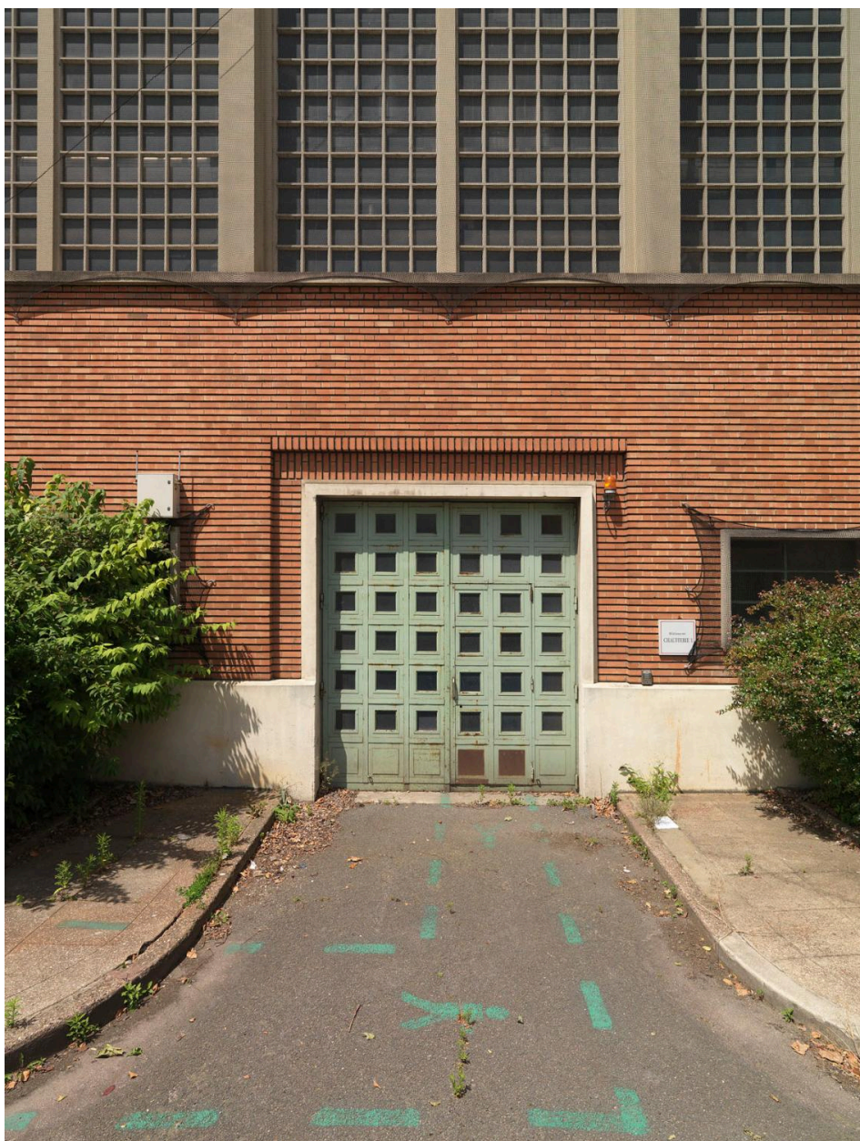
Site Sanofi. Vue de la portée d'entrée principale du bâtiment de la chaufferie.
