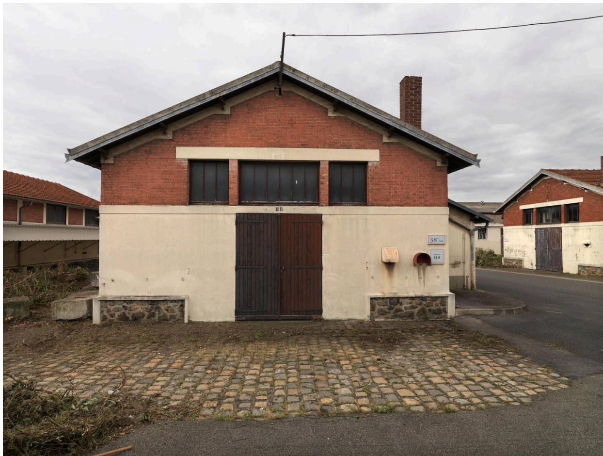
Site Biocitech. Vue des écuries désaffectées.
