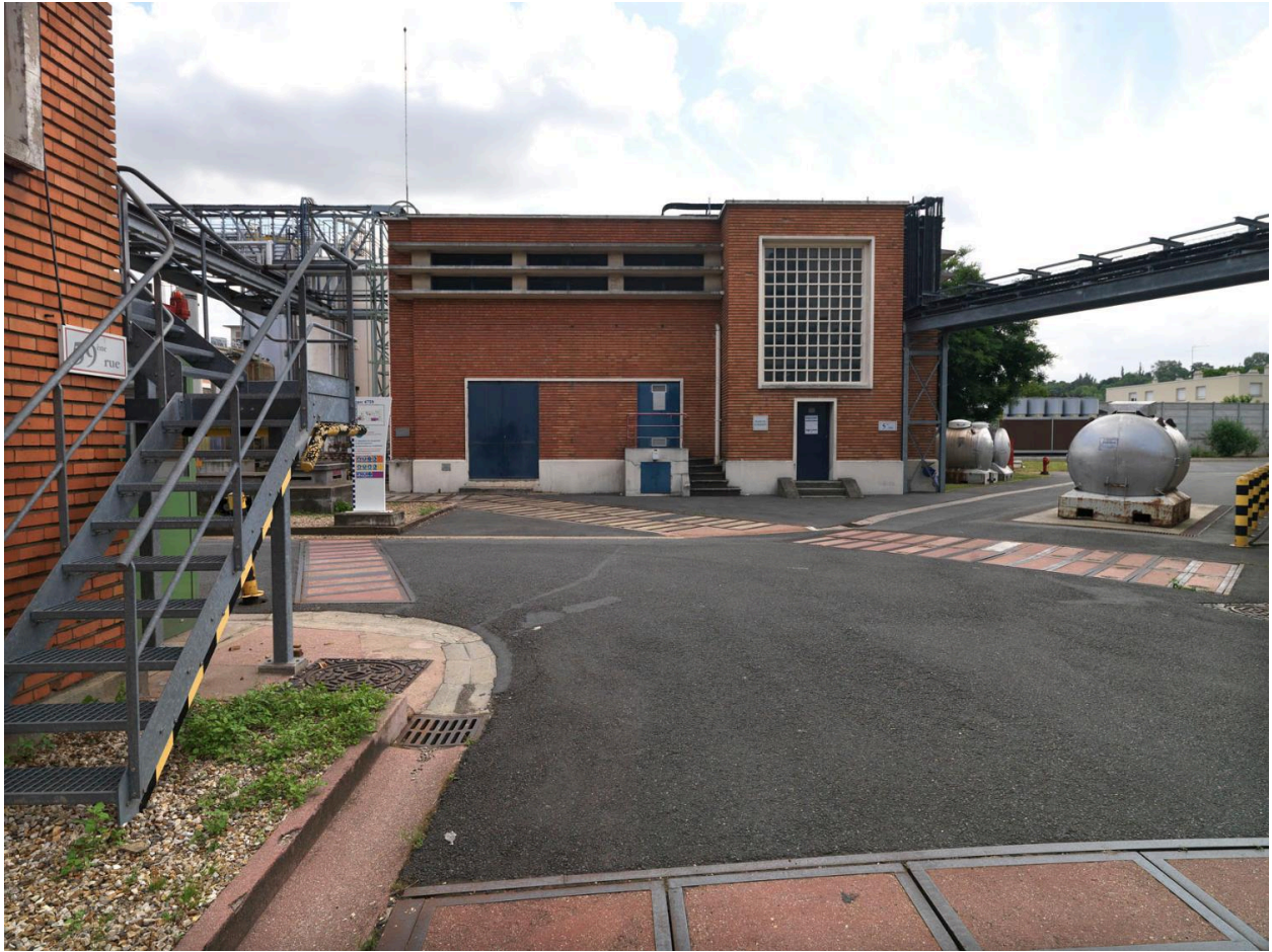
Site Sanofi. Vue des liaisons entre bâtiments.
