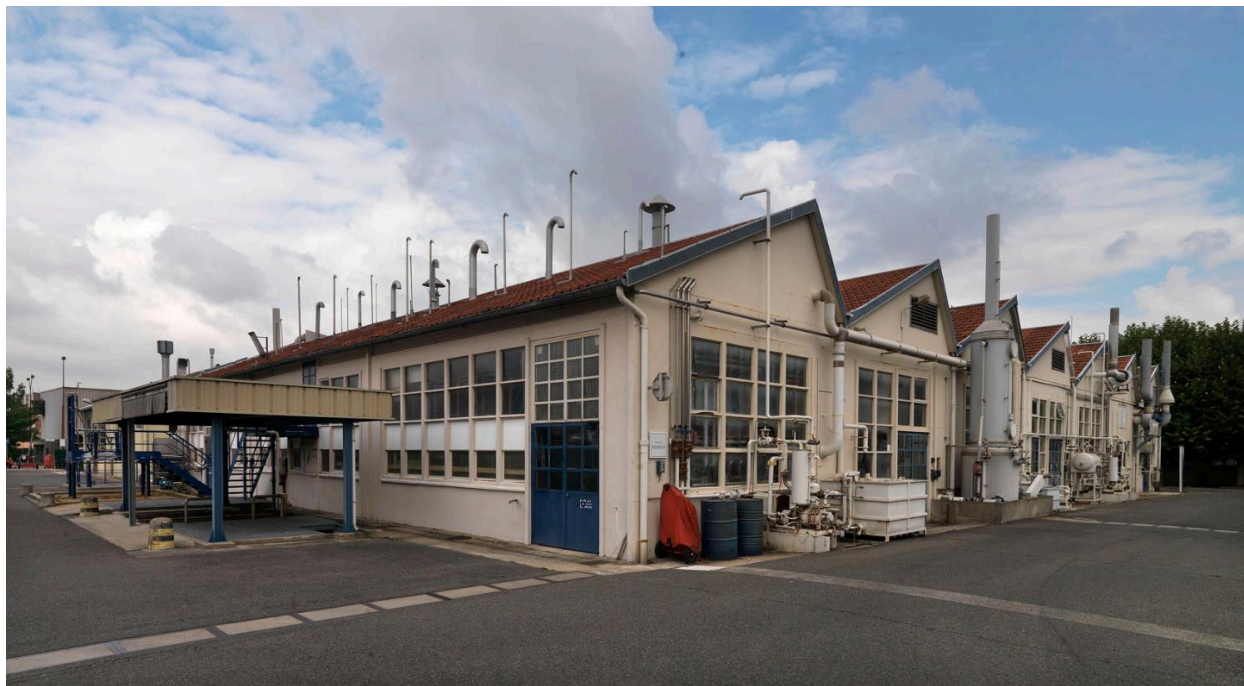
Site Biocitech, vue des bâtiments de production.
