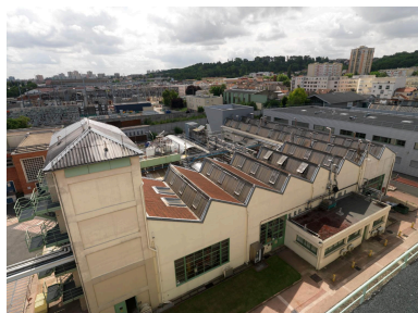
Site Sanofi. Vue des toits en shed. Phot. Laurent Kruszyk IVR11_20099300320NUC4A
