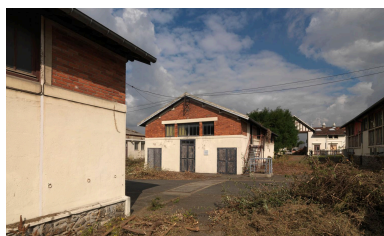
Site Biocitech. Vue des écuries désaffectées. Phot. Laurent Kruszyk IVR11_20099300472NUC4A
