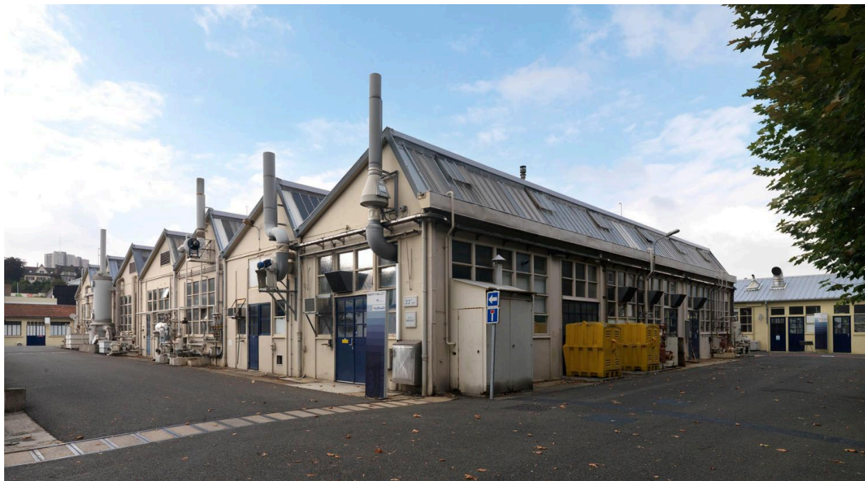
Site Biocitech, vue des bâtiments de production.
