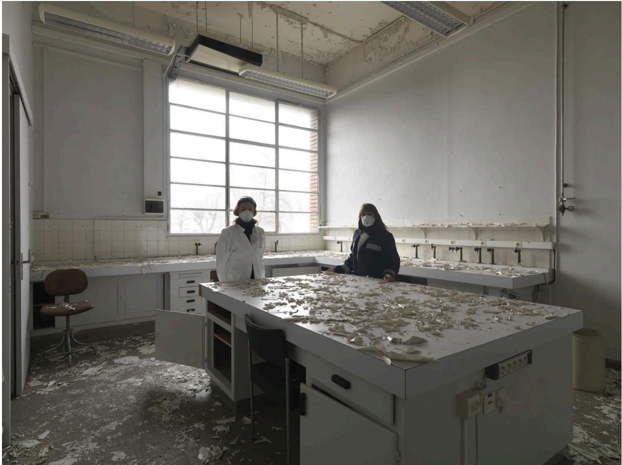
Site Sanofi. Vue des laboratoires. Bâtiment Nocard.
