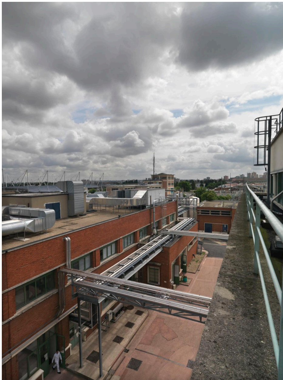
Site Sanofi. Vue depuis les toits des liaisons entre bâtiments.
