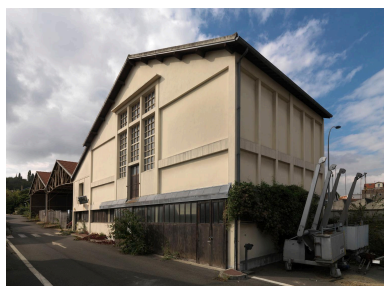
Site Biocitech. Vue des bâtiments désaffectés. Phot. Laurent Kruszyk IVR11_20099300479NUC4A
