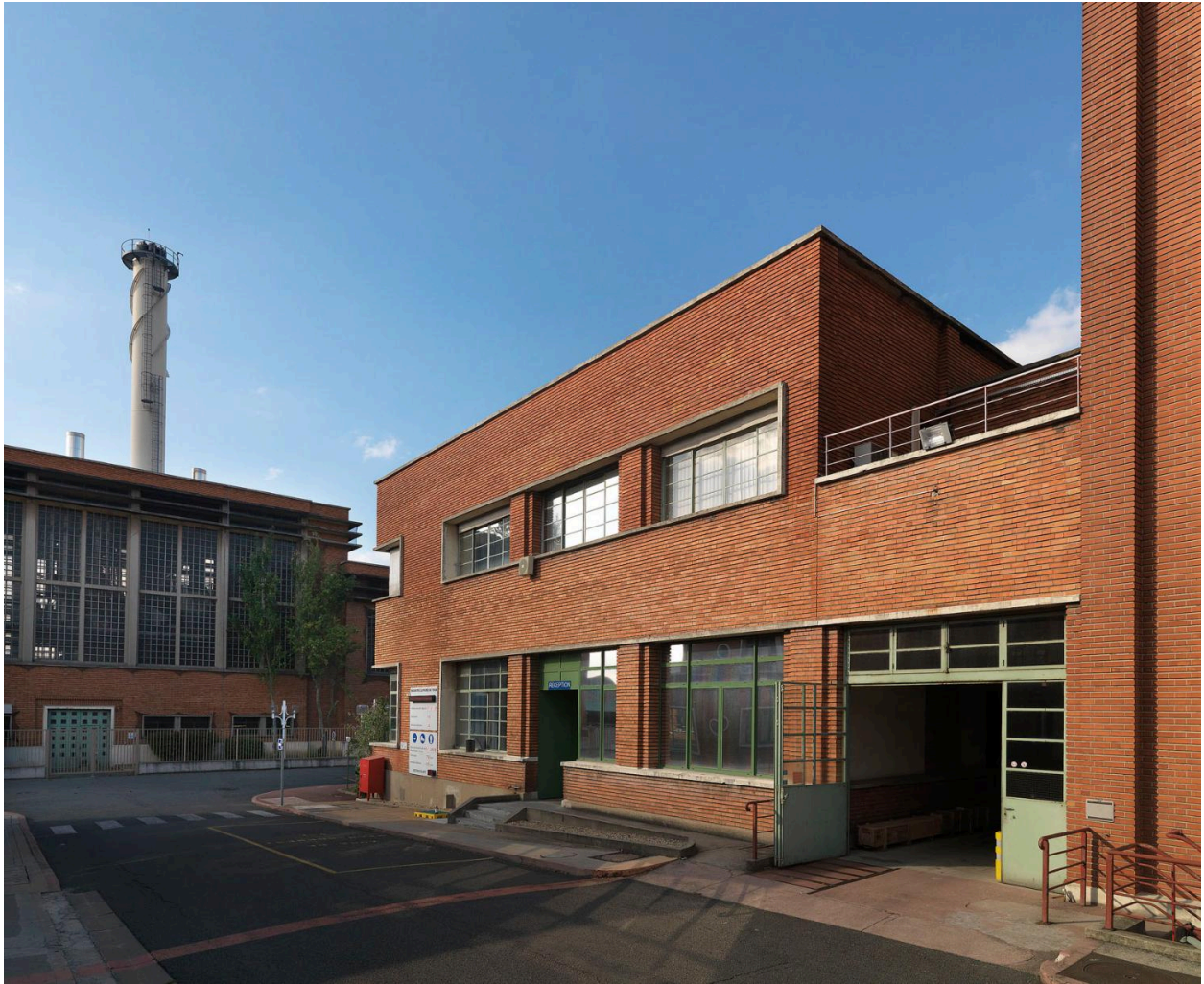
Site Sanofi, vue du bâtiment renfermant les cuves de fermentation. Bâtiment de la chaufferie en fond.
