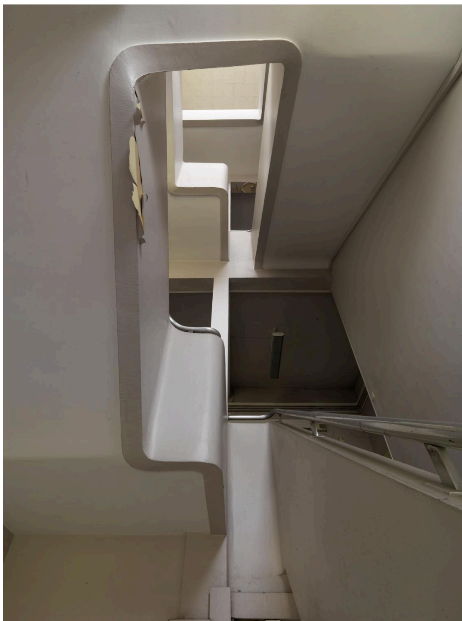
Site Sanofi. Escalier du bâtiment Nocard.
