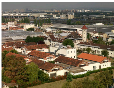
Site Biocitech. Vue d'ensemble semi- aérienne depuis le château d'eau. Phot. Laurent Kruszyk IVR11_20099300453NUC4A
