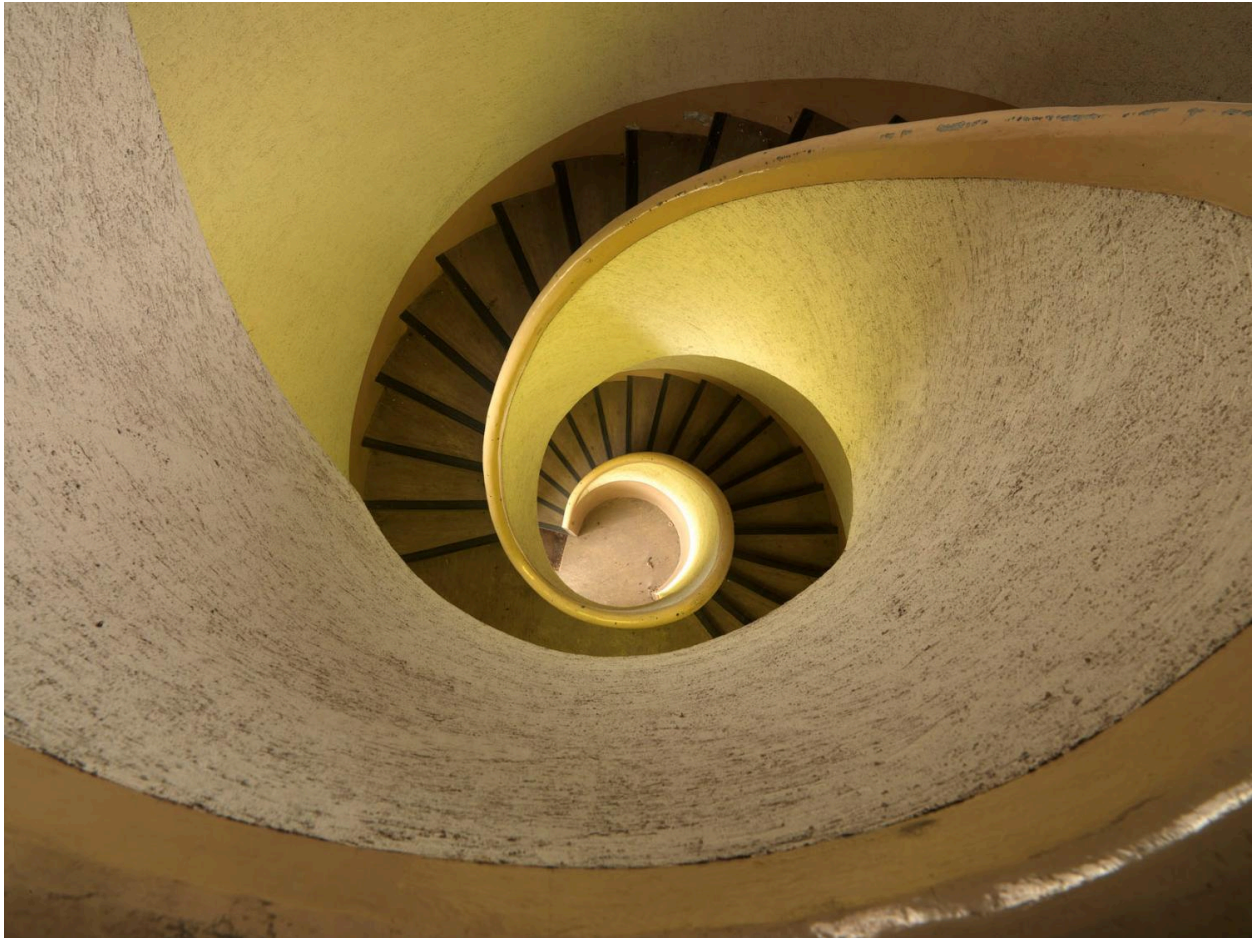
Site Biocitech. Vue de l'escalier intérieur de la tour de l'horloge.
