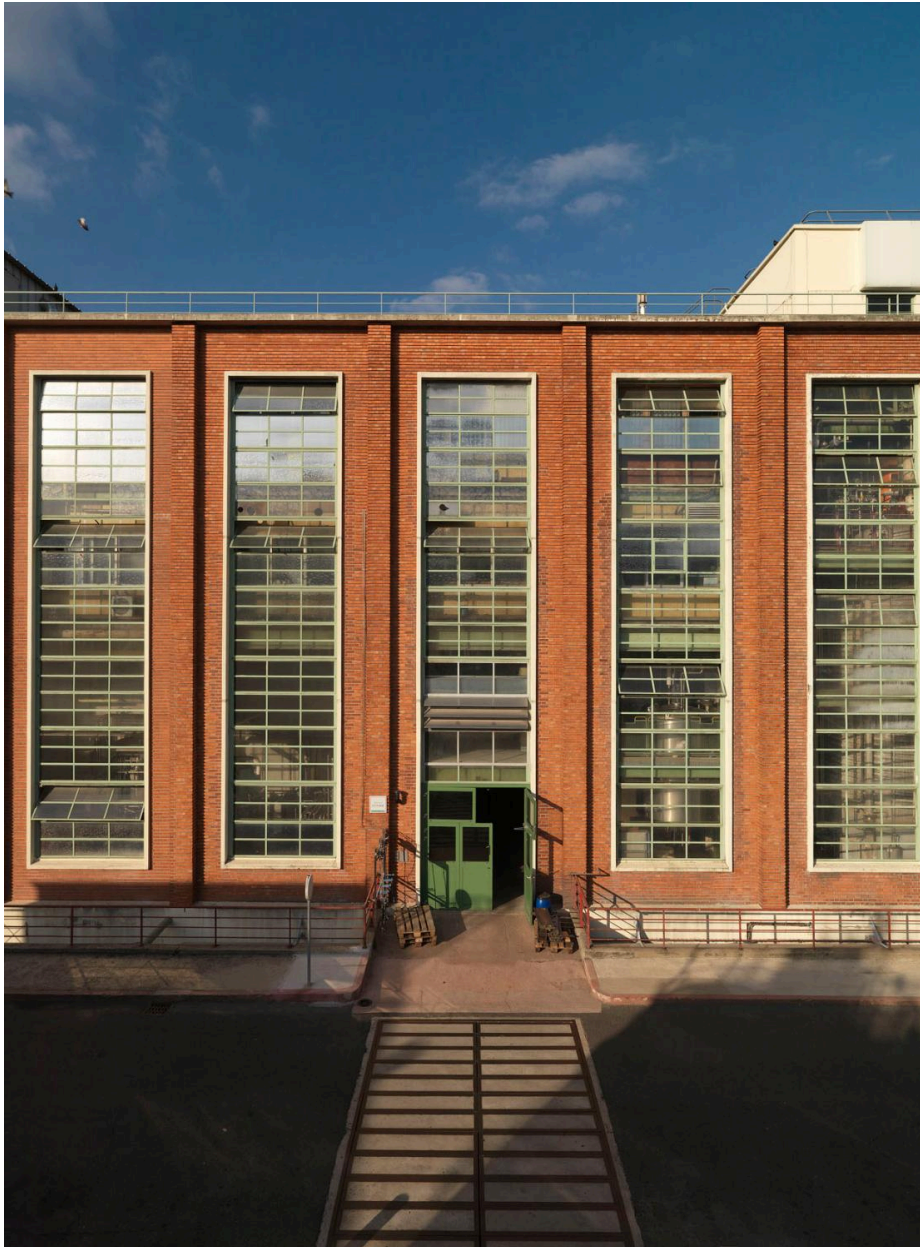
Site Sanofi. Vue du bâtiment renfermant les cuves de fermentation.
