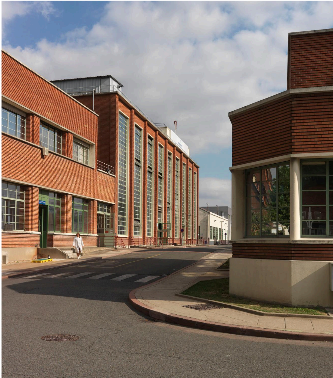
Site Sanofi, vue du bâtiment renfermant les cuves de fermentation.
