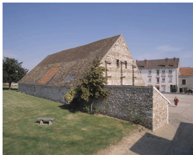
La grange : façade nord. Phot. Philippe Ayrault IVR11_20029100396XA
