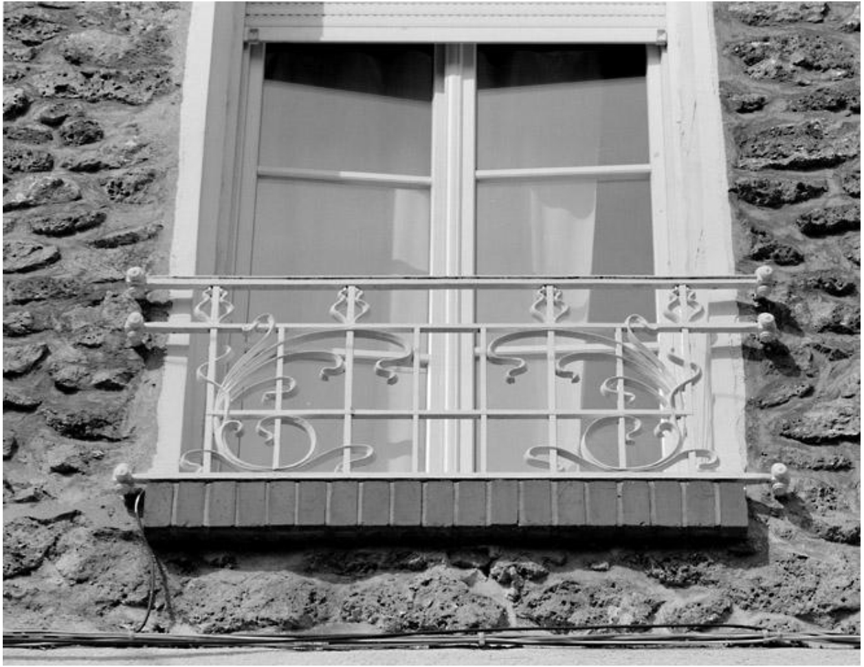
Détail d'un des garde-corps du bâtiment aligné sur la rue Robert-Schuman (n° 85). Ce bâtiment ne fait plus partie de la ferme.
