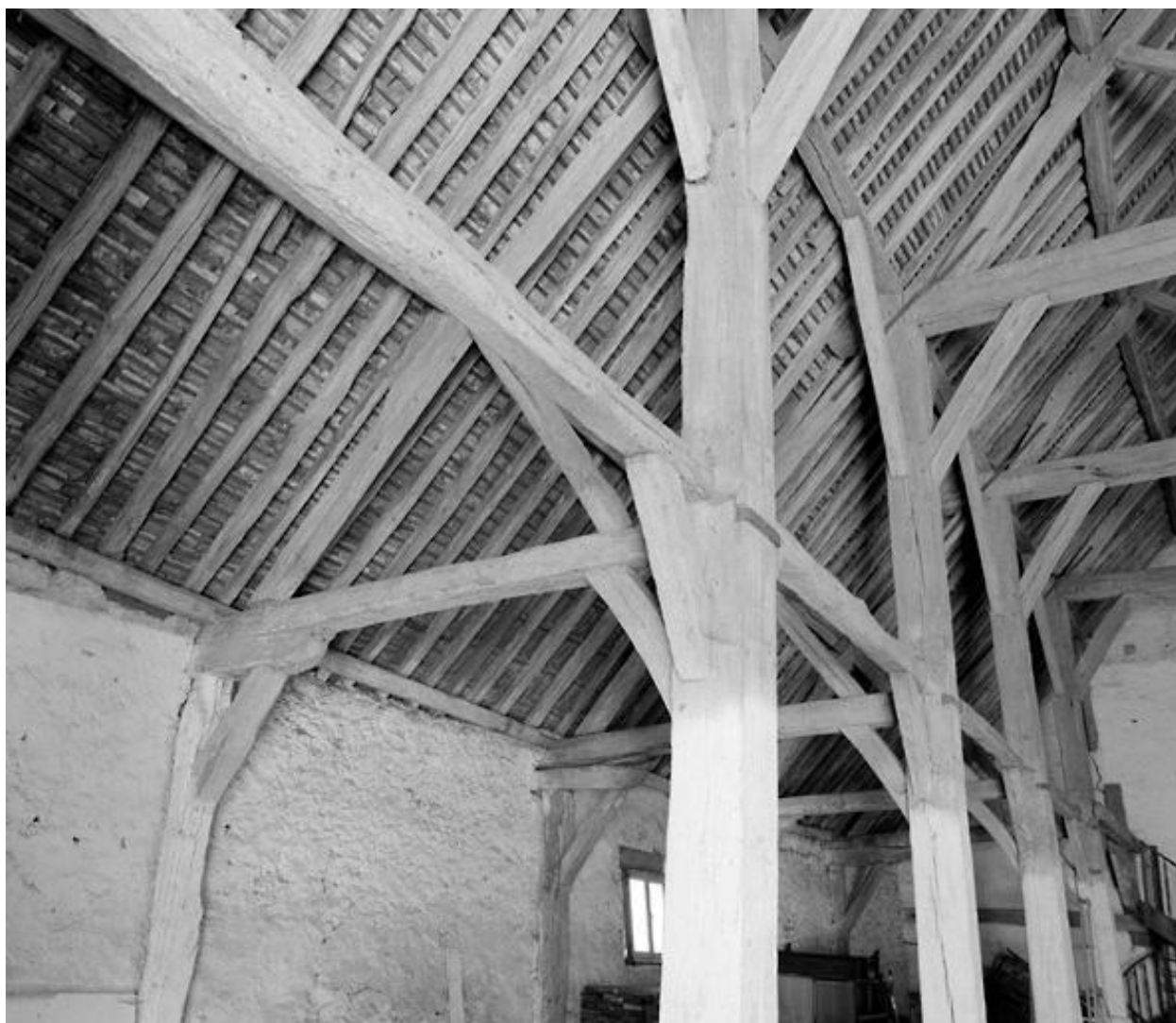
Charpente de la grange : détail sur les assemblages des poteaux.
