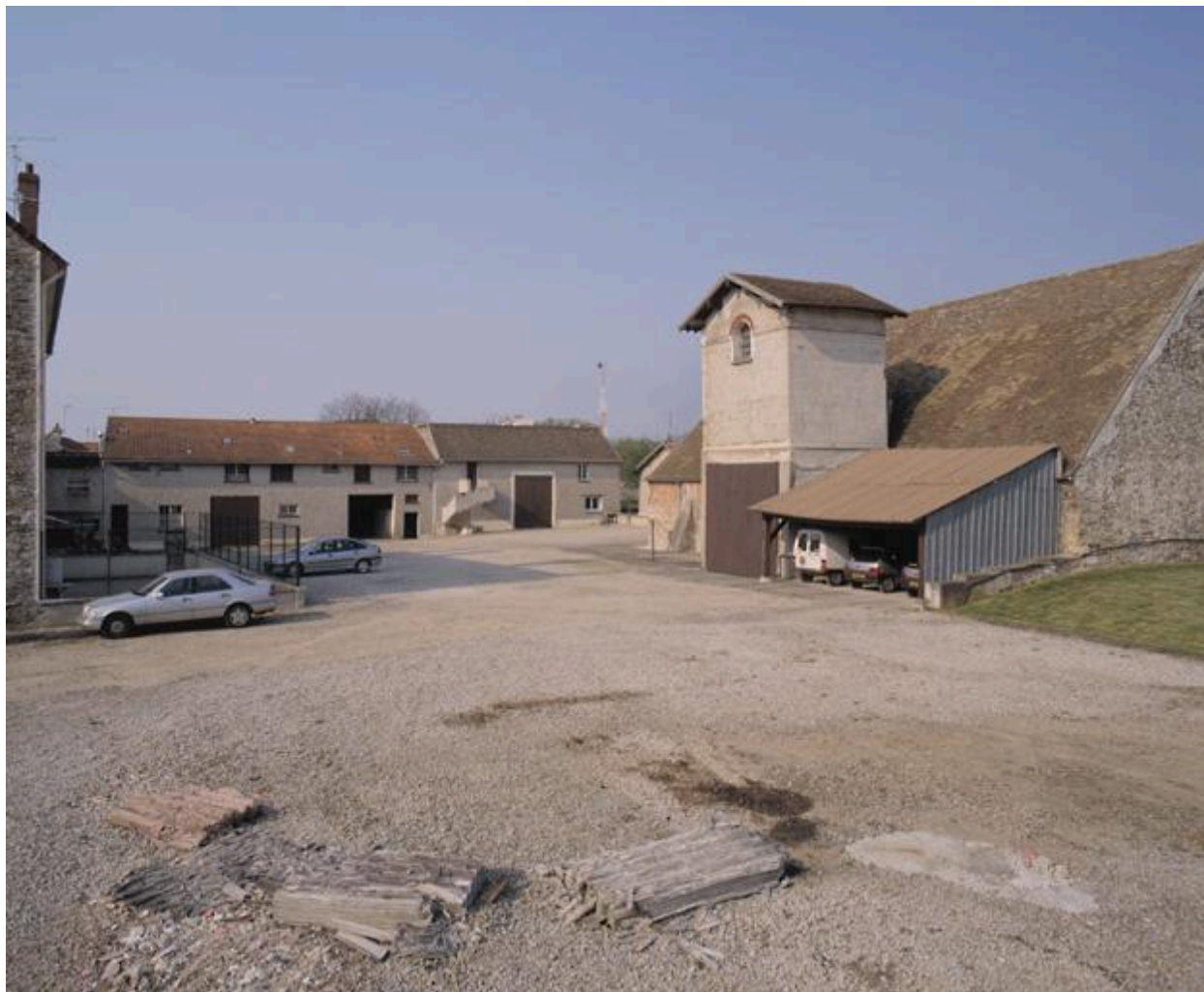
Vue de la partie sud de la cour ; au fond, les anciennes étables et grange réaménagées au 20e siècle.
