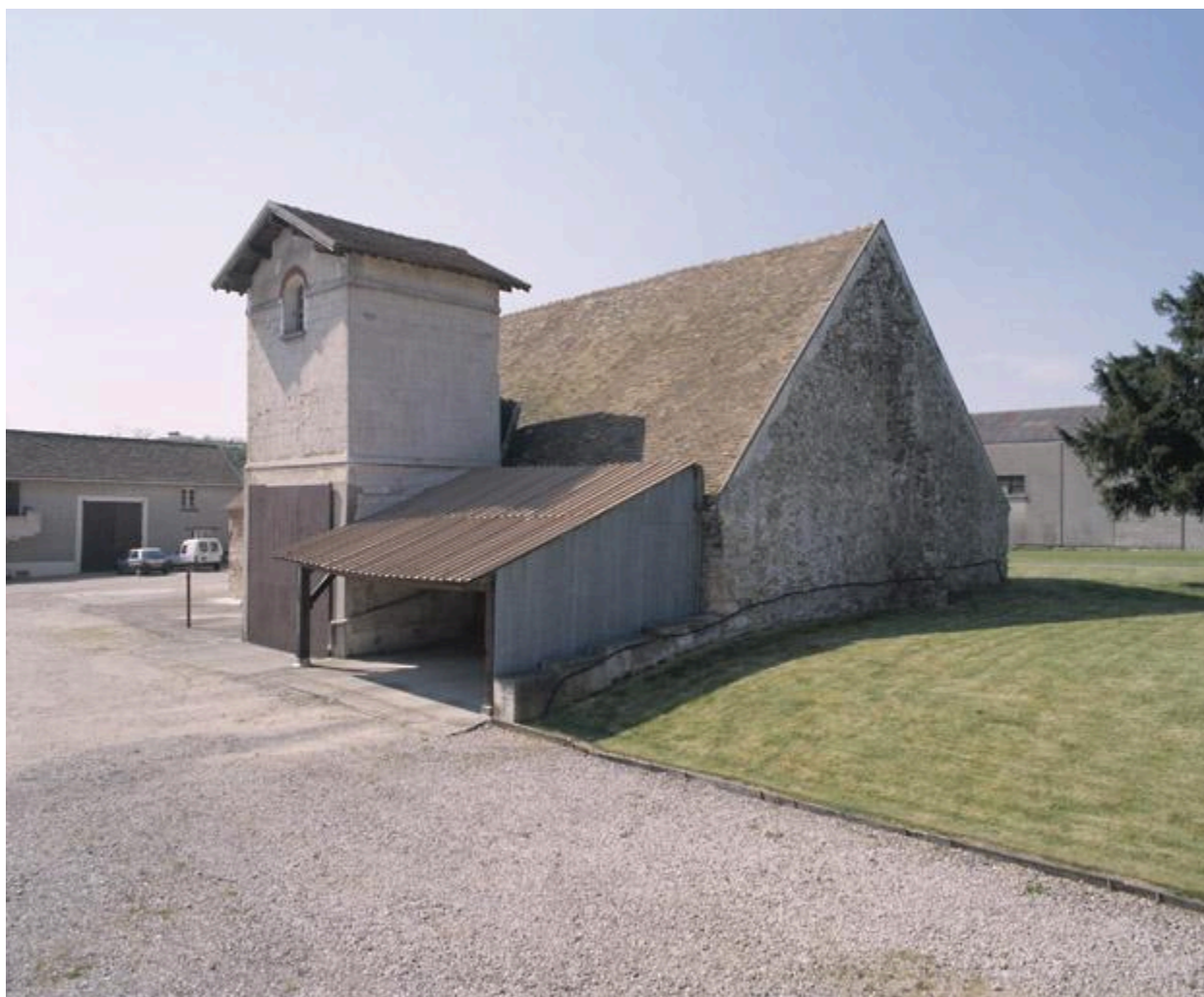
La grange : vue du pigeonnier, construit au cours du 19e siècle, au centre de la façade sud, et du pignon est.
