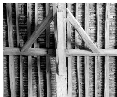
La grange, charpente : détail d'assemblage des pannes intermédiaires et contreventements.
