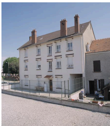
Façade, sur la cour de la ferme, du bâtiment du 85, rue Robert-Schuman. Phot. Philippe Ayrault IVR11_20029100408XA
