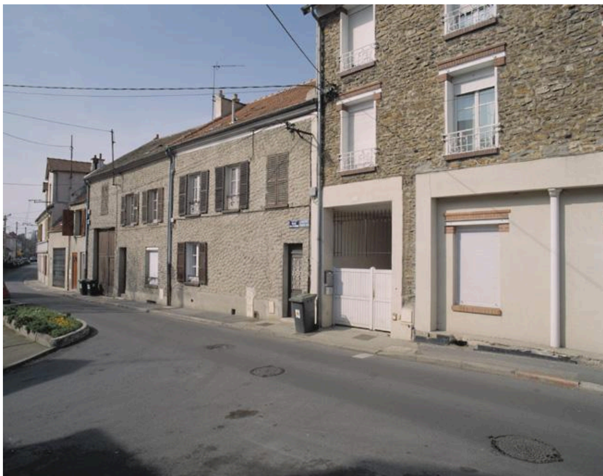
Façade enduite du 83, rue Robert-Schuman (aujourd'hui séparé de la ferme).
