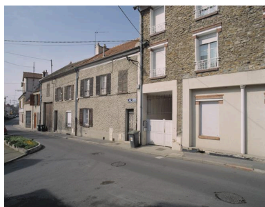
Façade enduite du 83, rue Robert-Schuman (aujourd'hui séparé de la ferme). Phot. Philippe Ayrault IVR11_20029100369XA
