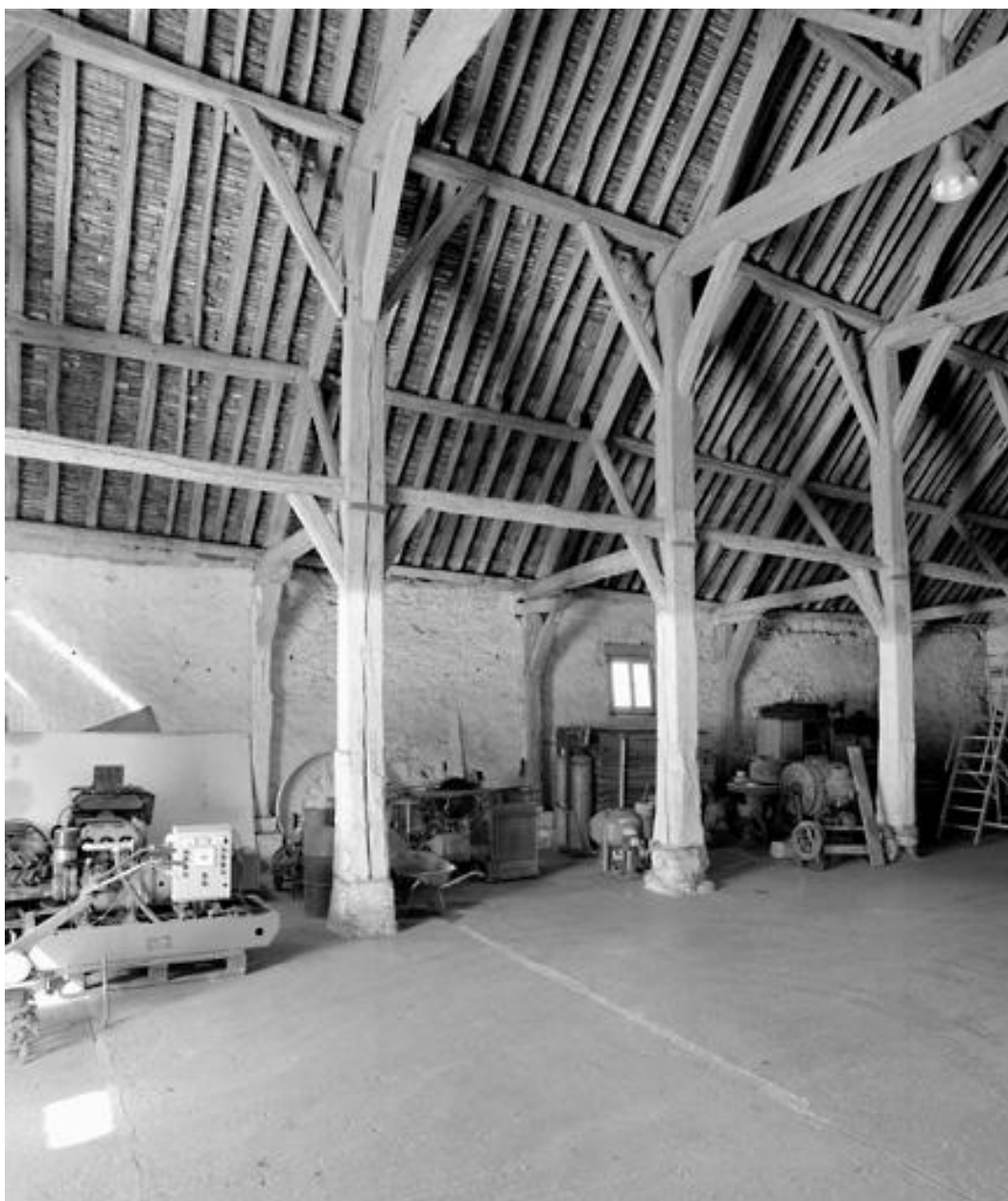
La grange : détail d'un bas-côté.
