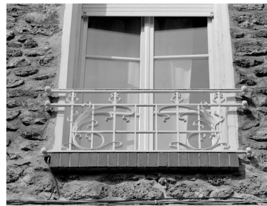
Détail d'un des garde-corps du bâtiment aligné sur la rue Robert-Schuman (n° 85). Ce bâtiment ne fait plus partie de la ferme. Phot. Philippe Ayrault IVR11_20029100367X
