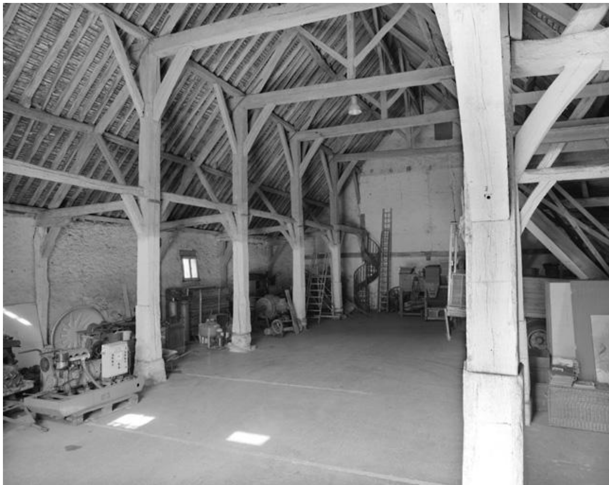
Intérieur de la grange : vue d'ensemble sur un bas-côté. Les poteaux de bois reposent au sol sur des pierres cylindriques pour les préserver de l'humidité.
