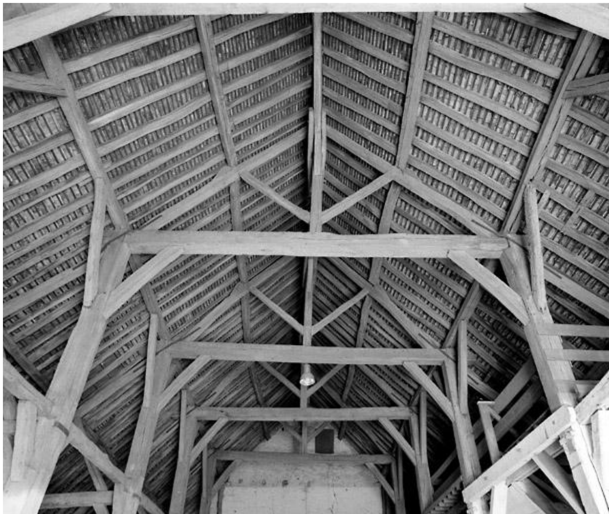
Vue d'ensemble de la charpente de la grange (1468-1488).
