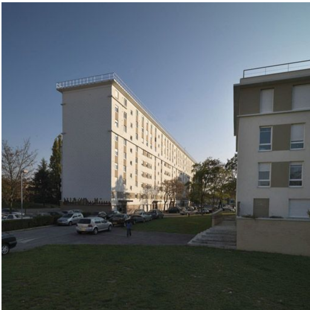
Vue de l'immeuble implanté en bordure de la rue des Edelweiss (n° 4-12) ; le rez-de-chaussée est occupé par des garages. A droite, départ de l'immeuble incurvé longeant la rue Pierre-Brossolette.
