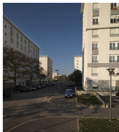
Vue du carrefour entre les rues des Edelweiss et Marcel-Cachin (à droite). Phot. Philippe Ayrault IVR11_20089100291NUC4A
