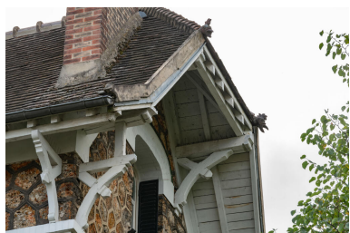
Détail de la demi-croupe de la toiture : aisseliers charpentés et têtes de coqs ornementales
