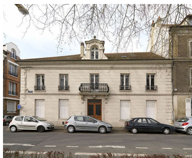
Maison 86 quai Sadi-Carnot : vue d'ensemble, depuis l'est. IVR11_20127700220NUC4A
