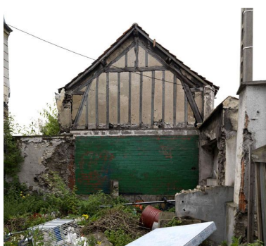
Mur pignon nord de la grange alignée sur rue (49A rue Cornillon), avec sa structure en pan-de-bois.
