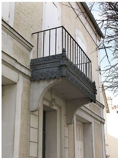
Maison 28 avenue de la République : détail du balcon en fonte. IVR11_20127700231NUC4A
