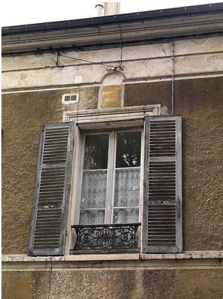
Maison de ville au 17, rue de Chaage. Détail du premier étage de la travée centrale, avec sa niche.
