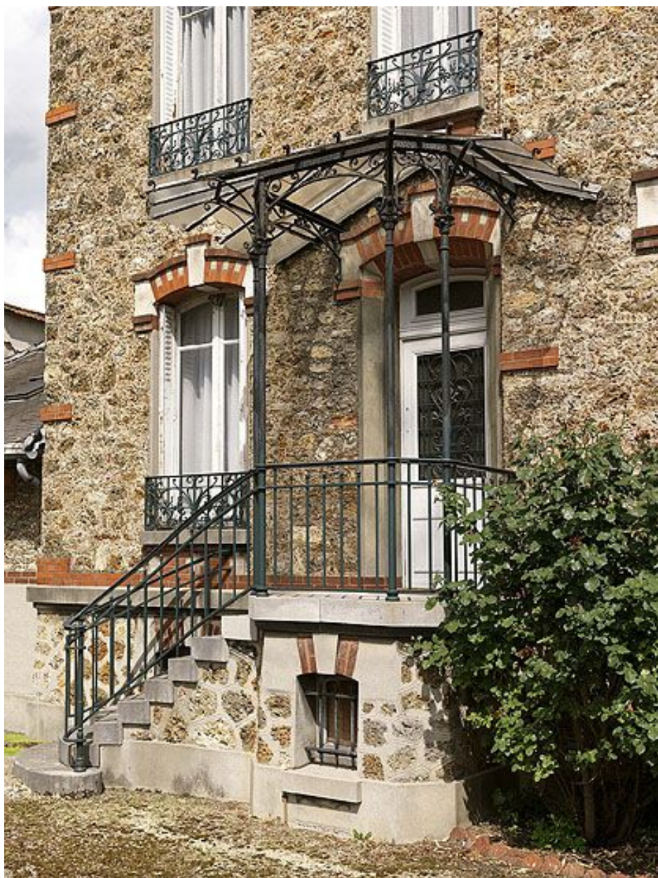
Maison 9bis quai Jacques-Prévert : détail du perron et de la marquise.
