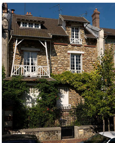
Maison 27 rue Gambetta, avec murs en meulière apparente et balcon en bois montant jusqu'à la toiture. Cette maison aurait été construite par l'architecte installé dans la villa voisine (voir dossier IA77000771). Elle adapte les signes de la villégiature à l'échelle plus modeste de la maison mitoyenne. IVR11_20097701402NUC4A
