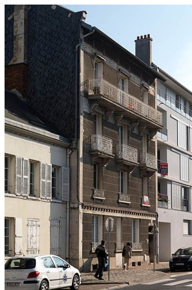
Immeuble au 21bis, boulevard Jean-Rose : façade soignée, avec décor de sgraffite et balcons en feronnerie 1900. IVR11_20097701371NUC4A
