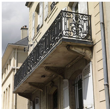
Maison 9 quai Jacques-Prévert : détail du balcon vers la Marne. IVR11_20117701002NUC4A
