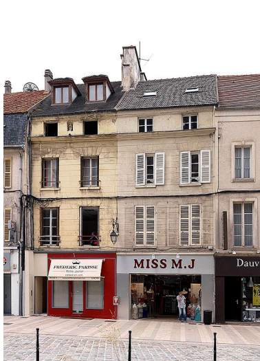
Façade de deux maisons "jumelles" 9-11 rue Saint-Etienne, avec étage
