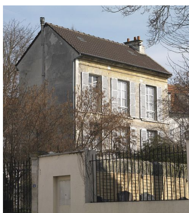
Maison 4 place Henri-Moissan, construite en retrait des axes viaires. IVR11_20097700273NUC4A
