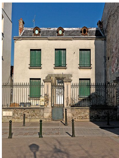
Maison 39 rue du Faubourg Saint- Nicolas. Cette maison est construite sur l'emplacement de l'ancien
