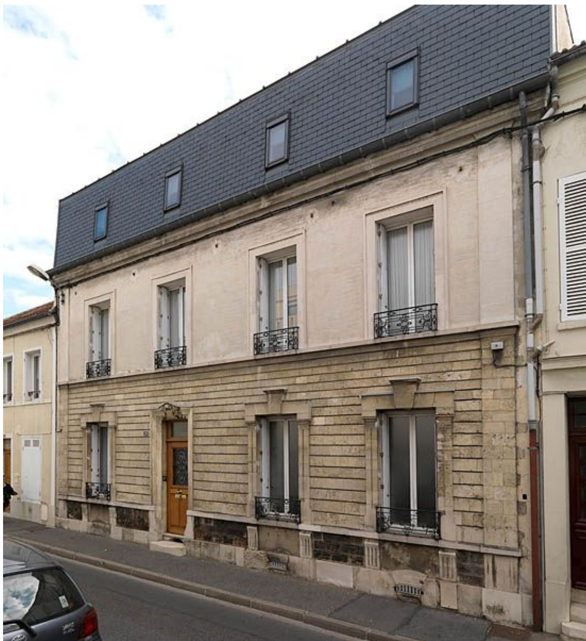
Maison au 22, rue Saint-Faron, fortement remaniée à l'étage mais conservant un rez-de-chaussée mêlant pierre de taille et enduit imitation pierre.
