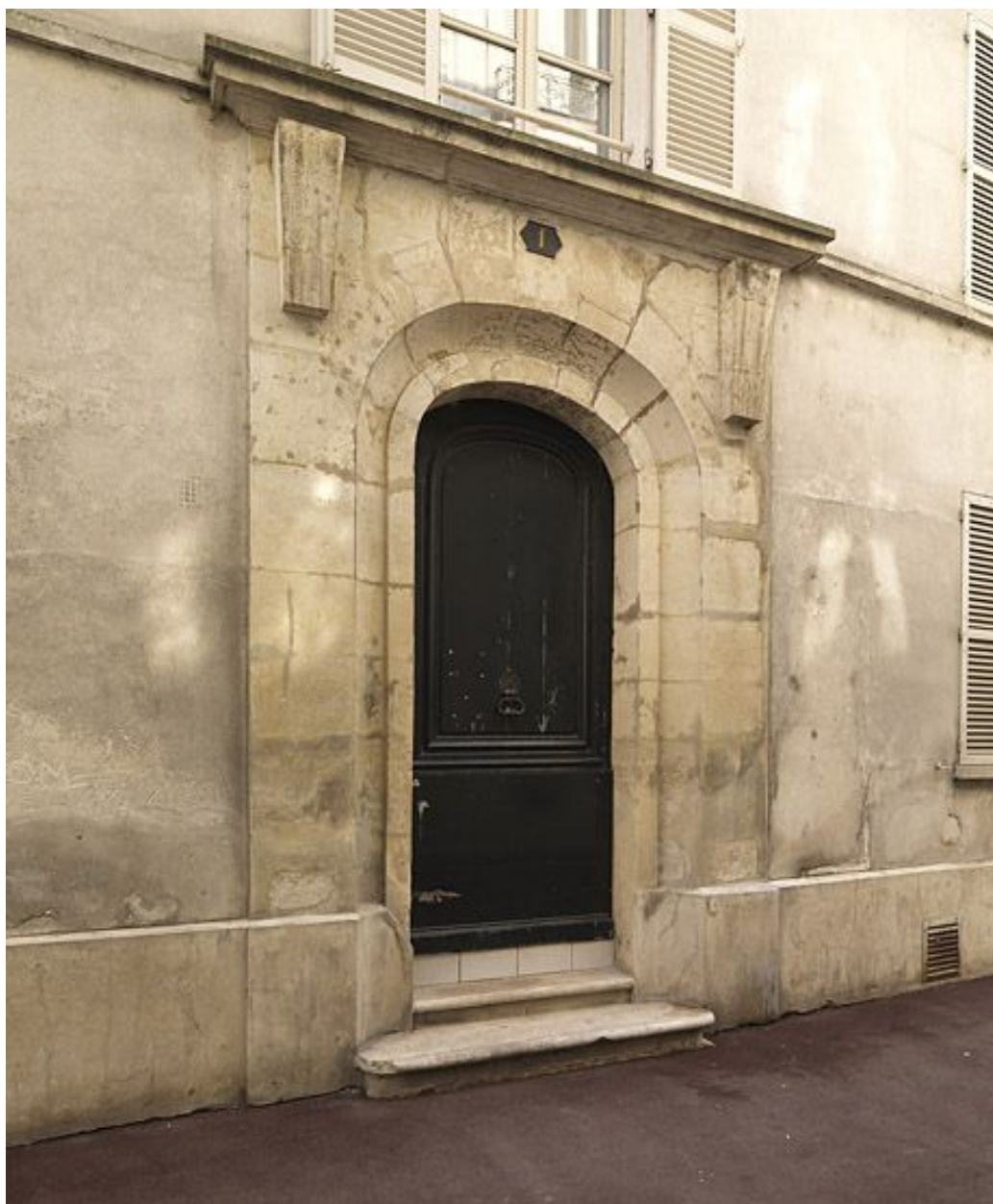
Immeuble 1 rue Antoine-Carro : détail de l'entrée.
