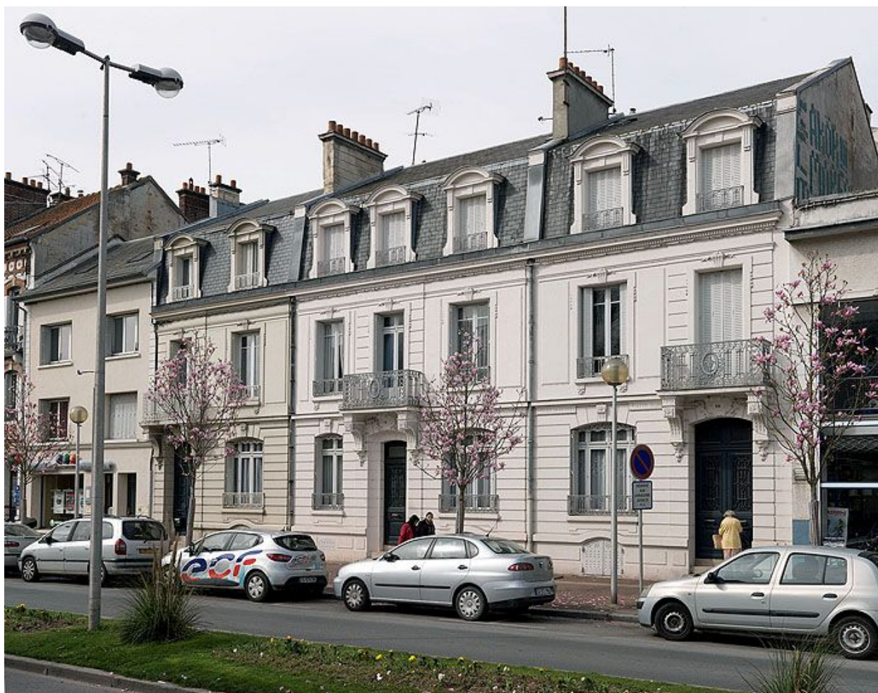
Façade d'un ensemble de maisons "triplées", 10-14 cours Raoult.
