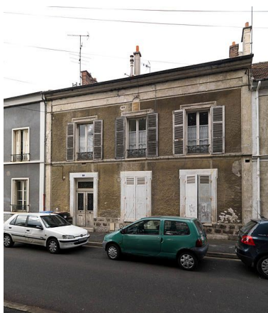
Maison de ville au 17, rue de Chaage : façade enduite sur soubassement de grès. IVR11_20097701455NUC4A
