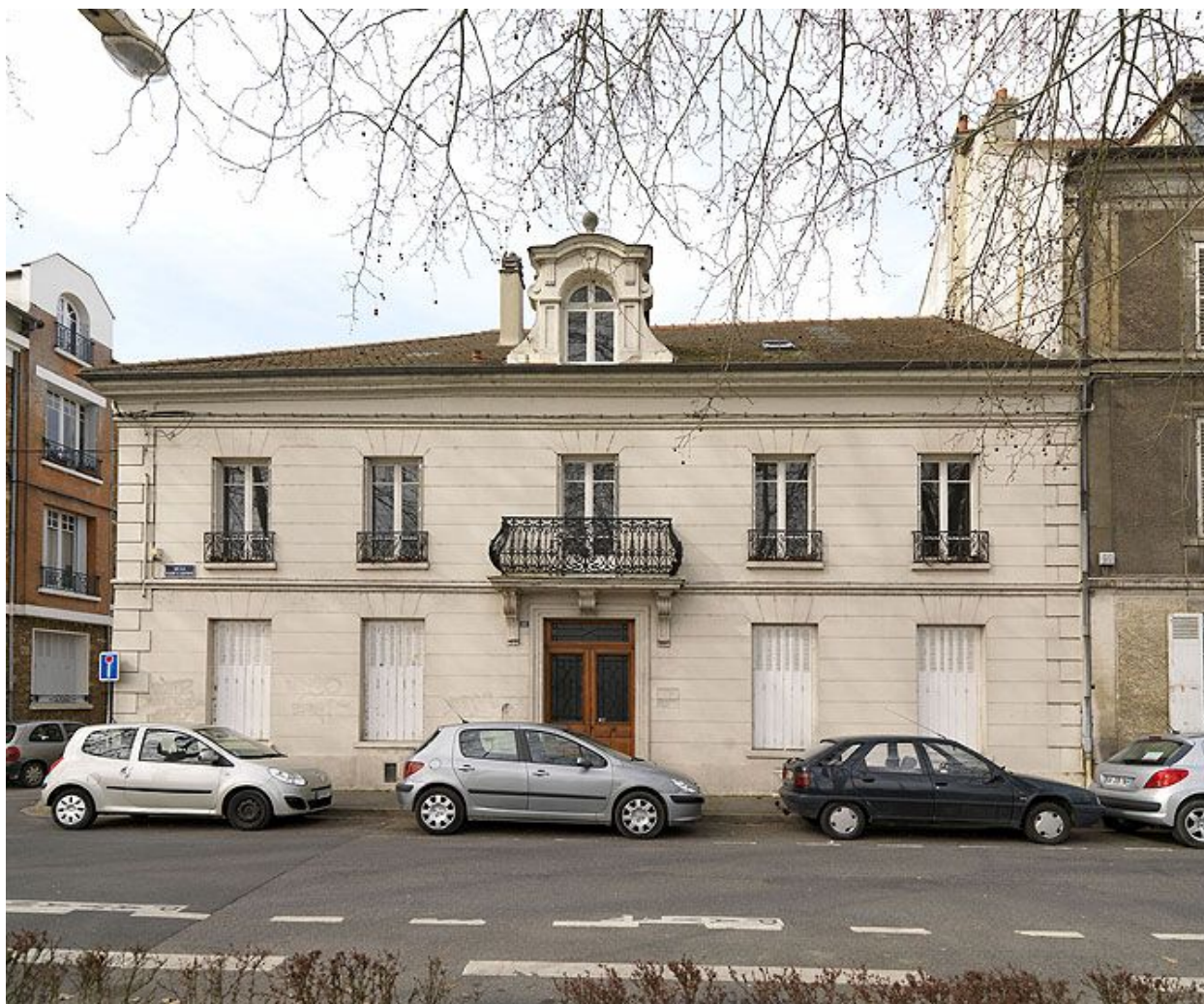
Maison 86 quai Sadi-Carnot : vue d'ensemble, depuis l'est.
