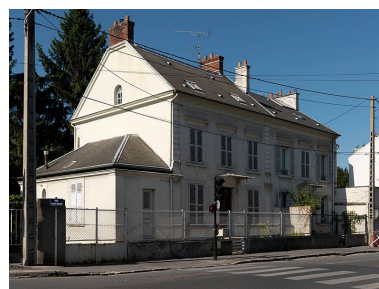
Maisons "fausses jumelles" aux 39-41, rue Saint-Faron. Les deux maisons sont de même type mais ne sont pas absolument identiques. La première possède notamment une annexe contre son mur pignon sud. IVR11_20097701426NUC4A
