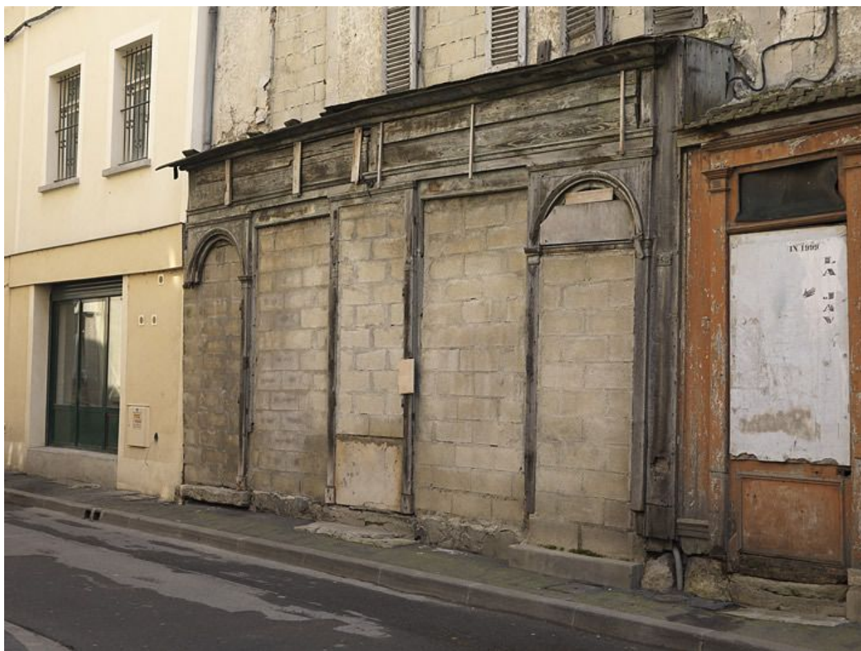
Maison 7 rue du Tan, vue du rez-de-chaussée : les boiseries de la devanture (19e siècle), avant rénovation.
