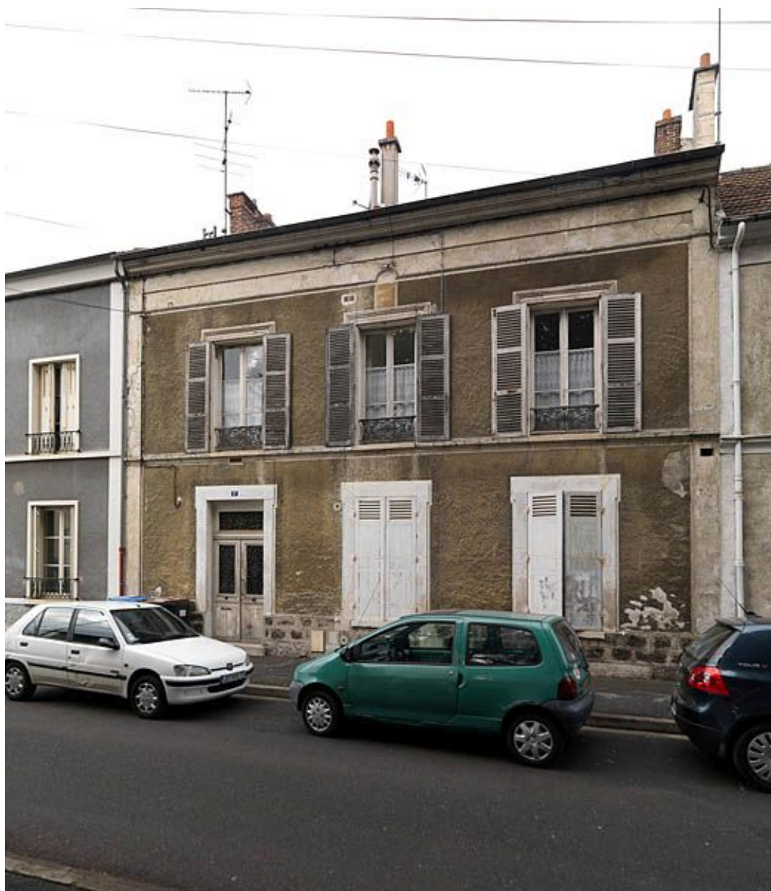
Maison de ville au 17, rue de Chaage : façade enduite sur soubassement de grès.
