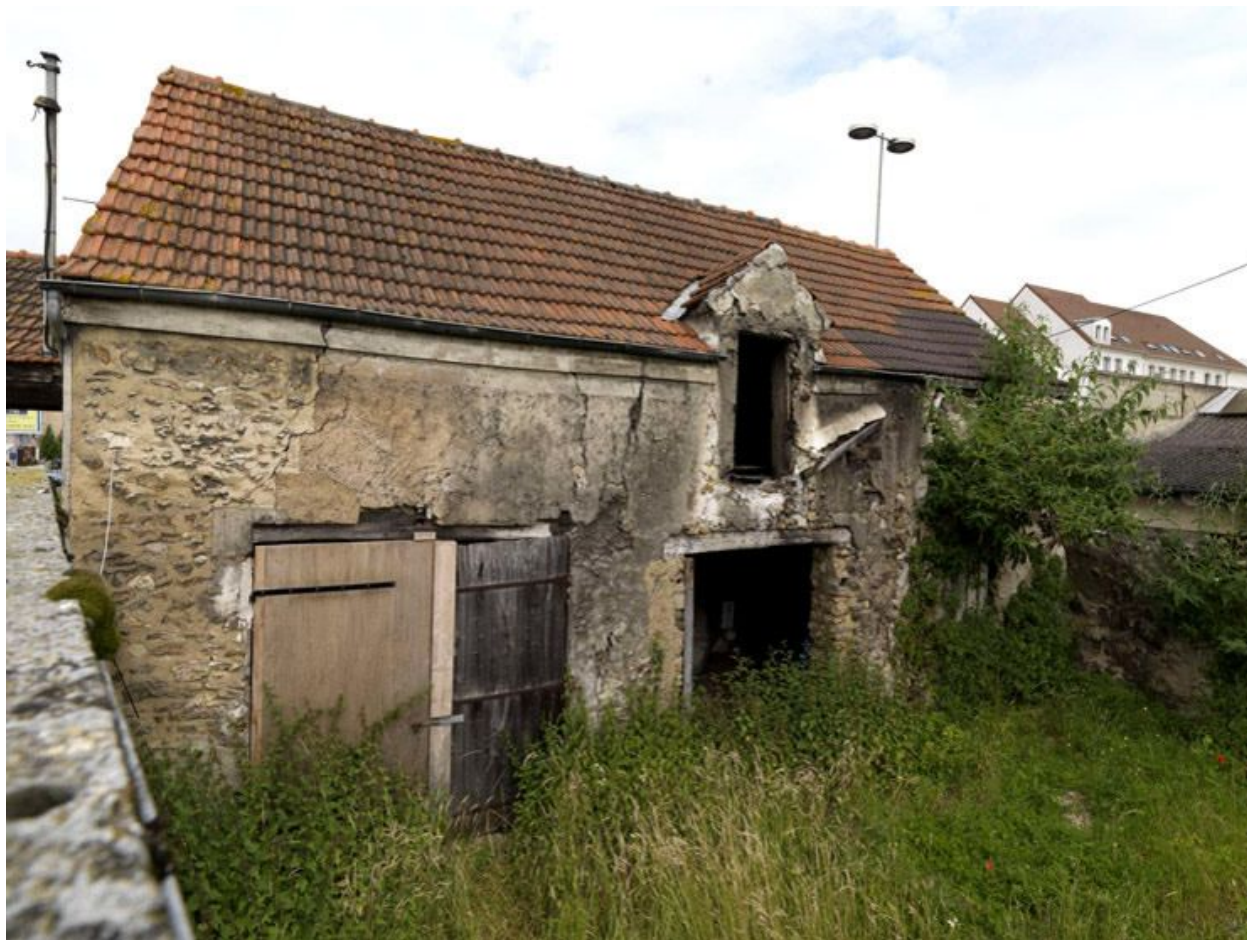
La grange sur rue (49A rue Cornillon) : façade arrière, vue depuis la cour.
