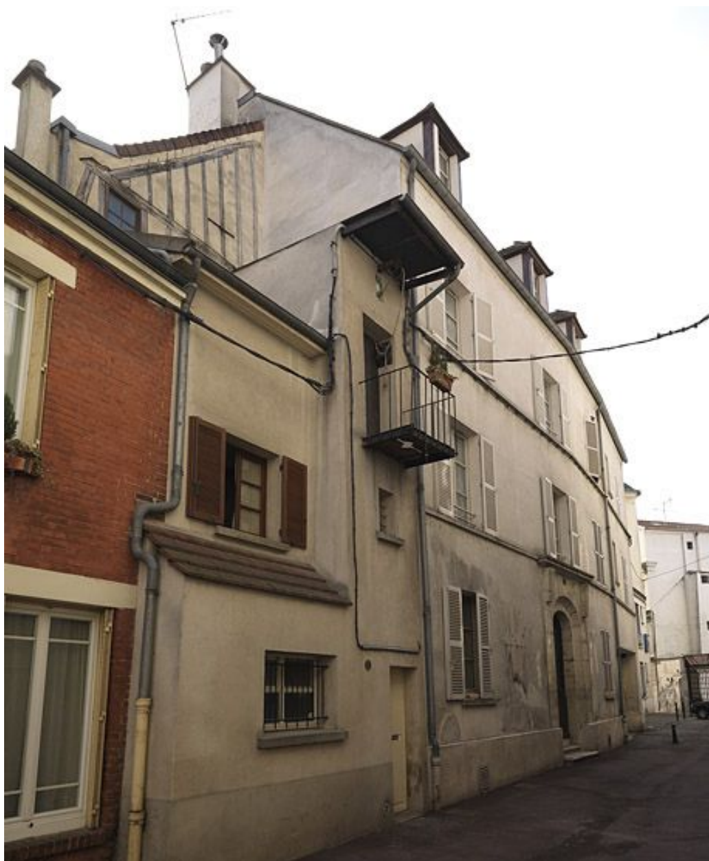
Immeuble 1 rue Antoine-Carro : vue d'ensemble.
