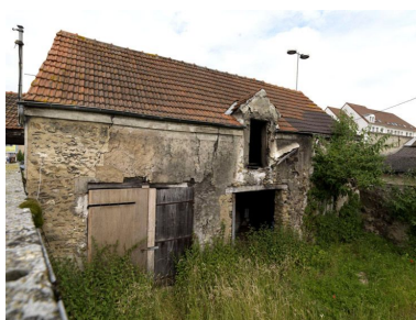
La grange sur rue (49A rue Cornillon) : façade arrière, vue depuis la cour.
