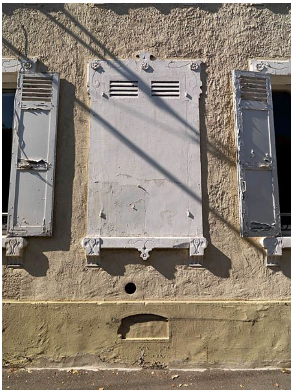
Maison au 9, rue Barigny. Détail de l'élévation sur rue : la fenêtre feinte au rez-de-chaussée.
