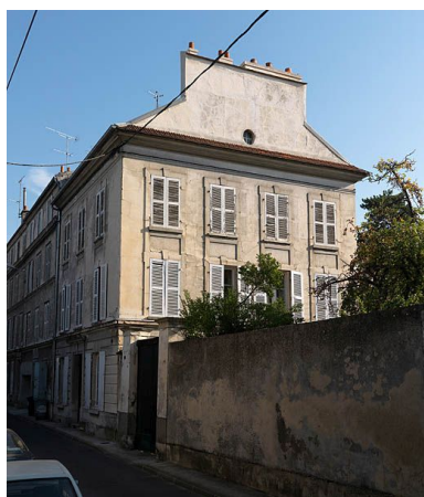
Maison au 6, rue Alfred- Maury, présentant un pignon nettement découvert. Cette maison a la particularité d'avoir un double accès : l'un direct sur la rue, l'autre par le jardin. IVR11_20097701364NUC4A
