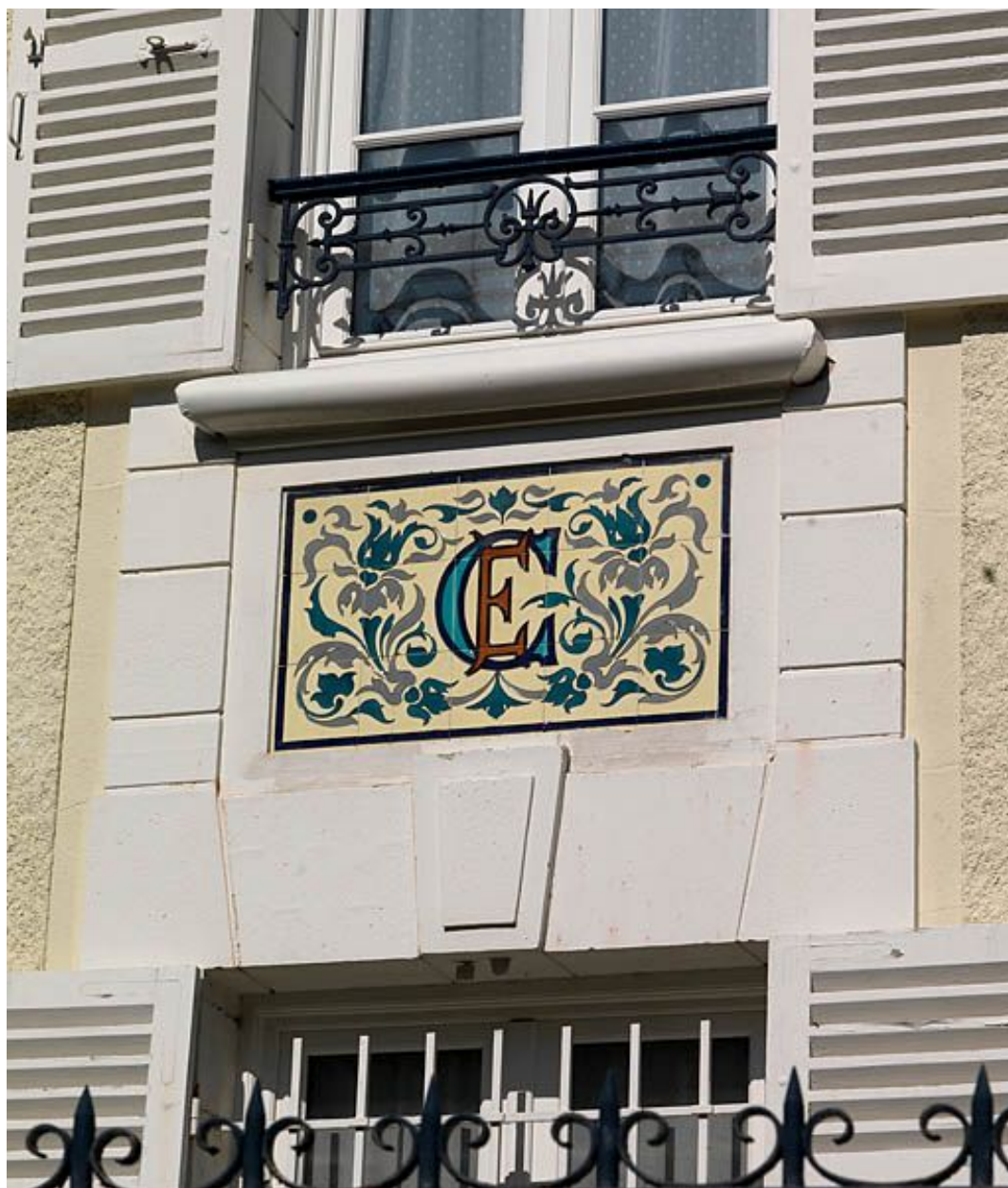
Maison au 2ter, impasse Saint-Faron. Détail d'une allège de fenêtre : panneau de céramique avec initiales "CE".
