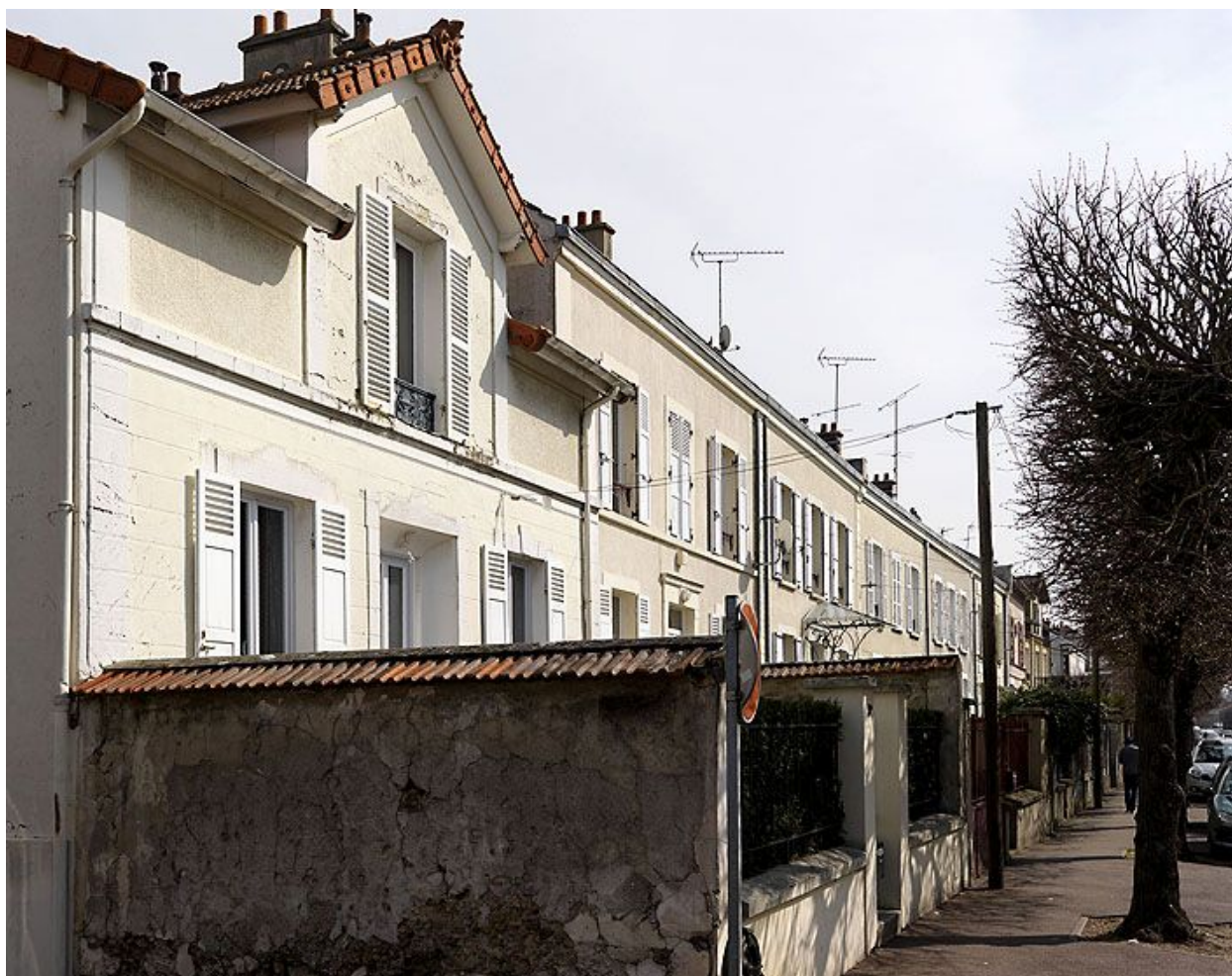
Alignement de pavillons, n° 3bis à 11bis de l'avenue de la République. La maison au 1er plan (n°3 bis) est suivie d'un ensemble de pavillons en bande identiques (n°5 à 11bis).
