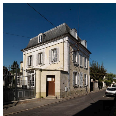
Maison au 9, rue Barigny. Cette maison appartient au groupe à entrée latérale, l'accès se faisant par la cour. L'élévation sur rue présente un décor stucqué soigné, avec des fenêtres feintes. Dans la cour s'élèvent des hangars et entrepôts.
