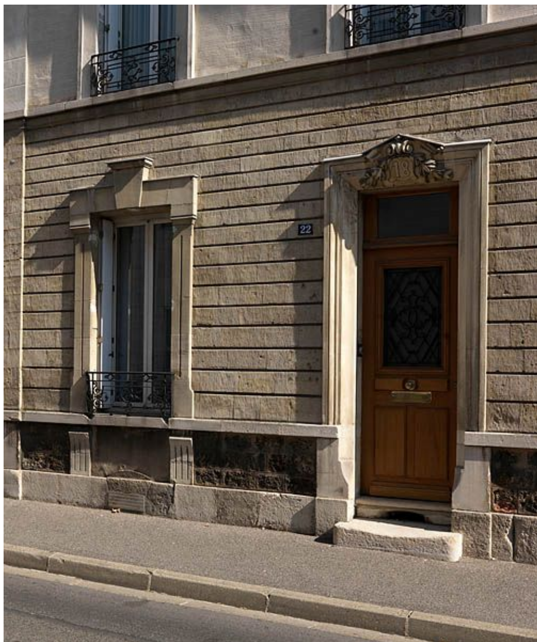
Maison au 22, rue Saint-Faron : détail du rez-de-chaussée.
