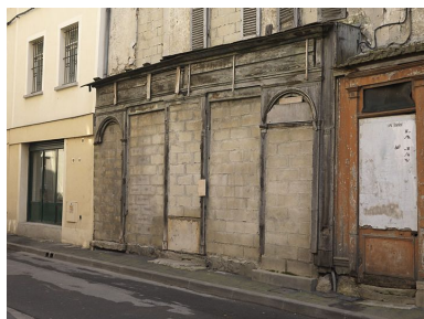
Maison 7 rue du Tan, vue du rez-de-chaussée : les boiseries de la devanture (19e siècle), avant rénovation. IVR11_20097700301NUC4A
