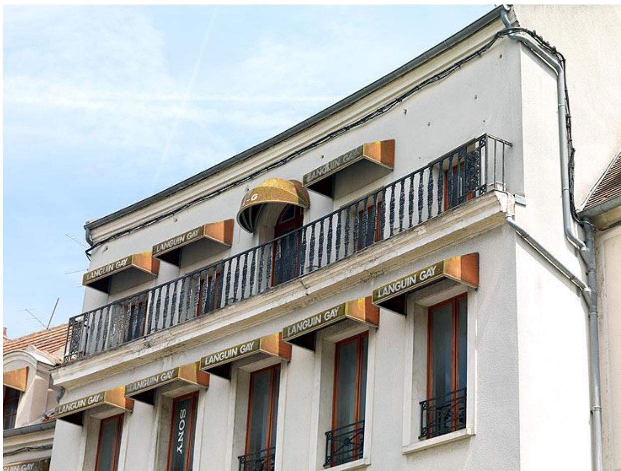
Balcon en fonte au dernier étage d'un immeuble en arrondi, très remanié, au 65 rue du Commandant-Berge.
