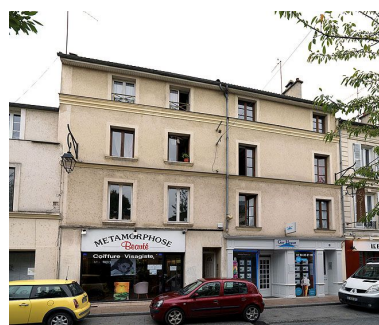
Maisons 10-12 rue du Faubourg Saint-Nicolas. Au n°10, maison ancienne avec escalier à balustrades en bois tourné. Au n°12, habitation ancienne comportant encore son escalier en vis à l'arrière, mais remaniée dans le dernier quart du 20e siècle : la comparaison avec l'état de 1982 (date du pré-inventaire) montre en effet une surélévation et la disparition des galeries sur cour. IVR11_20127700836NUC4A
