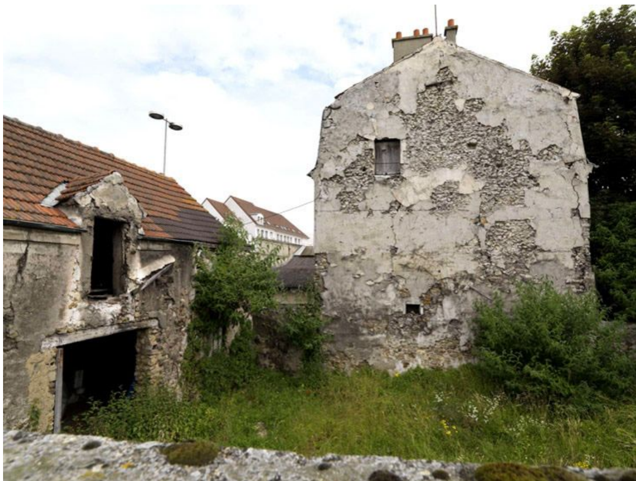
Vue des deux bâtiments, depuis la cour : à gauche, la grange sur rue ; à droite, le mur pignon sud du logis XIXe, en retrait.
