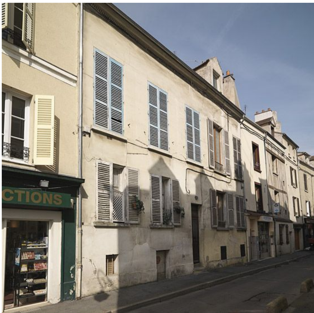
Maison 28 rue du Tan : logis ancien, à rez-de-chaussée surélevé sur niveau de caves et corniche fortement saillante.
