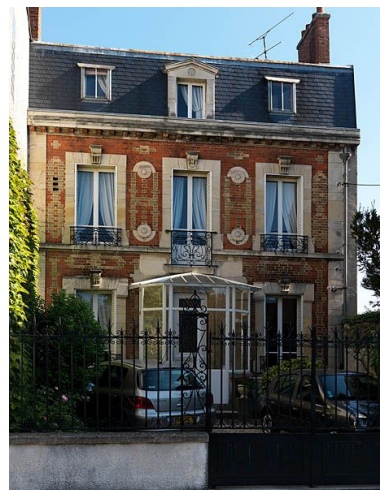
Maison au 36, rue Saint-Faron, avec façade à parements de brique. IVR11_20097701425NUC4A
