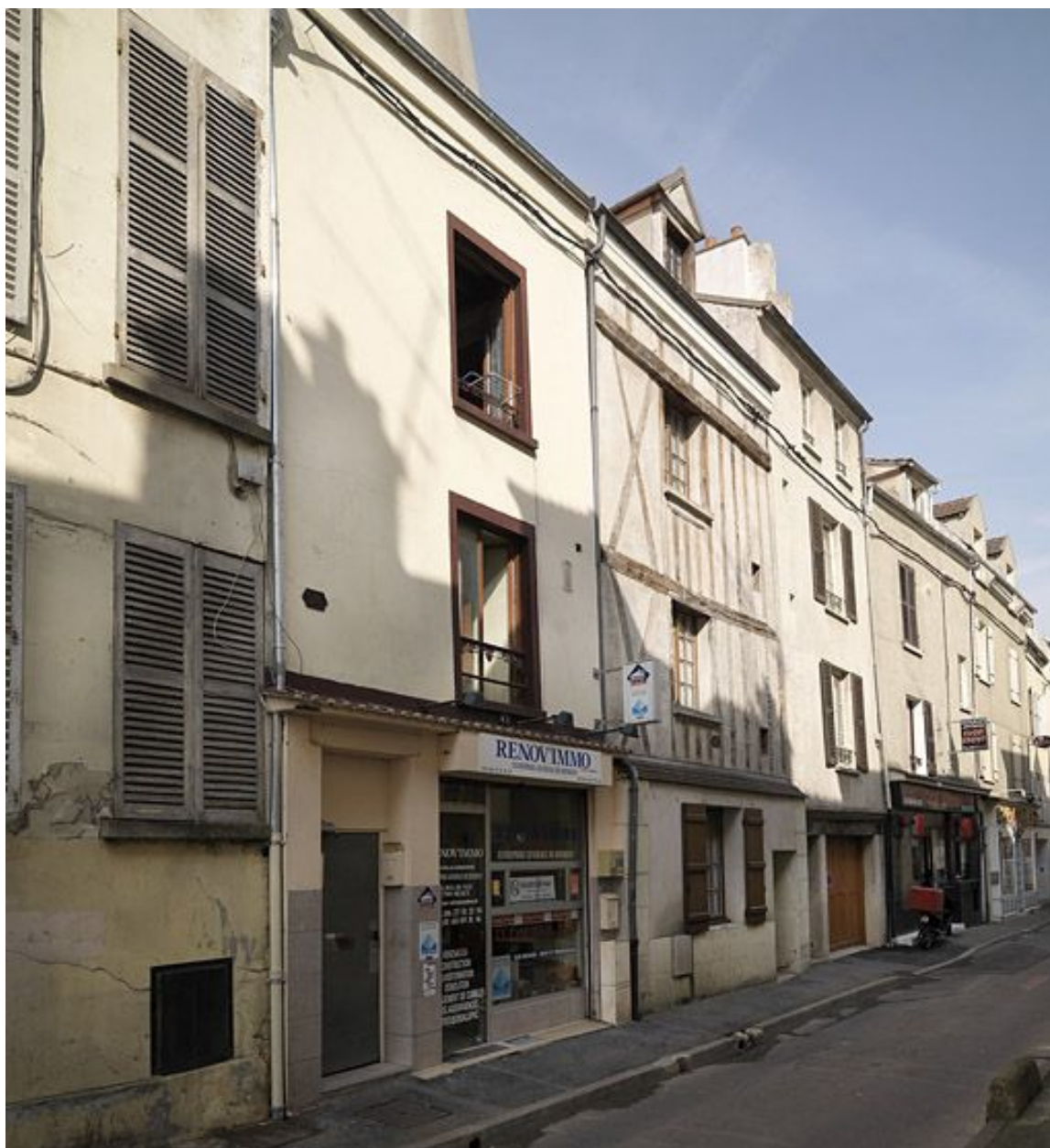
Alignement de maisons anciennes, rue du Tan. Au n°24, façade à pans de bois apparent.
