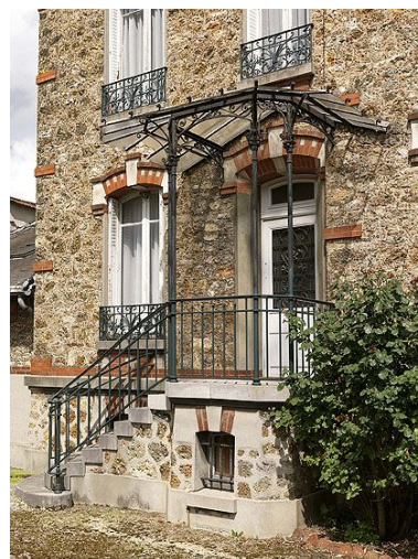
Maison 9bis quai Jacques-Prévert : détail du perron et de la marquise. IVR11_20117701004NUC4A
