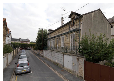
Vue du bâtiment implanté au revers de l'immeuble 31, rue Gambetta. Ce bâtiment en fond de parcelle ouvre sur la rue Paul-Bert. Il comprend un niveau de garages (anciennes écuries?) et un étage d'habitation desservi par une coursière extérieure. C'est le seul exemple de ce dispositif dans le quartier. IVR11_20097701451NUC4A
