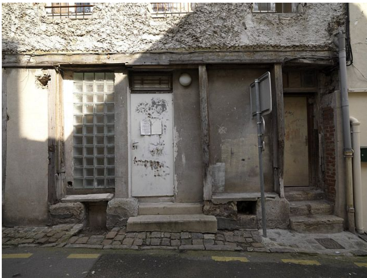
Maison 4, impasse du Tan : détail des vestiges de pan-de-bois au rez-de-chaussée.
