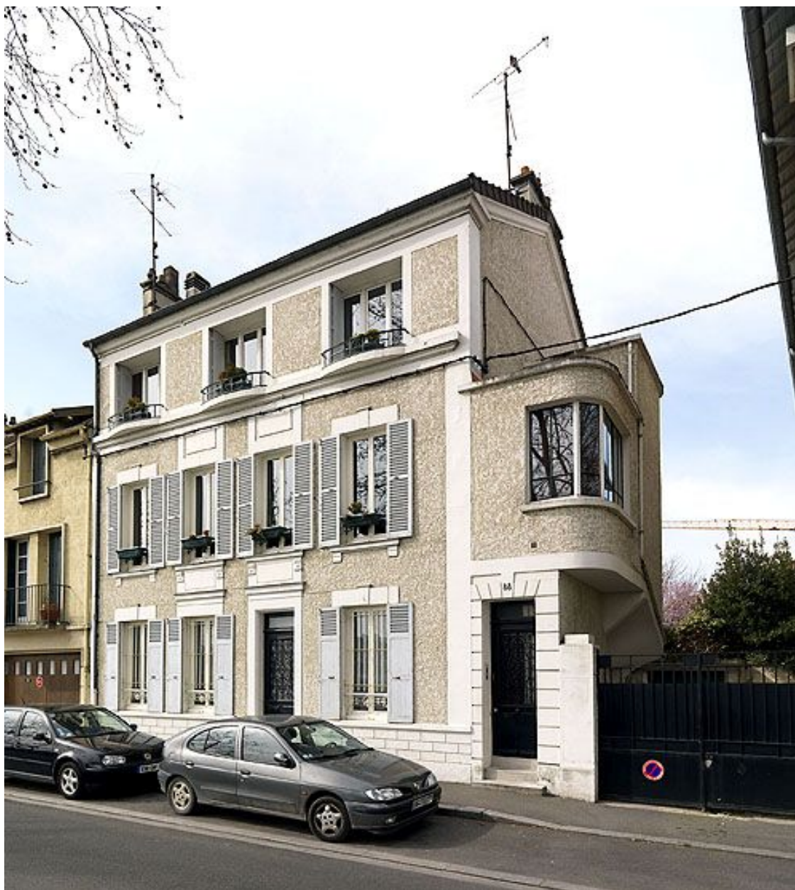
Maison 88 quai Sadi-Carnot : vue d'ensemble, depuis le nord-est. Cette maison du XIXe siècle, à un étage, a été surélevée durant l'entre-deux-guerres et flanquée d'un escalier hors-oeuvre modifiant les accès.
