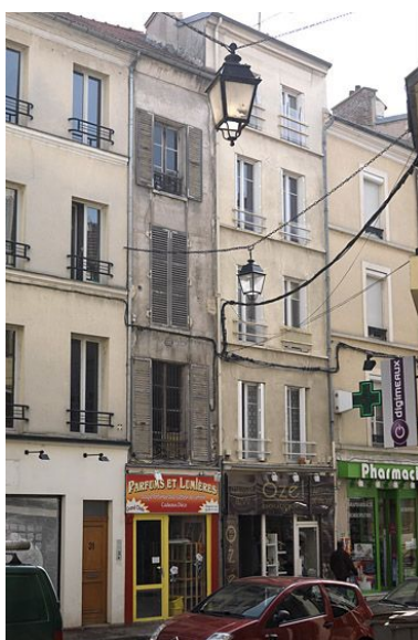
Alignement de maisons rue du Grand-Cerf. Le n°33 se signale par son gabarit : maison d'une travée et de trois étages. IVR11_20097700287NUC4A
