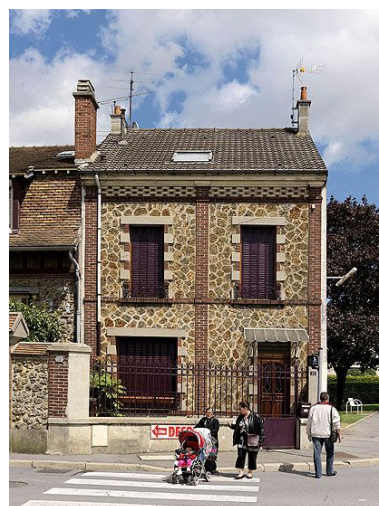
Maison 19 rue de la Crèche : logis du début du XXe siècle, dont la façade joue sur la polychromie des briques et sur une mise en oeuvre particulière de la meulière. IVR11_20117700999NUC4A
