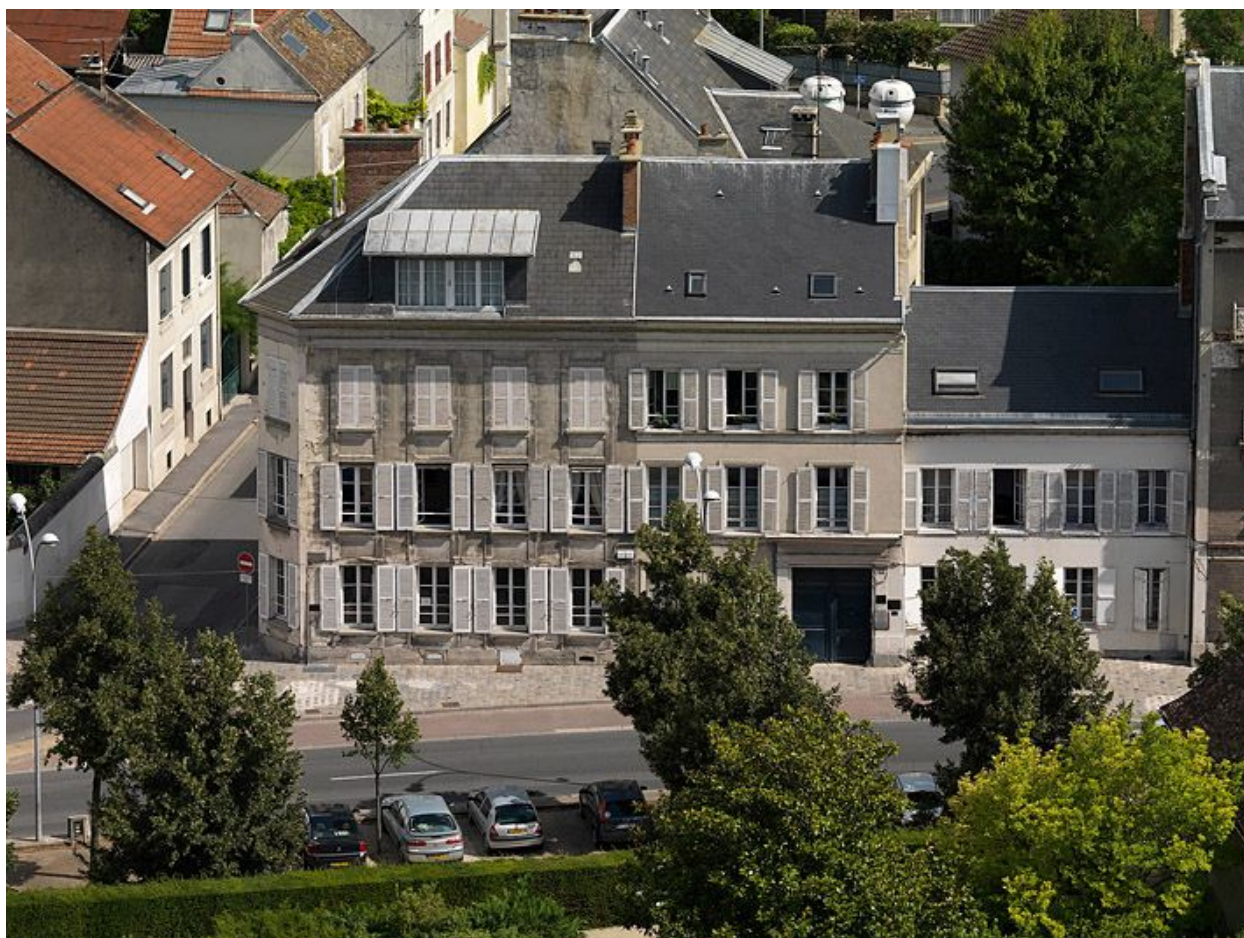
Vue panoramique sur les immeubles à l'angle du boulevard Jean-Rose et de la rue de Chaage, depuis le clocher de la cathédrale.
