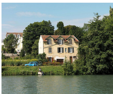
Maison quai Maréchal Mortier : vue d'ensemble, depuis l'autre rive de la Marne. IVR11_20127700813NUC4A
