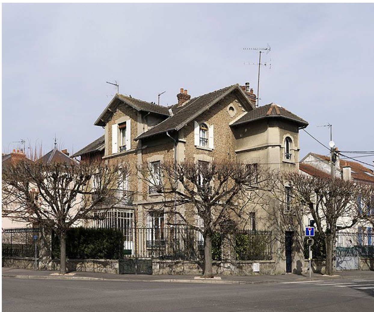
Maison 39-41 rue Gambetta, vue depuis l'avenue de la République. Cette maison présente deux accès, l'un donnant directement sur la rue, l'autre ouvrant sur le jardinet antérieur, avec véranda.
