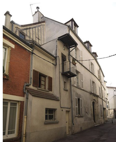
Immeuble 1 rue Antoine-Carro : vue d'ensemble. IVR11_20097700286NUC4A
