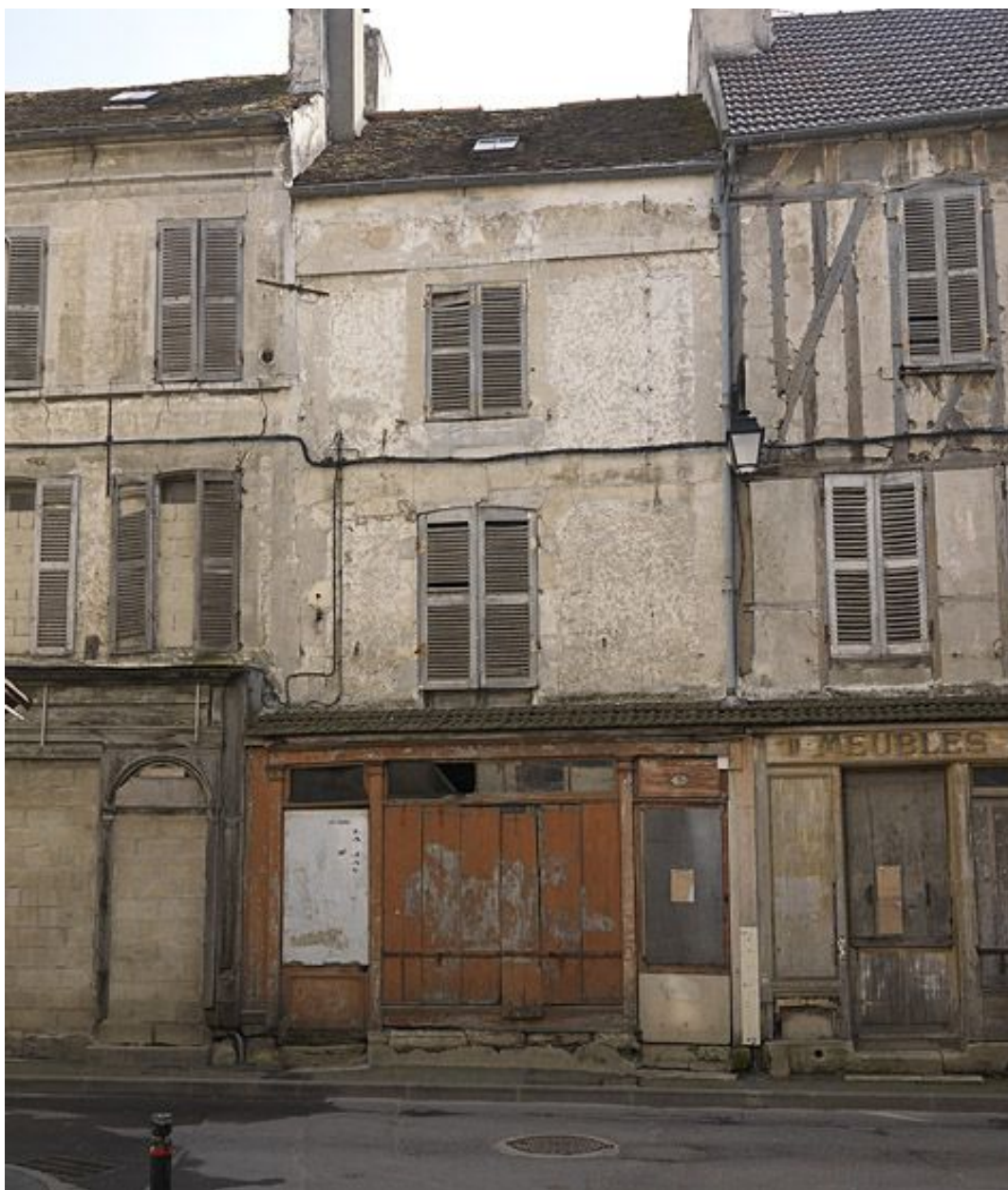
Maison 7 rue du Tan, vue depuis l'impasse du Tan : maison de ville ancienne, de module étroit (deux étages d'une seule travée, sur rez-de-chaussée en boutique).
