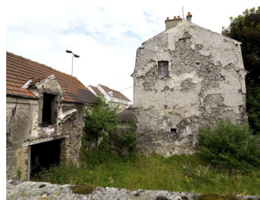
Vue des deux bâtiments, depuis la cour : à gauche, la grange sur rue ; à droite, le mur pignon sud du logis XIX e , en retrait.
