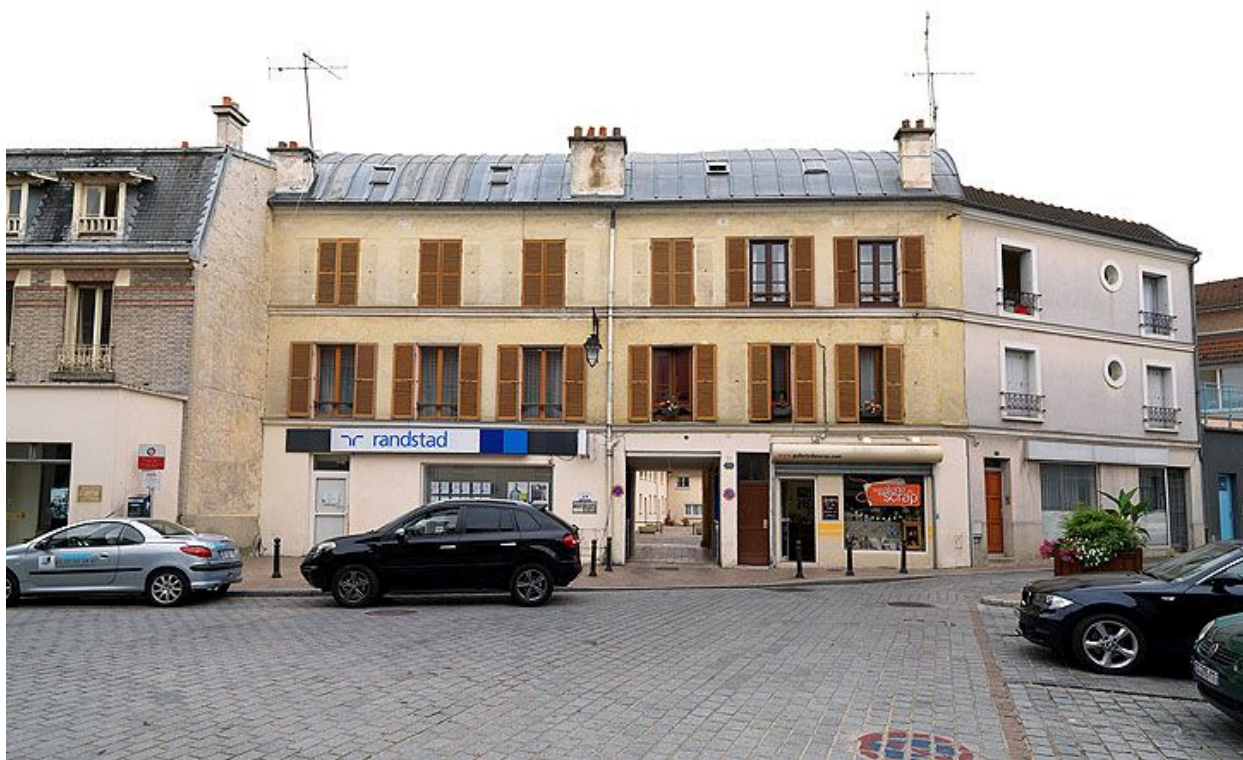
Immeuble à toiture galbée en zinc, 36 rue du faubourg Saint-Nicolas.
