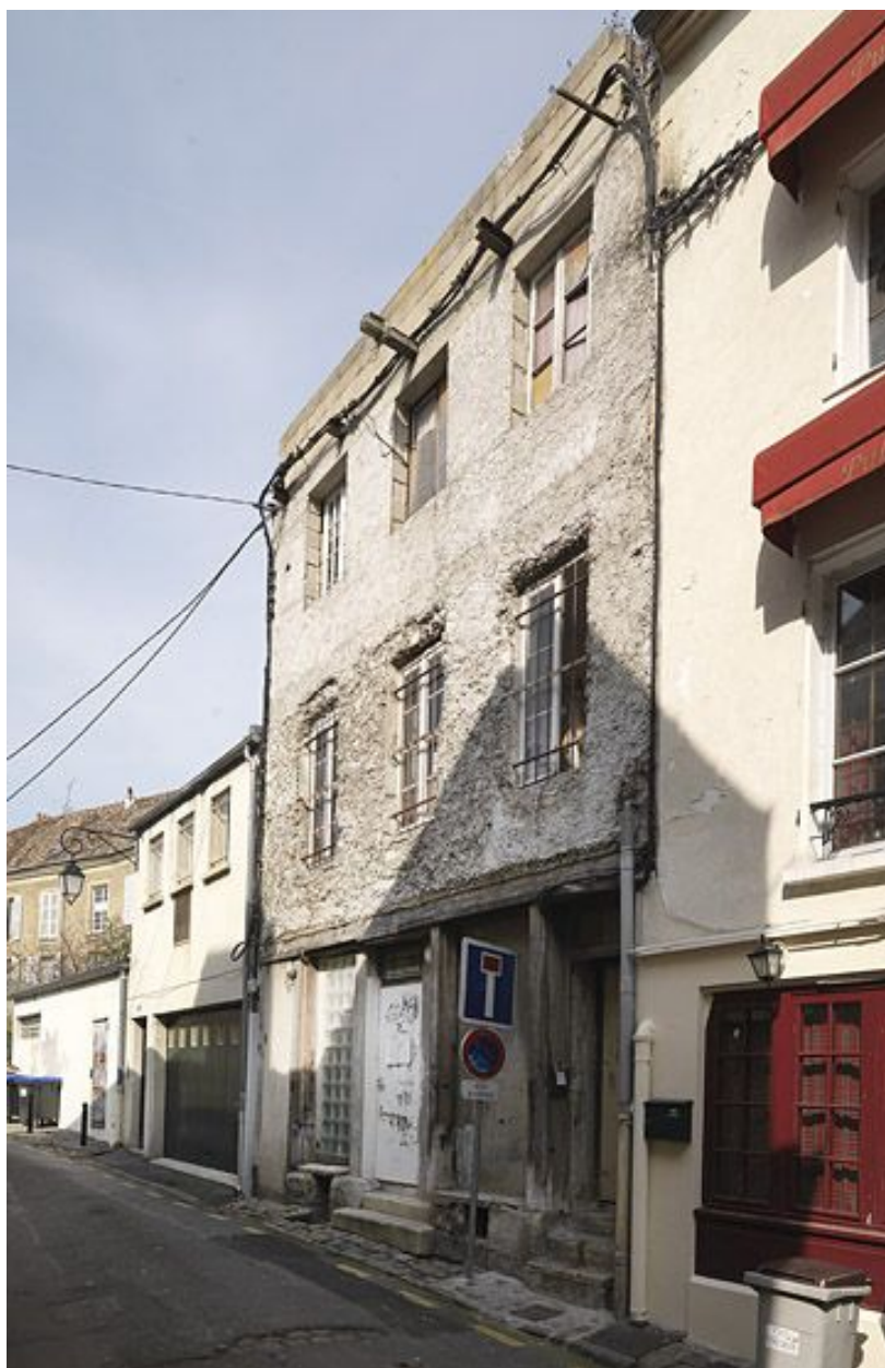
Maison ancienne, 4 impasse du Tan, recouverte d'un enduit de ciment, très dénaturée, mais ayant conservé des vestiges de pan-de-bois en rez-de-chaussée.
