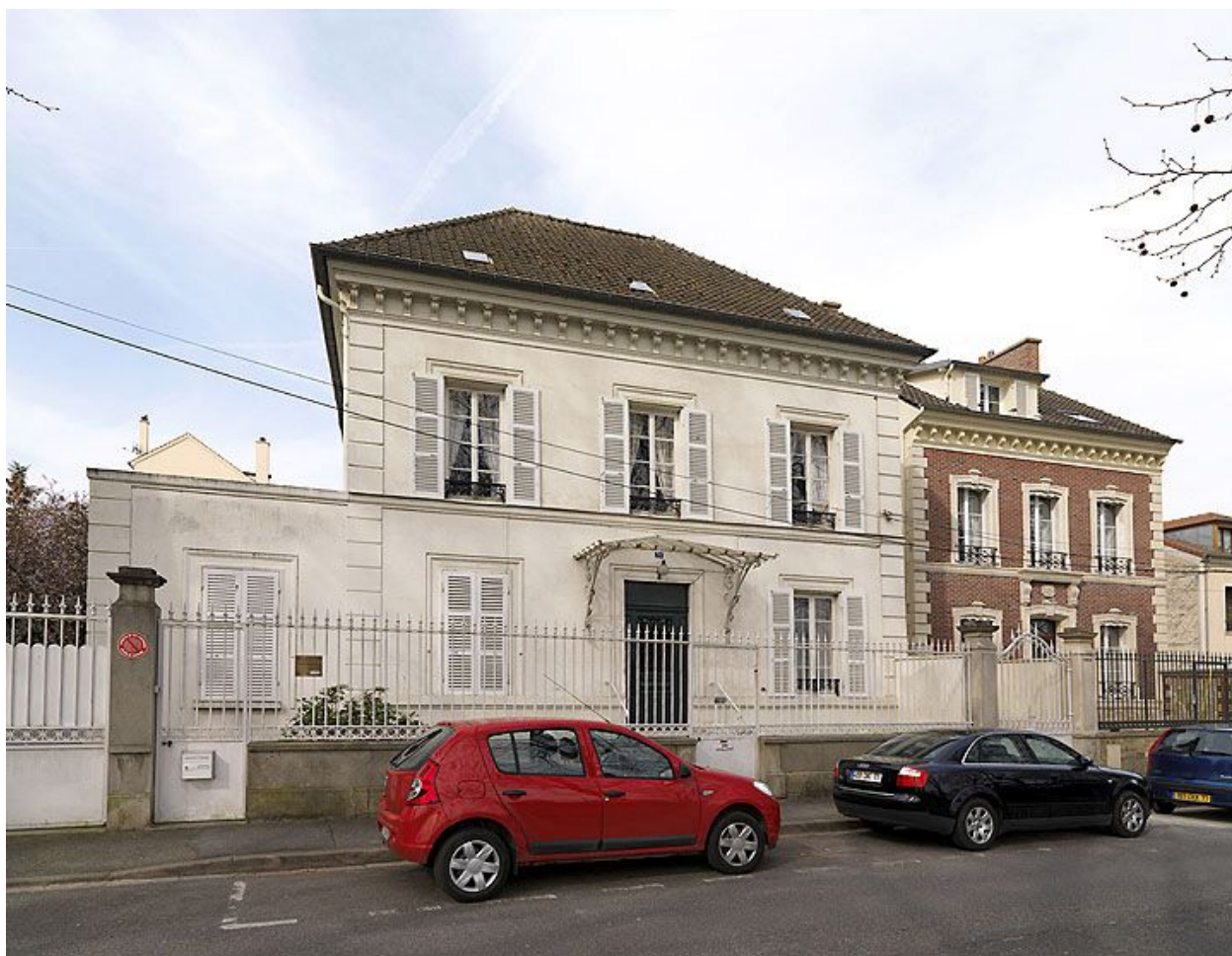
Maison 74 quai Sadi-Carnot : vue d'ensemble, depuis le sud-est.
