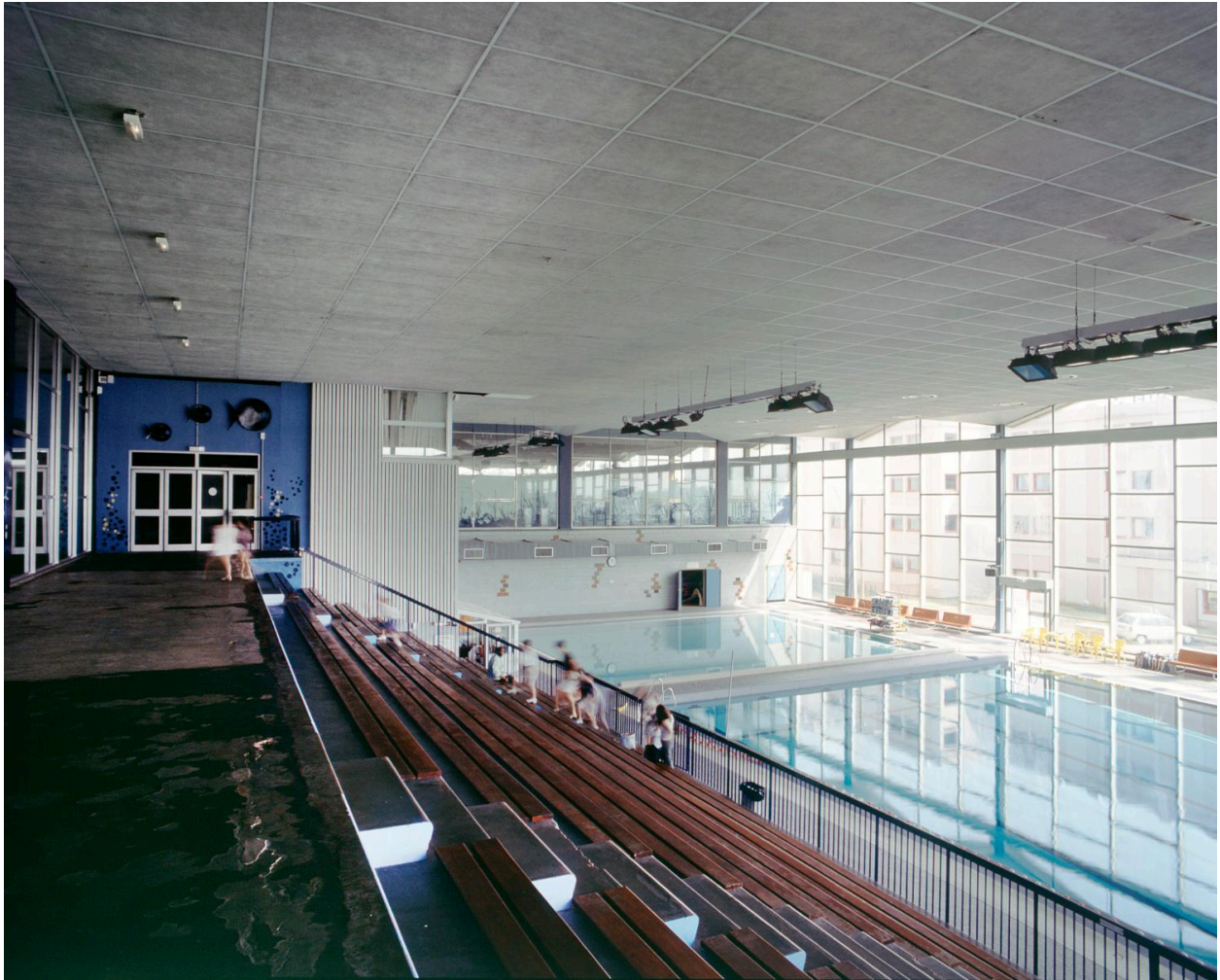
Les bassins et les gradins.
