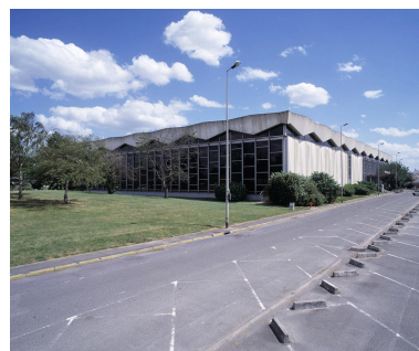
Vue d'ensemble. Phot. Philippe Ayrault IVR11_20049100476XA
