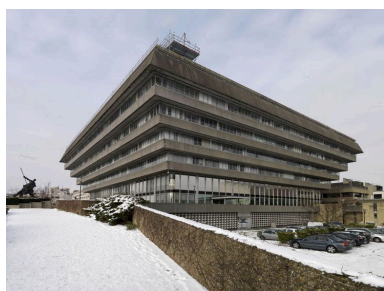
Vue rapprochée. Phot. Philippe Ayrault IVR11_20129500022NUC4A
