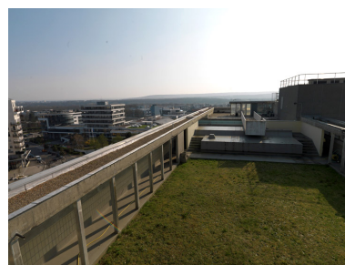
Vue générale du toit de la préfecture. Phot. Philippe Ayrault IVR11_20159500052NUC4A
