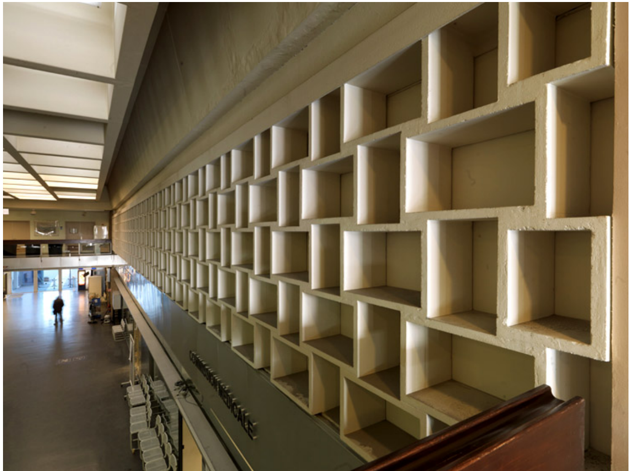
Claustras de béton, au-dessus du hall d'accueil.
