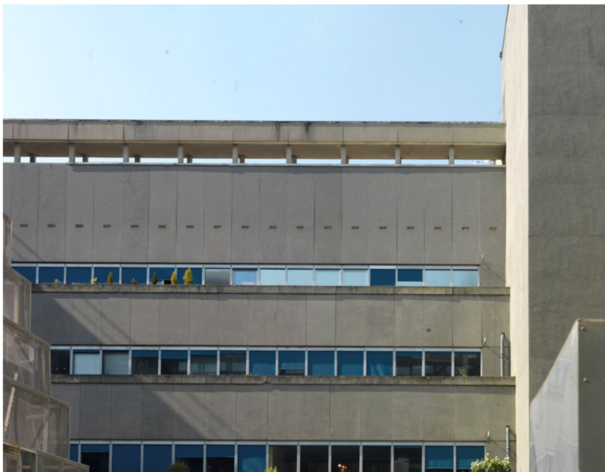
La structure en béton armé de la préfecture, avec son alternance de bandeaux vitrés et de bandeaux minéraux
