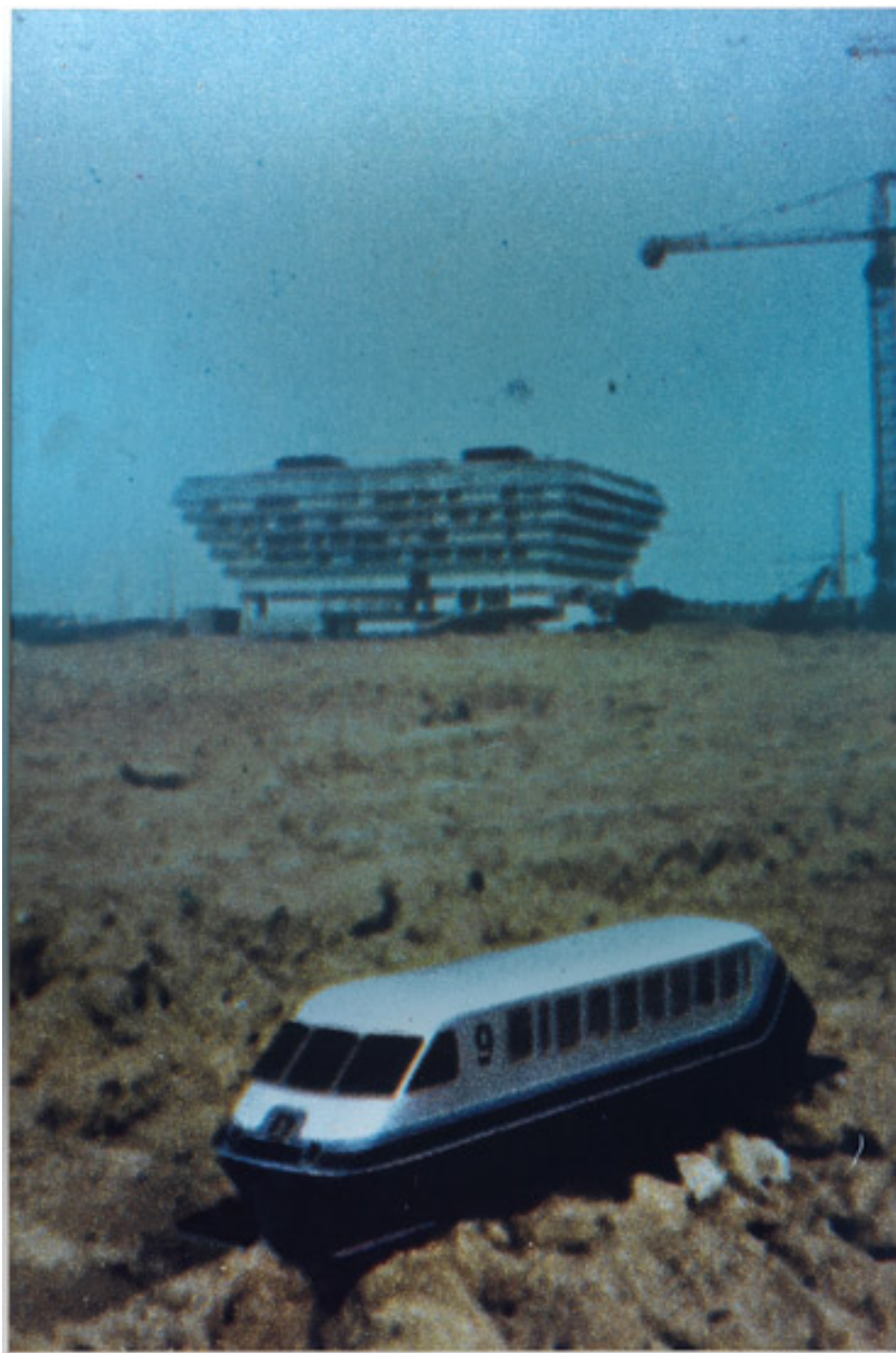
La préfecture en construction (1971), au milieu des anciens champs de betteraves. Au premier plan, le projet d'aérotrain Cergy-La Défense.
