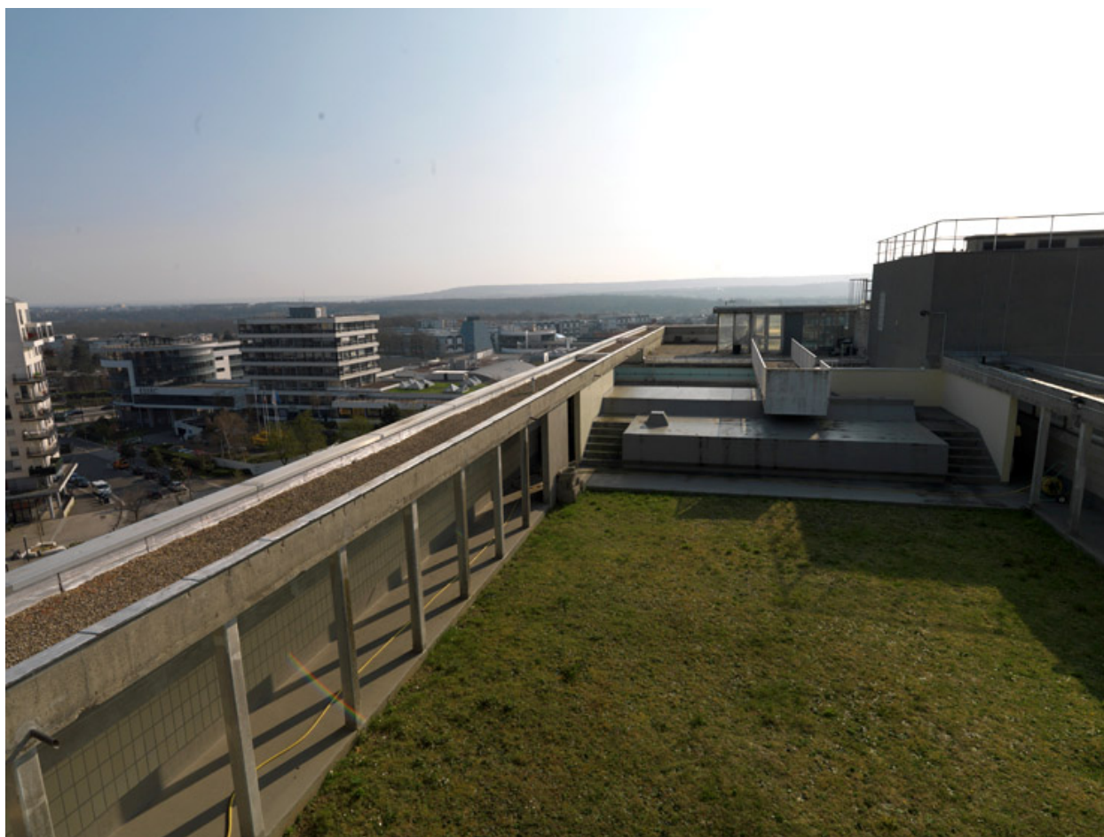
Vue générale du toit de la préfecture.
