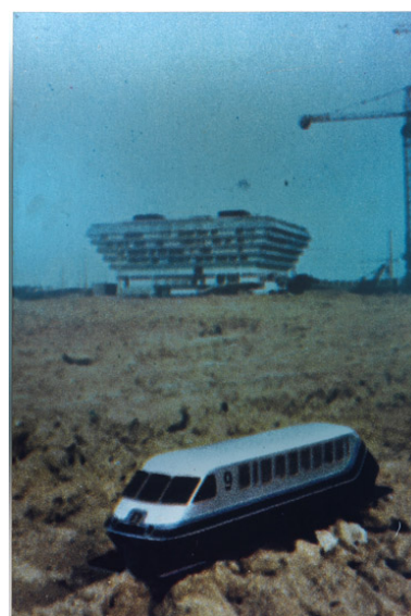
La préfecture en construction (1971), au milieu des anciens champs de betteraves. Au premier plan, le projet d'aérotrain Cergy-La Défense. Phot. Philippe Ayrault IVR11_20159500002NUC4A
