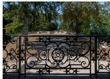
Le travail de ferronnerie des garde-corps est particulièrement soigné ; ici le balcon de la façade postérieure offrant un belvédère sur l'Oise. Phot. Laurent Kruszyk IVR11_20229500320NUC4A
