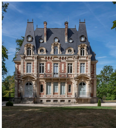
Vue générale du château. Phot. Laurent Kruszyk IVR11_20229500316NUC4A
