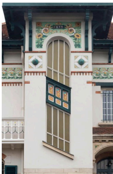
Vue de la tour d'escalier en demi-hors oeuvre sur la façade. Phot. Philippe Ayrault IVR11_20177800169NUC4A
