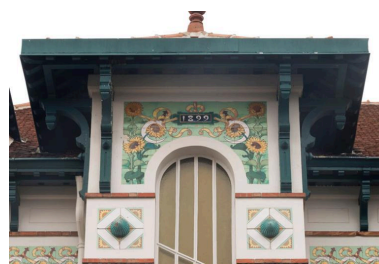
Décor ornant le faite de l'escalier. Il porte la date de 1899. Phot. Philippe Ayrault IVR11_20177800167NUC4A
