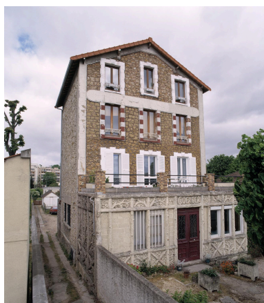
Vue d'ensemble. Phot. Philippe Ayrault IVR11_20029100761XA
