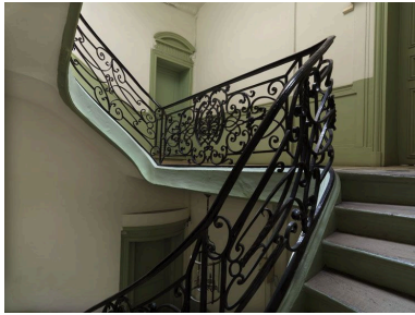
Vue du palier du 2ème étage à partir duquel le motif se simplifie. Phot. Philippe Ayrault IVR11_20107500263NUC4A
