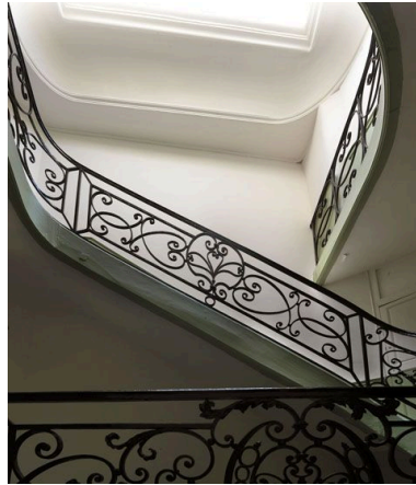
Vue d'une supérieure volée où le motif se simplifie. Phot. Philippe Ayrault IVR11_20107500262NUC4A
