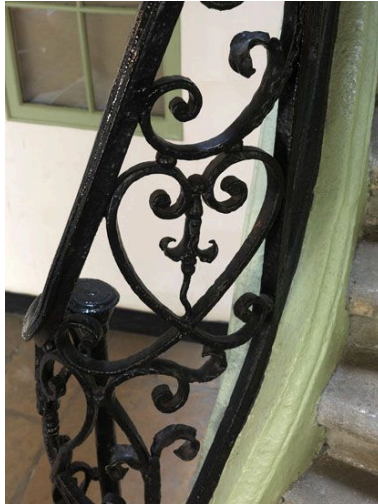
Détail du départ de l'escalier. Phot. Philippe Ayrault IVR11_20107500257NUC4A
