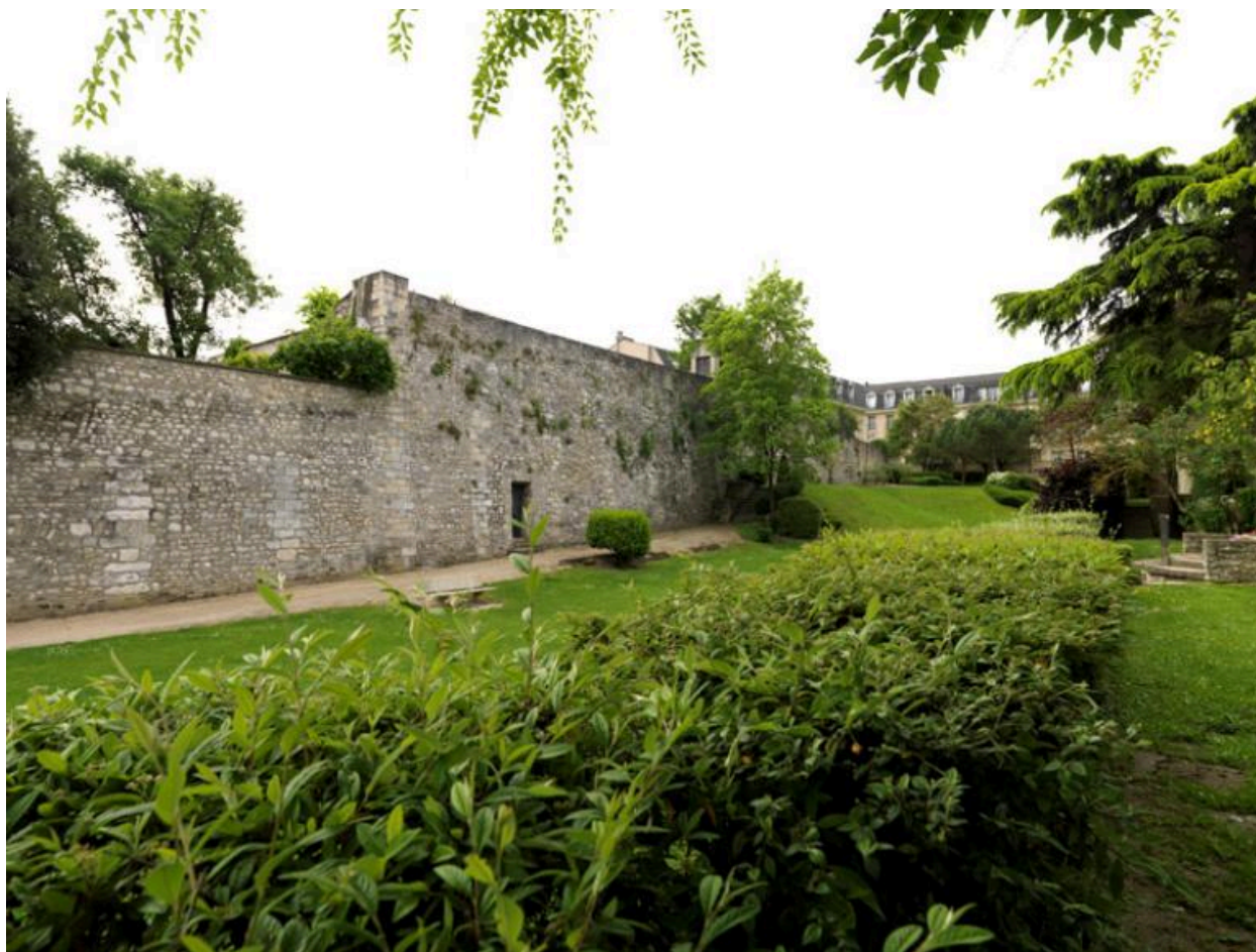
Vue d'ensemble du jardin public Gabrielle d'Estrées aménagé dans le ravelin de la porte Chante-à-l'oie.
