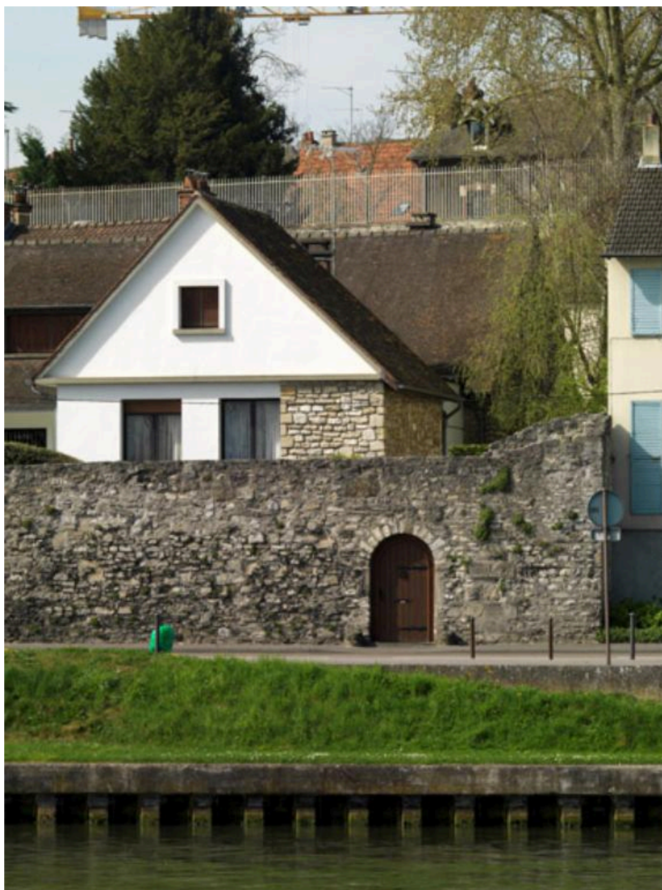
Vestige du rempart le long du quai des Cordeliers. Accès privé récent.
