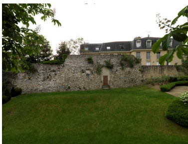
Vestiges de la muraille donnant sur le ravelin de la porte Chante-à-l'Oie. Phot. Laurent Kruszyk IVR11_20157800269NUC4A
