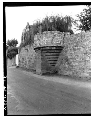
L'échauguette quai des Cordeliers en 1977. Phot. Pascal Corbière IVR11_19777800733X
