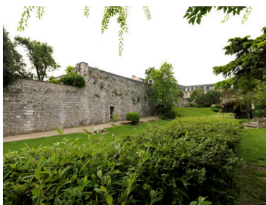
Vue d'ensemble des aménagements privés sur la muraille dominant le ravelin. Phot. Laurent Kruszyk IVR11_20157800272NUC4A
