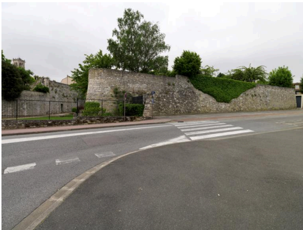
Vue d'ensemble du ravelin de la porte Chante-à-l'oie, l'un des six construits sous Henri III.
