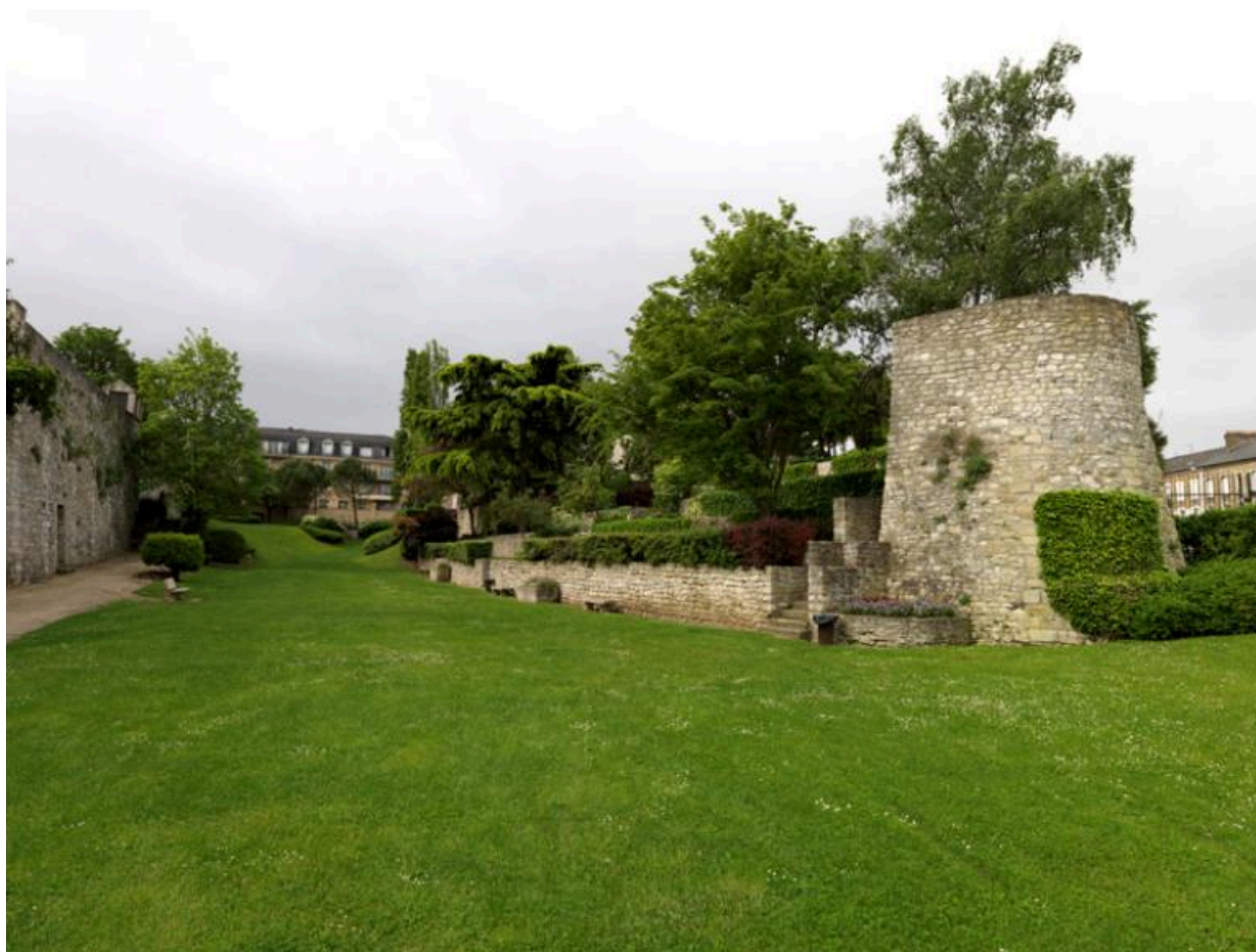
Vue d'ensemble de l'ancien ravelin de la porte Chante-à-l'oie.
