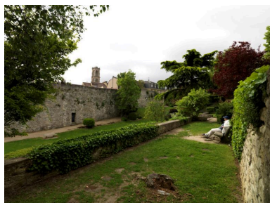
Jardins en terrasse aménagés dans l'ancien ravelin de la porte Chante-à-l'oie. Phot. Laurent Kruszyk IVR11_20157800268NUC4A
