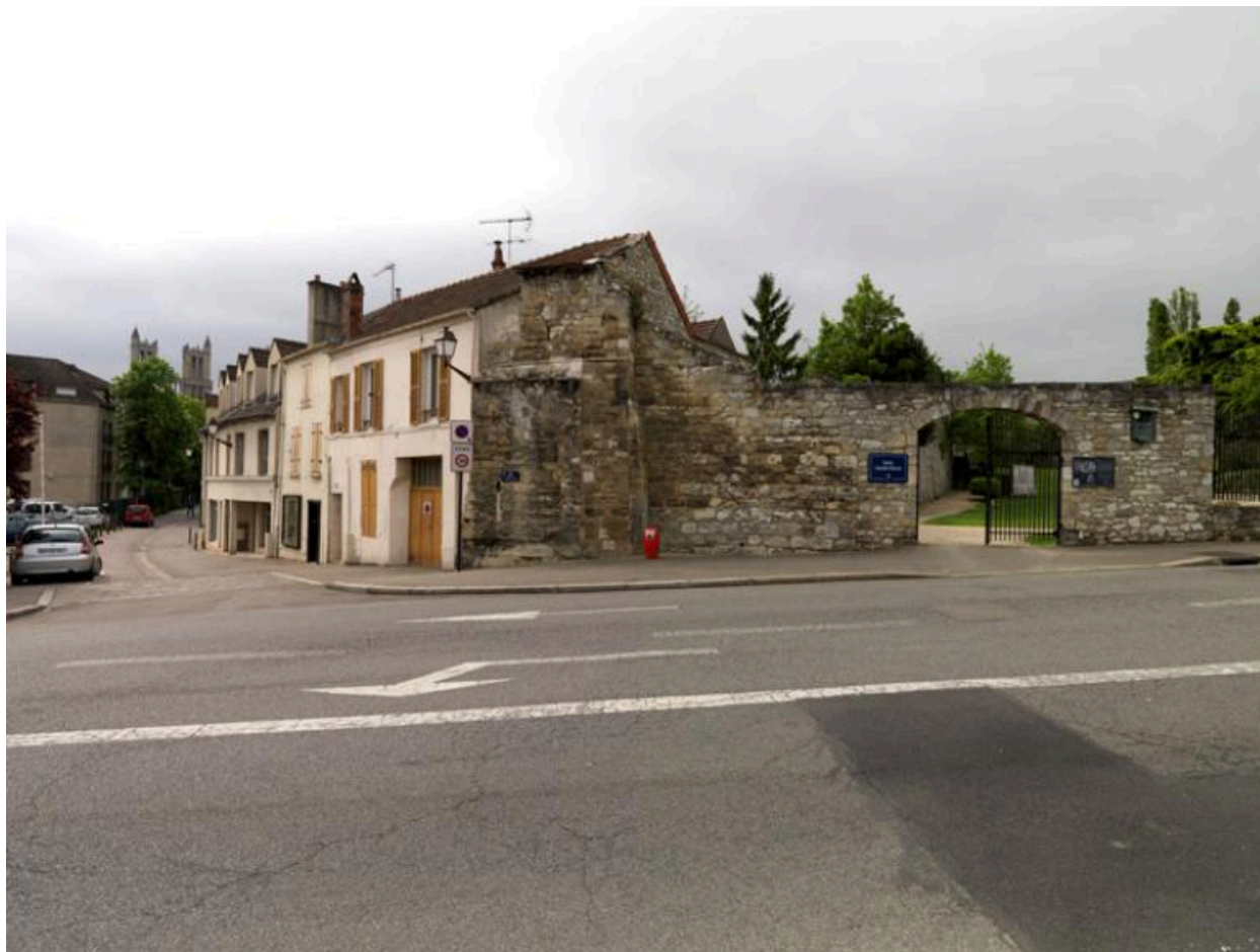
Vestiges de l'ancienne porte Chante-à-l'oie.
