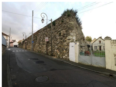
Vestige de mur, rue des Martraits. Phot. Laurent Kruszyk IVR11_20167800687NUC4A
