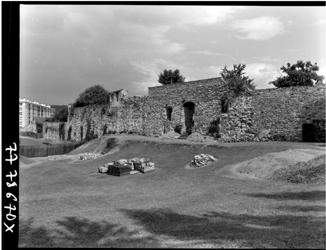
Le square Gabrielle d'Estrées en 1977. On aperçoit des vestiges de l'ancienne chapelle saint-Roch.
