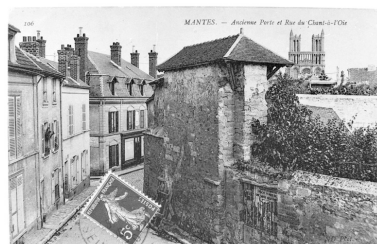
Vue de la porte Chante à l'Oie détruite. Carte postale. (Région Ile-de-France, fonds CREDOP) Repro. CREDOP IVR11_20157800093X
