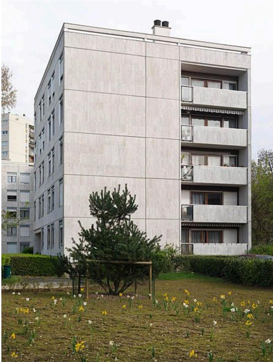
Ce pignon est constitué de panneaux préfabriqués (système Raymond Camus) en travertin romain. On distingue deux panneaux pleins et panneaux de loggia avec balcon dont le garde-corps est également préfabriqué en travertin, ce qui donne une unité à l'ensemble.
