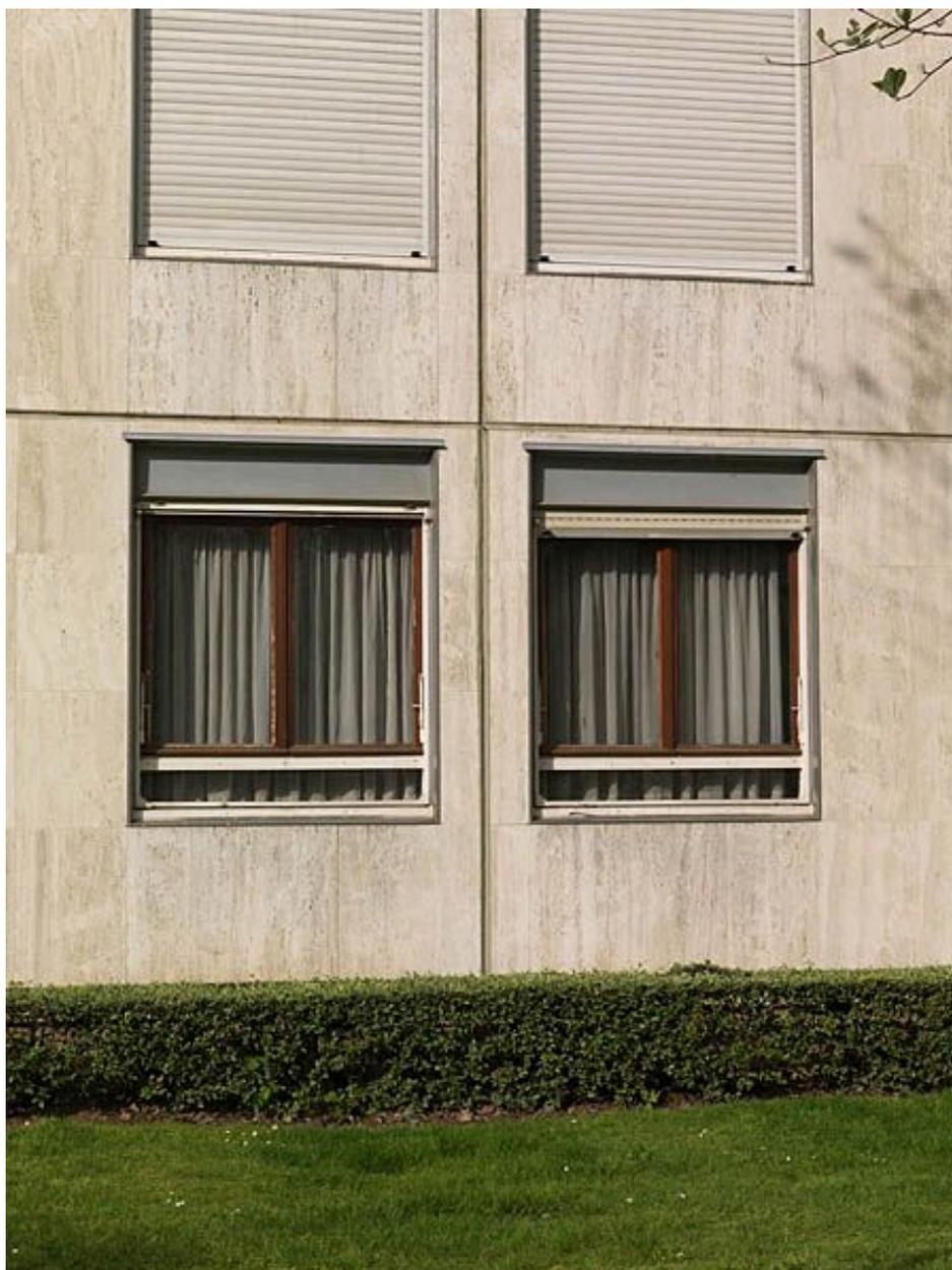
Détail de panneaux de fenêtres. Préfabriqués selon le procédé Raymond Camus, les fenêtres sont placées à gauche ou à droite du panneau ce qui permet de jouer sur la composition de la façade, ici les architectes ont rapprochés les fenêtres.
