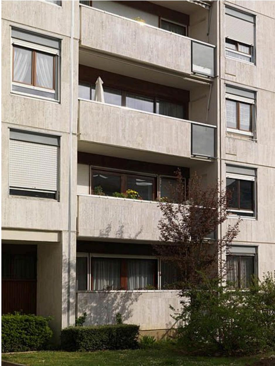
Détail d'une travée de façade composée de panneaux préfabriqués : l'utilisation du travertin romain pour les garde-corps des balcons et le parement créent une unité dans la façade.
