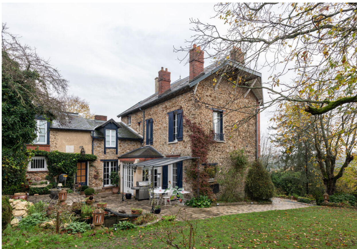
Façade postérieure de la maison principale et son aile perpendiculaire, constituée de la maison du gardien, reliée à la grande maison par l'ajout d'une travée.
