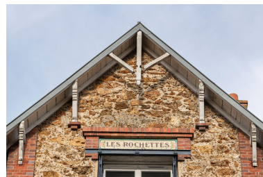
Villa les Rochettes, détail de la façade principale Phot. Laurent Kruszyk IVR11_20229100768NUC4A
