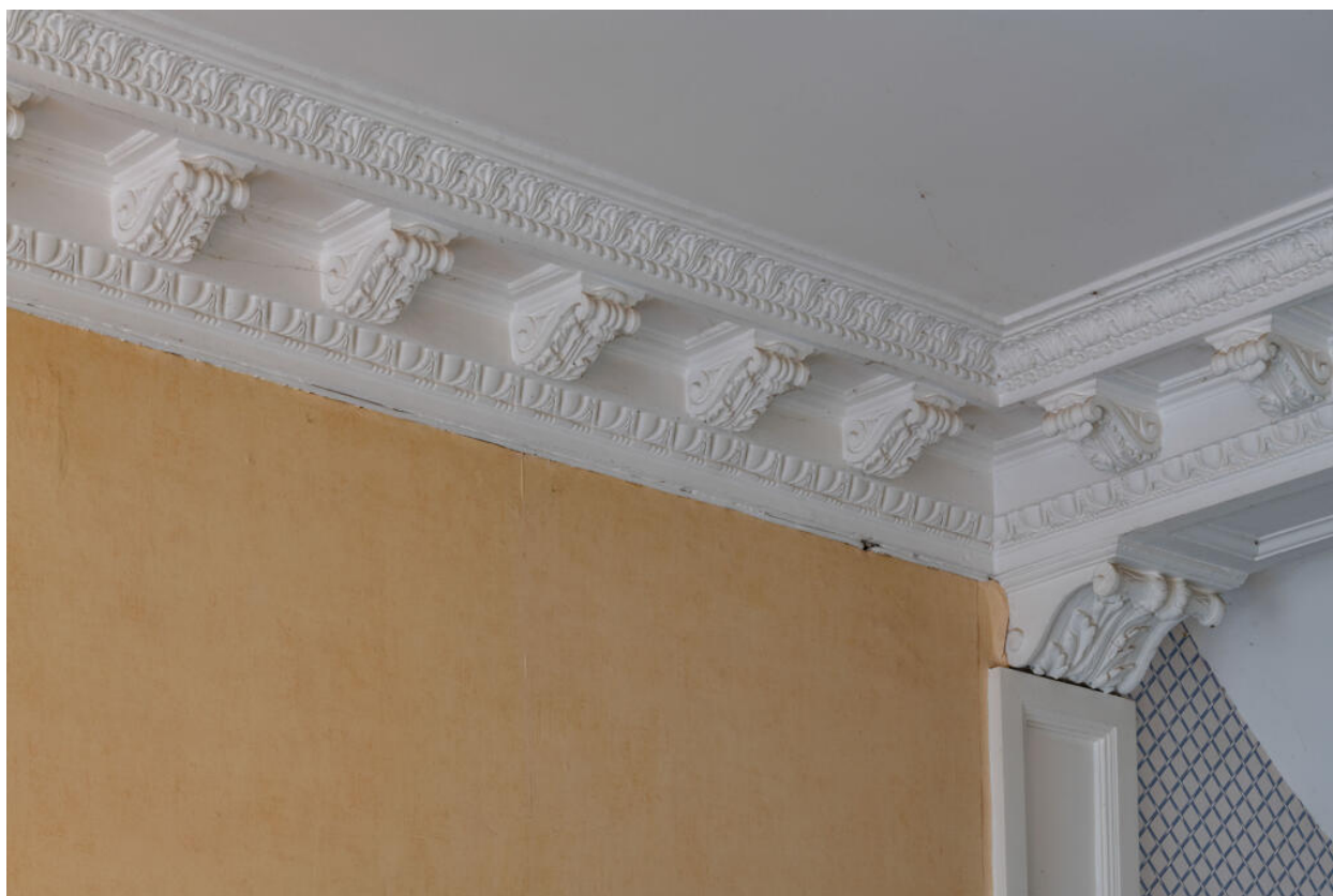
Éléments de décor, corniche à modillons stuqués et chapiteau en console, au rez-de-chaussée
