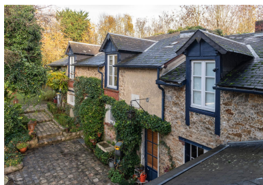
Villa les Rochettes, aile de la maison du gardien Phot. Laurent Kruszyk IVR11_20229100778NUC4A
