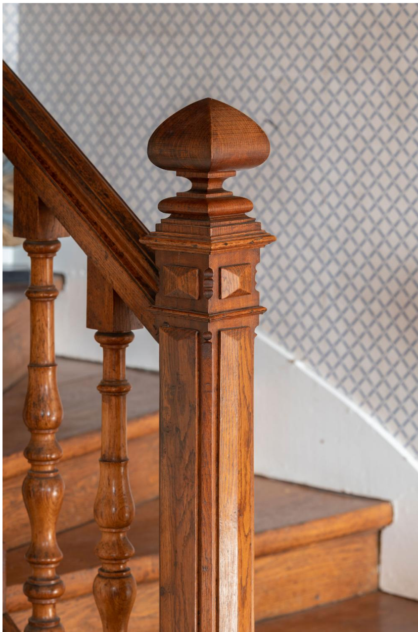
Villa les Rochettes, départ de l'escalier
