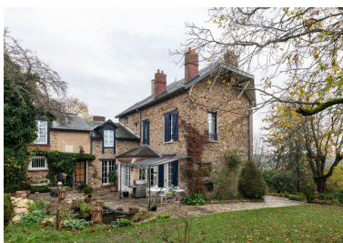
Façade postérieure de la maison principale et son aile perpendiculaire, constituée de la maison du gardien, reliée à la grande maison par l'ajout d'une travée. Phot. Kruszyk Laurent IVR11_20229100773NUC4A
