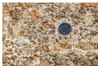
Détail du rocaillage de la façade Phot. Kruszyk Laurent IVR11_20229100771NUC4A
