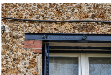
Villa les Rochettes, linteau en acier Phot. Laurent Kruszyk IVR11_20229100772NUC4A
