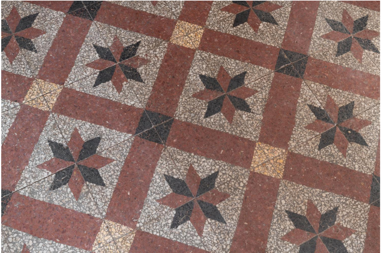
Villa les Rochettes, sol à carreaux de ciment
