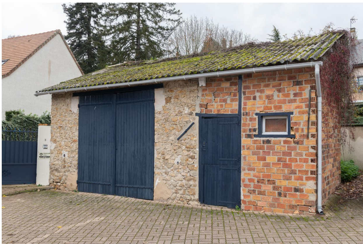
Ancienne écurie à l'entrée de la propriété
