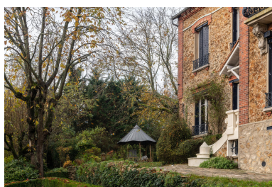
L'escalier et le perron ; au second plan, la gloriette Phot. Kruszyk Laurent IVR11_20229100764NUC4A
