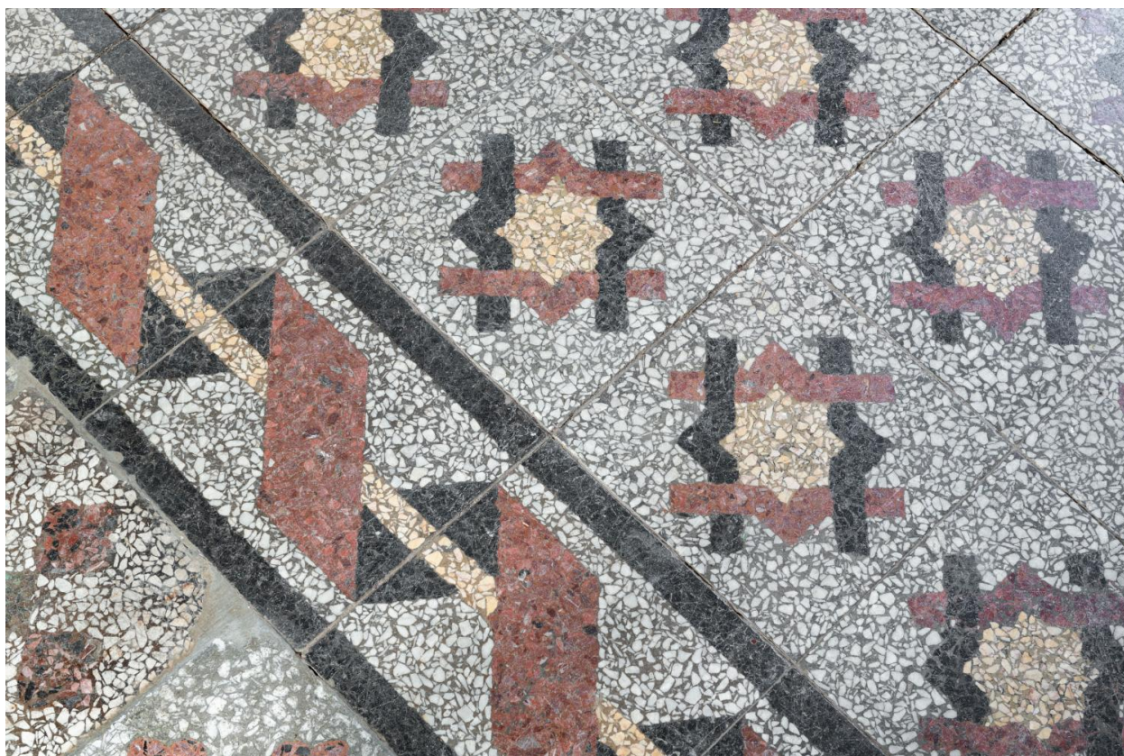
Villa les Rochettes, sol en carreaux de ciment
