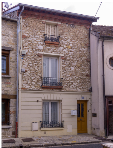
Vue générale depuis le sud. Phot. Asseline Stéphane IVR11_20259100695NUC4A
