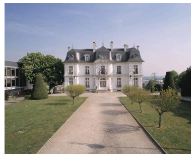
Vue d'ensemble. Phot. Philippe Ayrault IVR11_20029100487XA
