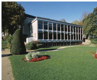
Bâtiment annexe de la mairie construit en 1971 par J. Goldstein. Phot. Philippe Ayrault IVR11_20019100562XA
