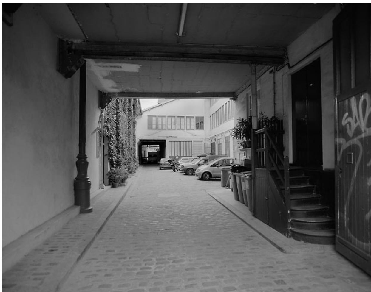
Vue du passage couvert de l'entrée.
