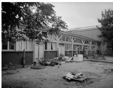
Vue des ateliers dans la seconde cour. Phot. Jean-Bernard Vialles IVR11_20019300355X
