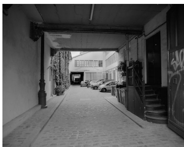
Vue du passage couvert de l'entrée. Phot. Jean-Bernard Vialles IVR11_20019300347X
