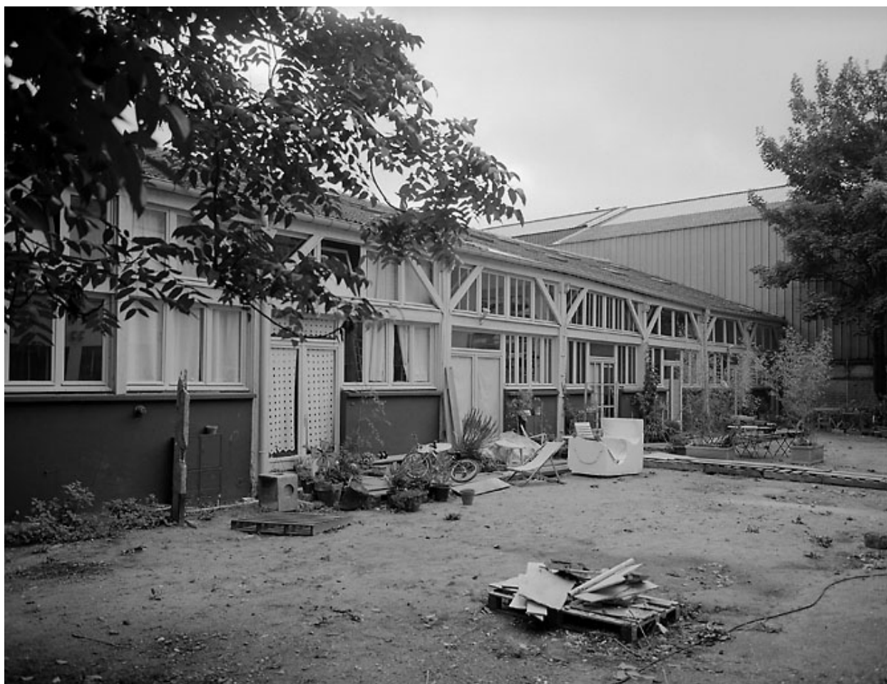
Vue des ateliers dans la seconde cour.
