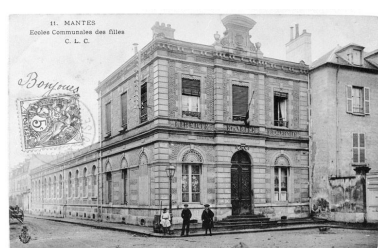
Vue de l'école vers 1900. C'était un bâtiment en brique et pierre avec une riche modénature. (Carte postale) Repro. CREDOP IVR11_20157800080X
