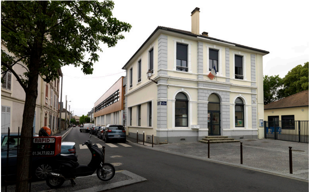
Vue de la façade rénovée sur la place Cassan.
