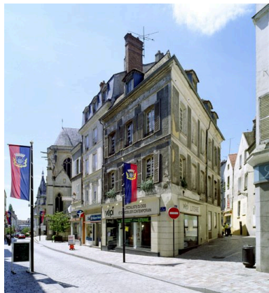
Vue d'ensemble. Phot. Stéphane Asseline IVR11_20037700649VA
