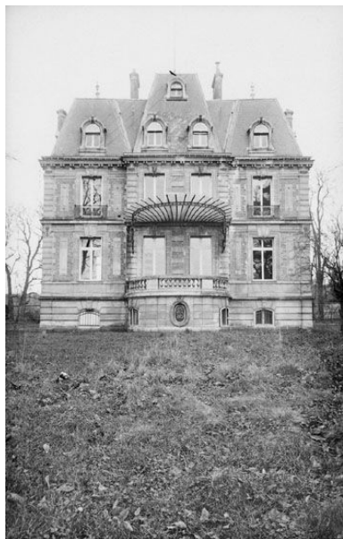
Vue de la façade côté jardin. Photographie, vers 1900. (AD Val-de-Marne. Dépôt des communes, Bry 1M 8) Phot. Philippe Ayrault, Autr. Louis Rémy Sabattier IVR11_20069400593XB
