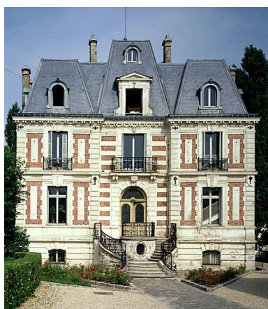
Façade antérieure. Phot. Christian Décamps IVR11_19859401164VA
