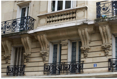
Vue d'un balcon de pierre, rue Ernest Cresson. IVR11_20157500651NUC4A
