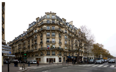
Vue de la façade prise depuis l'avenue du Général-Leclerc. IVR11_20157500643NUC4A
