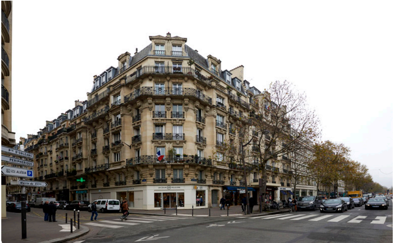
Vue de la façade prise depuis l'avenue du Général-Leclerc.
