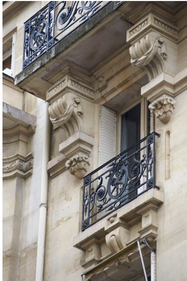
Vue de l'entablement en pierre d'un balcon. IVR11_20157500650NUC4A
