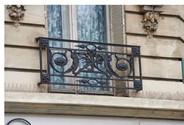
Vue d'un garde-corps, rue Ernest Cresson.
