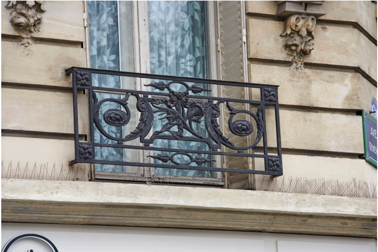
Vue d'un garde-corps, rue Ernest Cresson.
