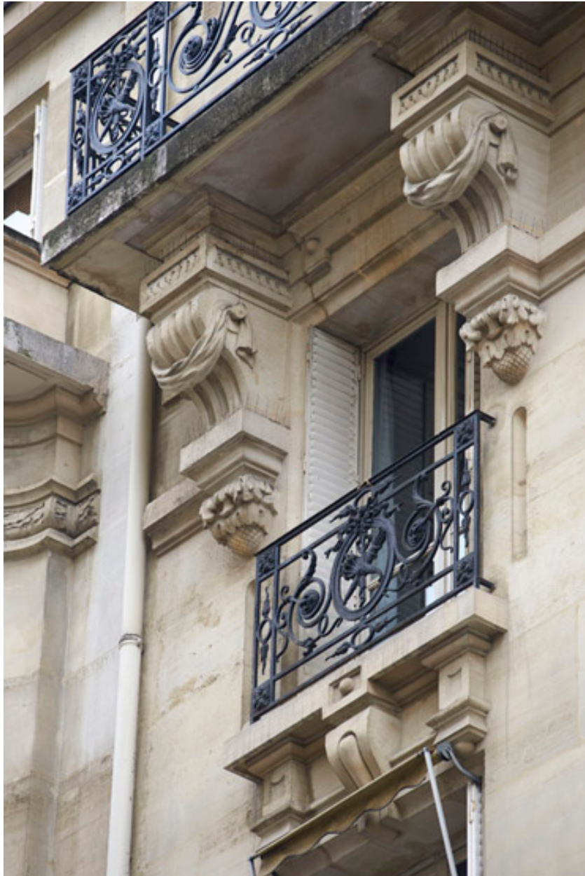
Vue de l'entablement en pierre d'un balcon.
