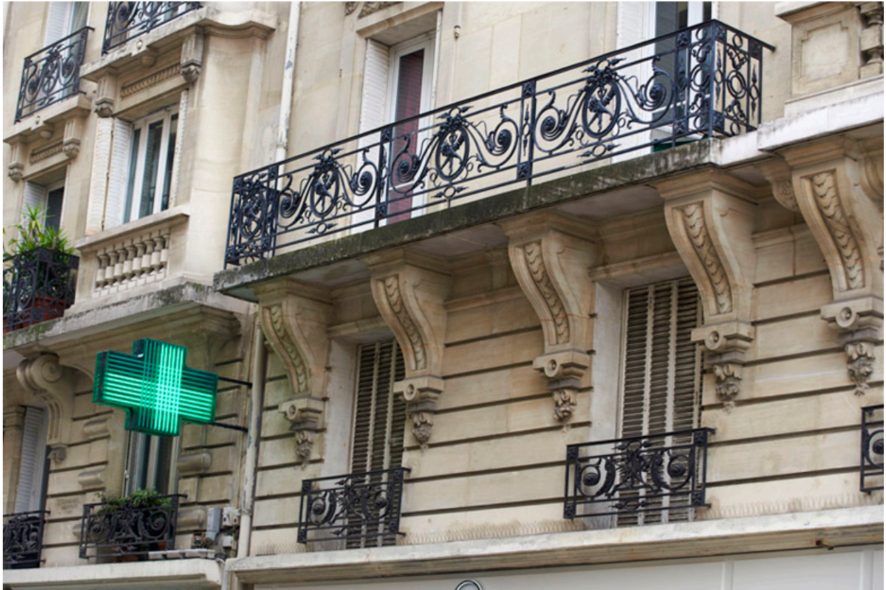
Vue d'un balcon du premier étage, situé rue Ernest Cresson.
