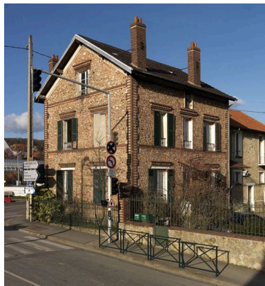
Vue d'ensemble. Phot. Philippe Ayrault IVR11_20087800120NUC4A
