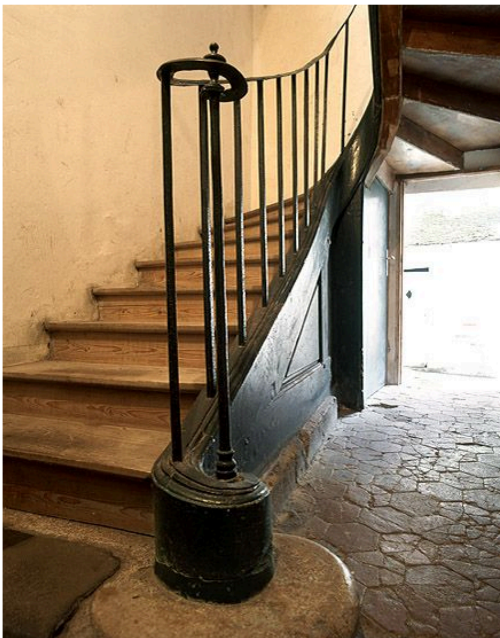
Vue de l'escalier : le départ de la rampe.
