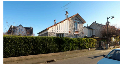
Vue d'une maison individuelle avec extension, 67 rue Saint-Vincent (type A). Phot. Philippe Ayrault IVR11_20167800773NUC4A
