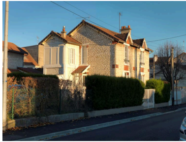
Vue d'une maison jumelle (type A), 69-71 rue Saint-Vincent. Phot. Philippe Ayrault IVR11_20167800788NUC4A
