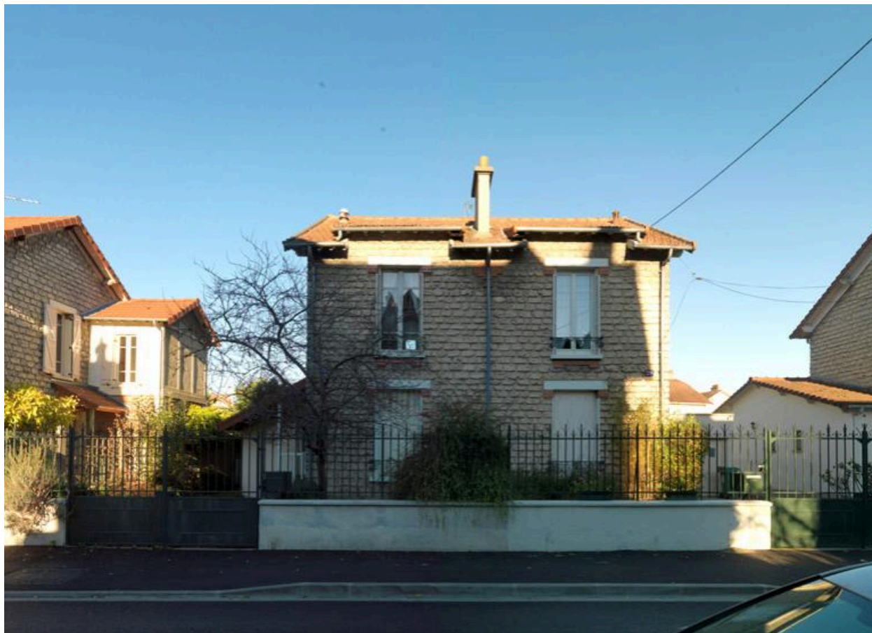
Façade de maison-jumelle (type C), 20-22 avenue Victor Hugo.
