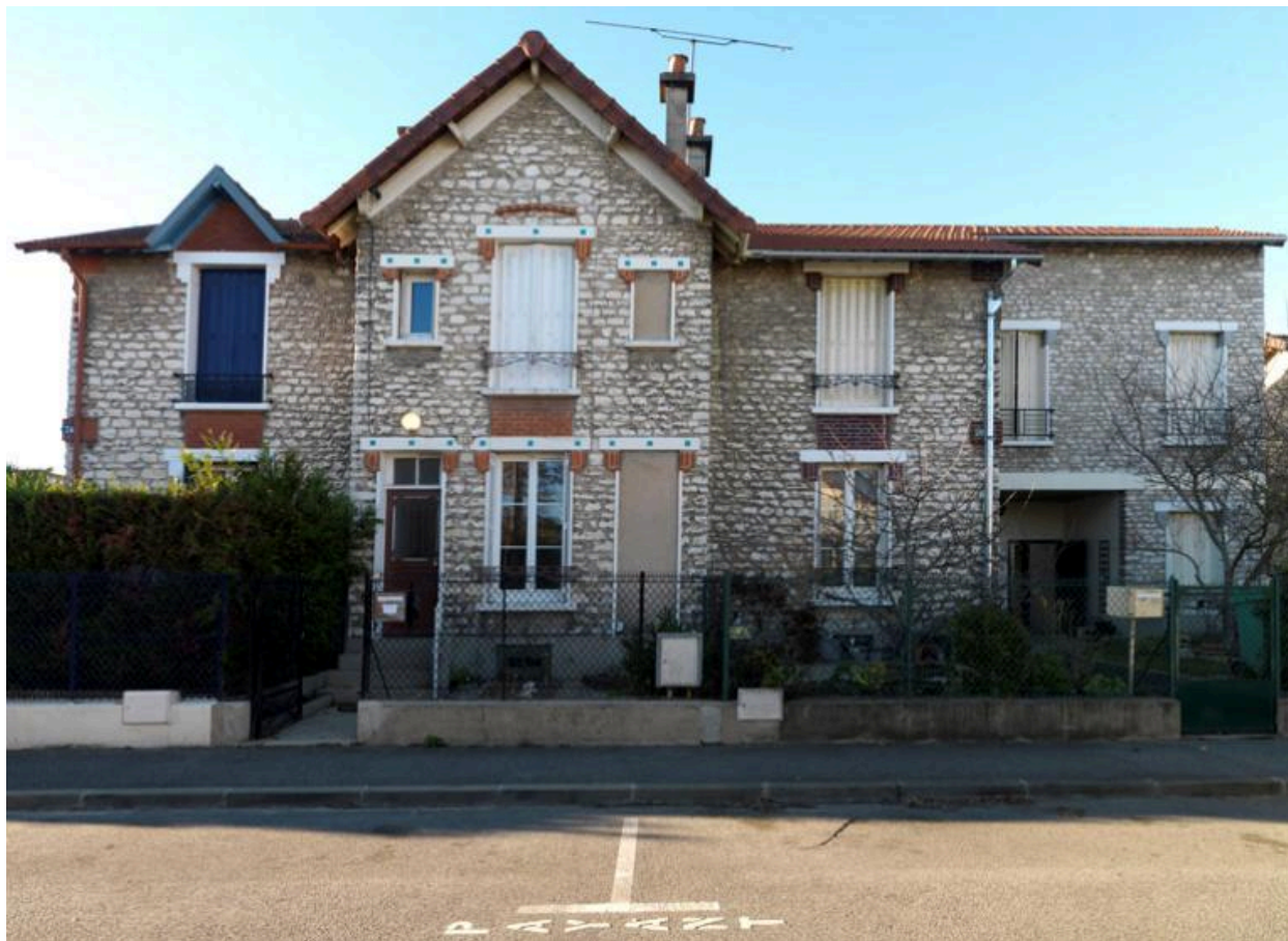
Vue d'une maison triple, 70-72-74 rue Saint-Vincent (type A).
