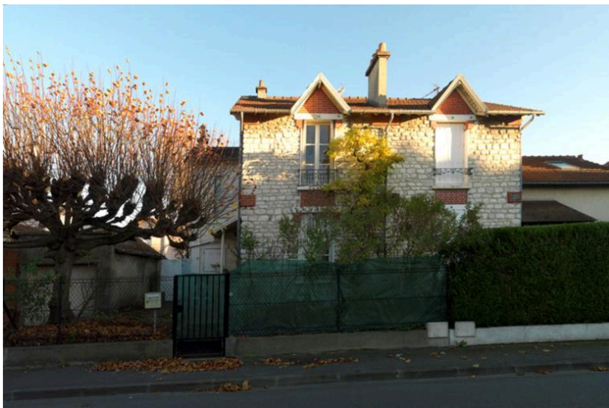
Façade de la maison jumelle (type A), 69-71 rue Saint-Vincent.
