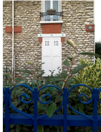
Vue de détail du décor de briques, maison-jumelle 76-78 rue Saint-Vincent (type A). Phot. Philippe Ayrault IVR11_20167800790NUC4A
