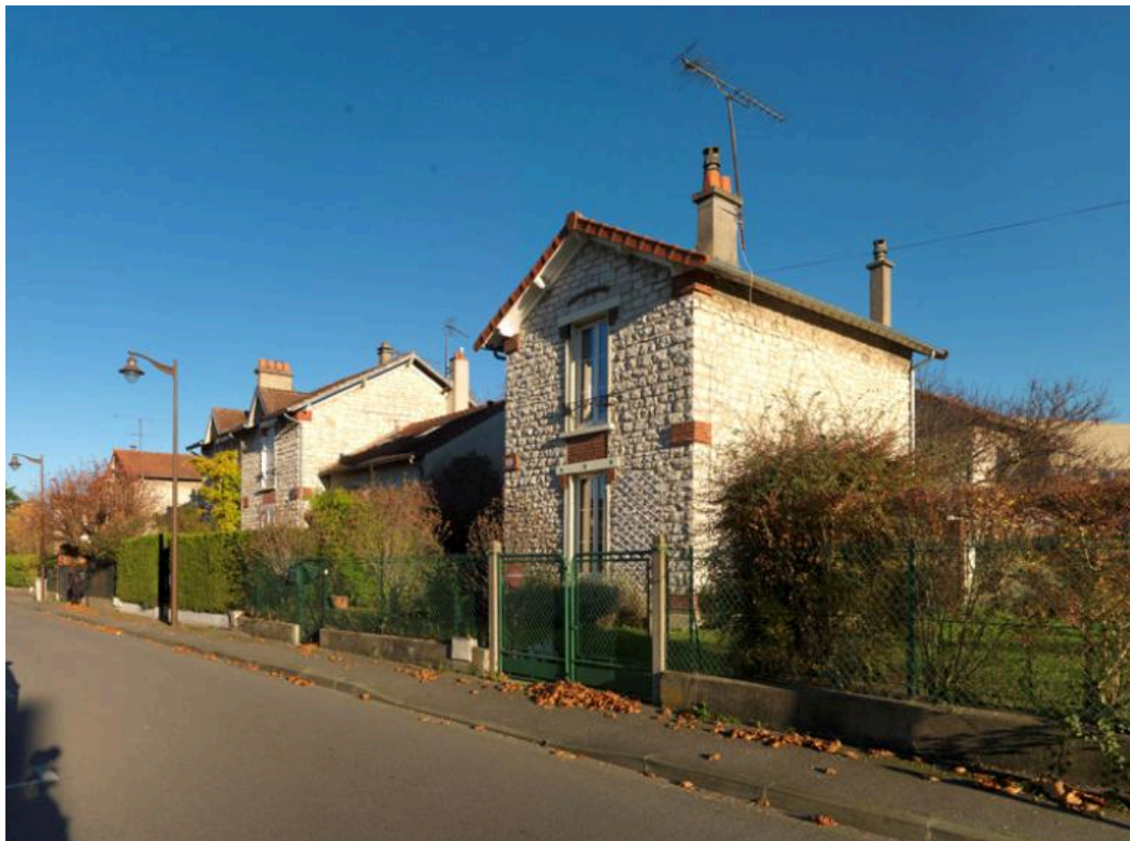
Vue d'une maison individuelle (type A), 73 rue Saint Vincent.
