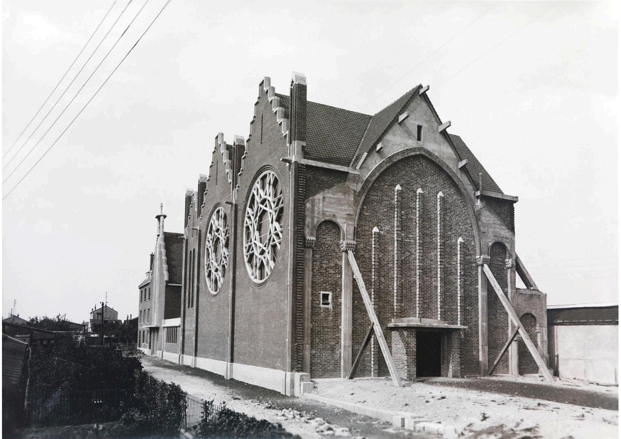
Carte postale ancienne. Eglise Saint-Luc-des-Grands-Champs en construction. Années 1930. (Oeuvre des Chantiers du Cardinal, Paris)
