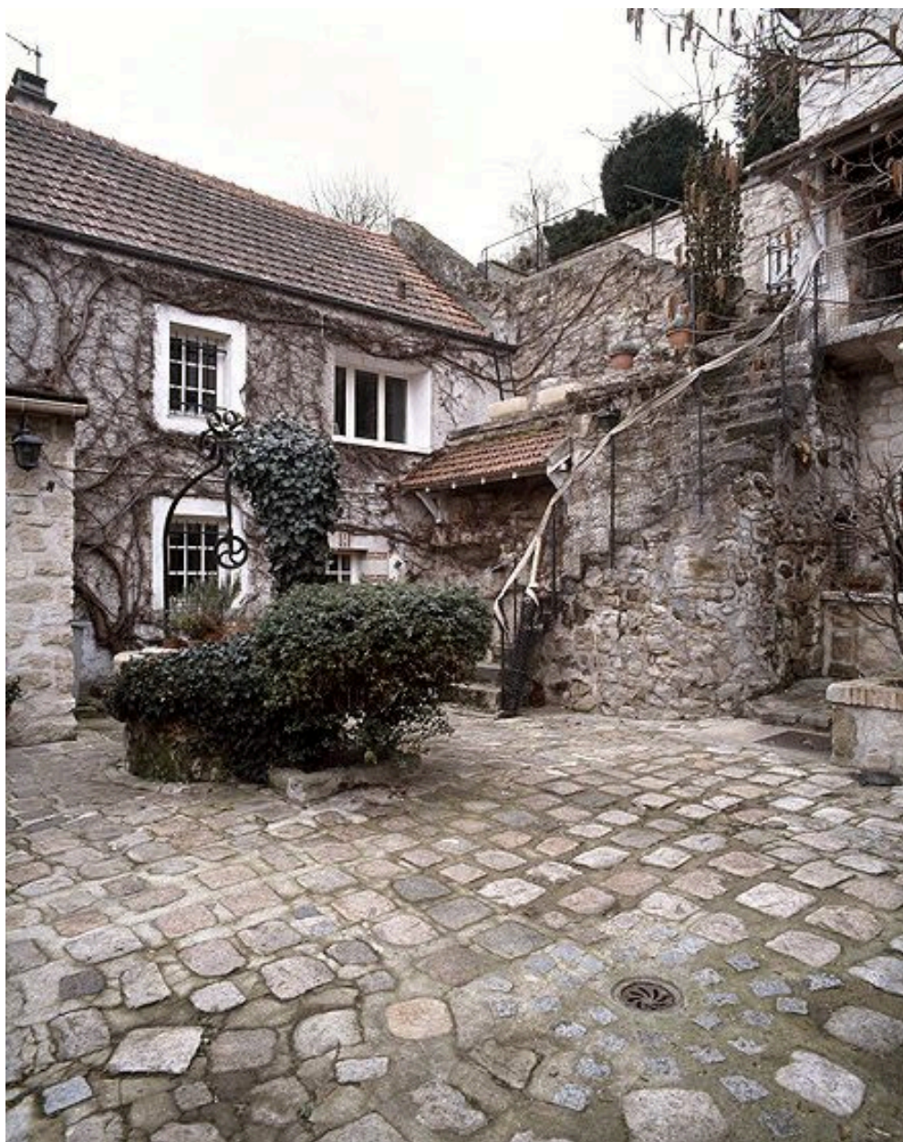
L'escalier conduisant au jardin en terrasse.
