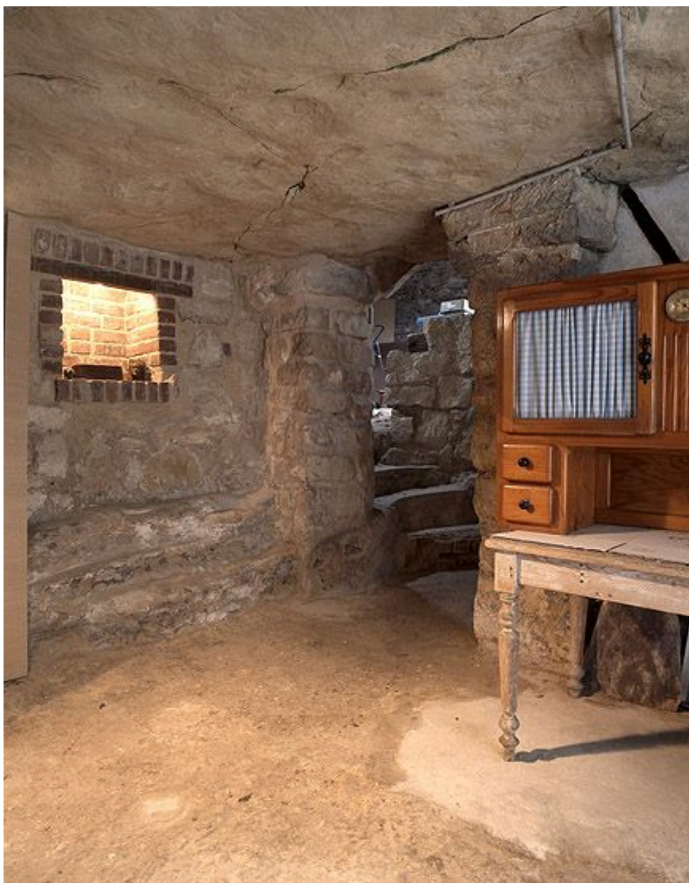
Première cave troglodytique à laquelle on accède depuis la maison et depuis l'extérieur.
