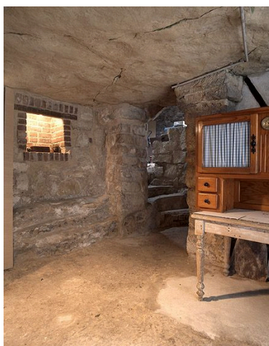
Première cave troglodytique à laquelle on accède depuis la maison et depuis l'extérieur. Phot. Laurent Kruszyk IVR11_20067800278XA
