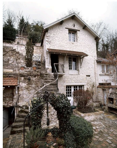
L'ancienne annexe agricole. Phot. Laurent Kruszyk IVR11_20067800267XA
