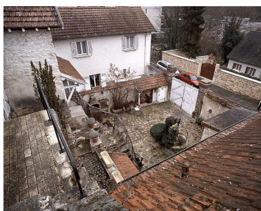
La cour de la maison vue depuis la terrasse supérieure. Phot. Laurent Kruszyk IVR11_20067800272XA
