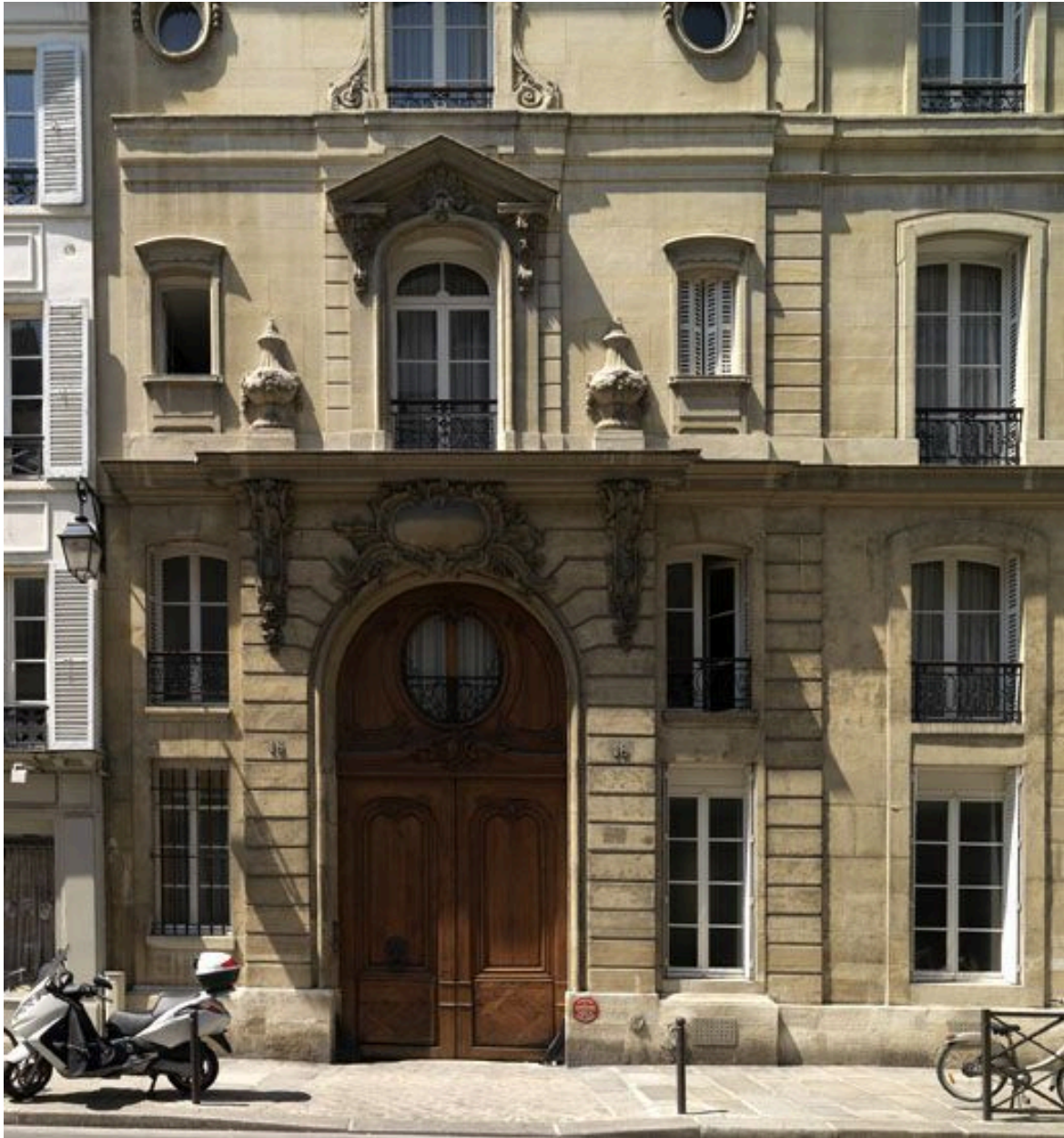
Vue du corps central de la façade sur rue.
