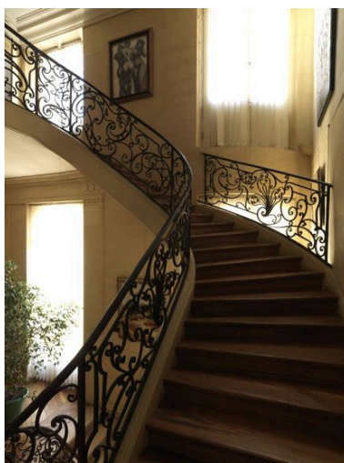
Le panneau rampant qui conduit au repos du second étage. Phot. Laurent Kruszyk
