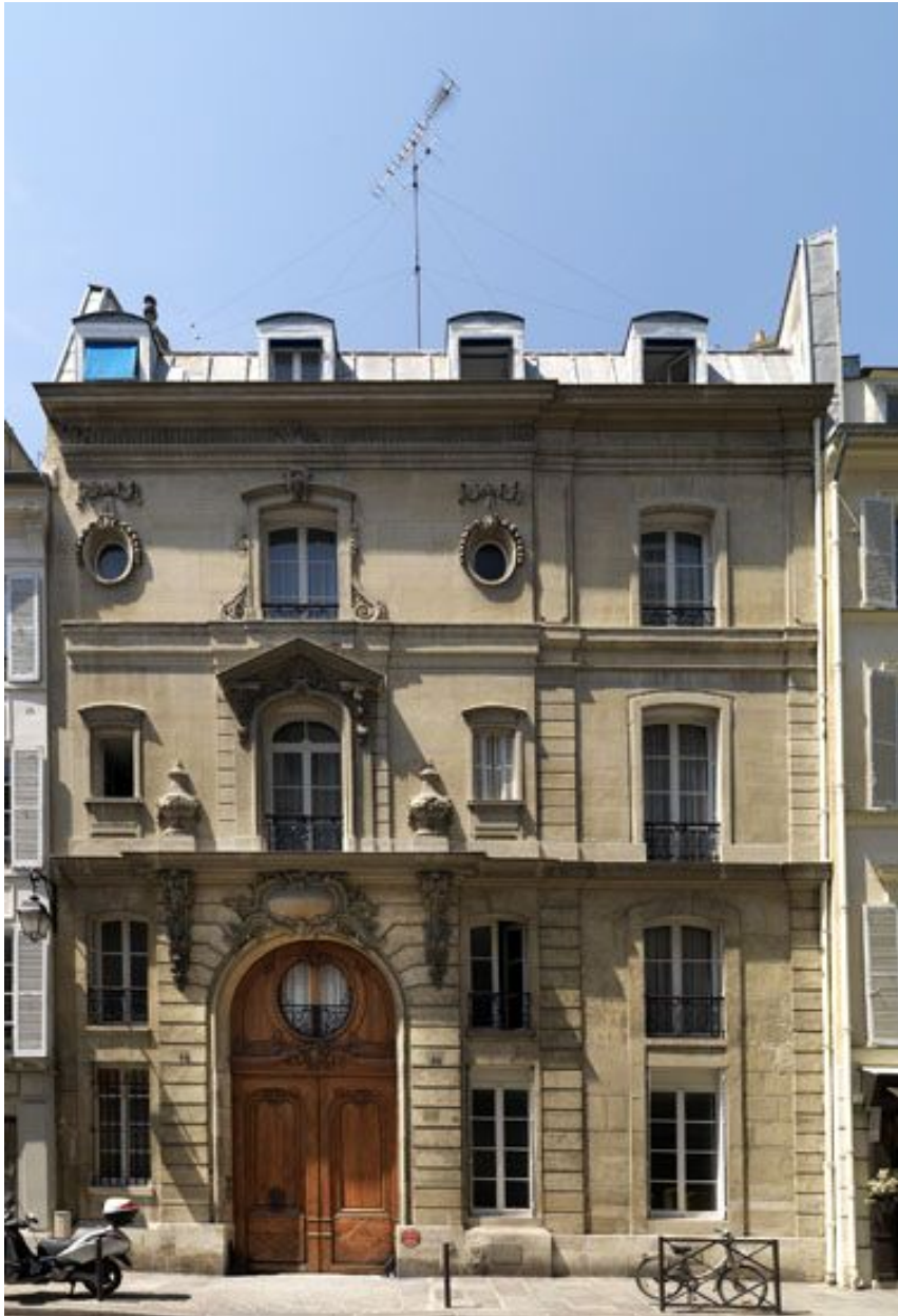
La façade sur rue qui a été surélevée.
