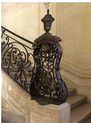
La gaine de départ vue de trois-quart. Phot. Laurent Kruszyk IVR11_20097501073NUC4A
