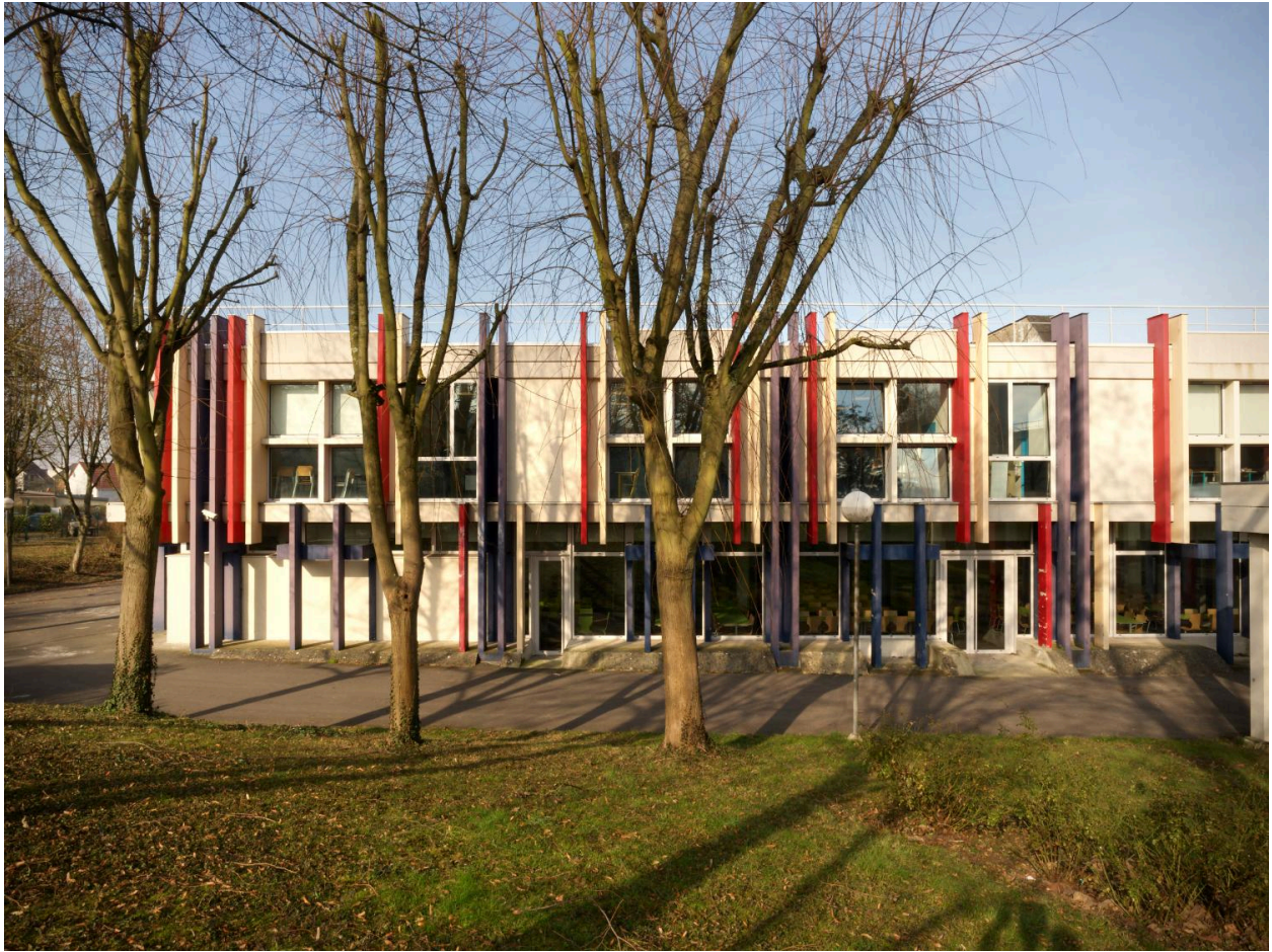
Vue générale du lycée depuis la cour.
