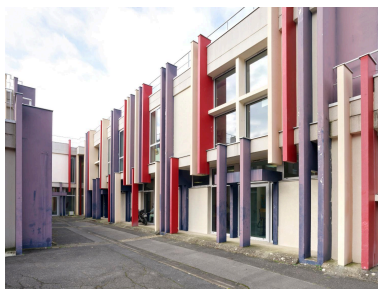
La structure porteuse du lycée, initialement grise et blanche, a été repeinte de couleurs vives (rouge / violet / blanc-crème) entre 1998 et 2006. Phot. Stéphane Asseline IVR11_20199300001NUC6A
