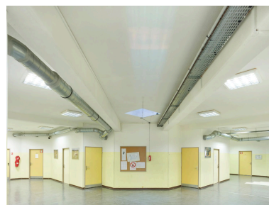
Les circulations, ponctuées de puits de lumière. Phot. Stéphane Asseline IVR11_20199300030NUC6A
