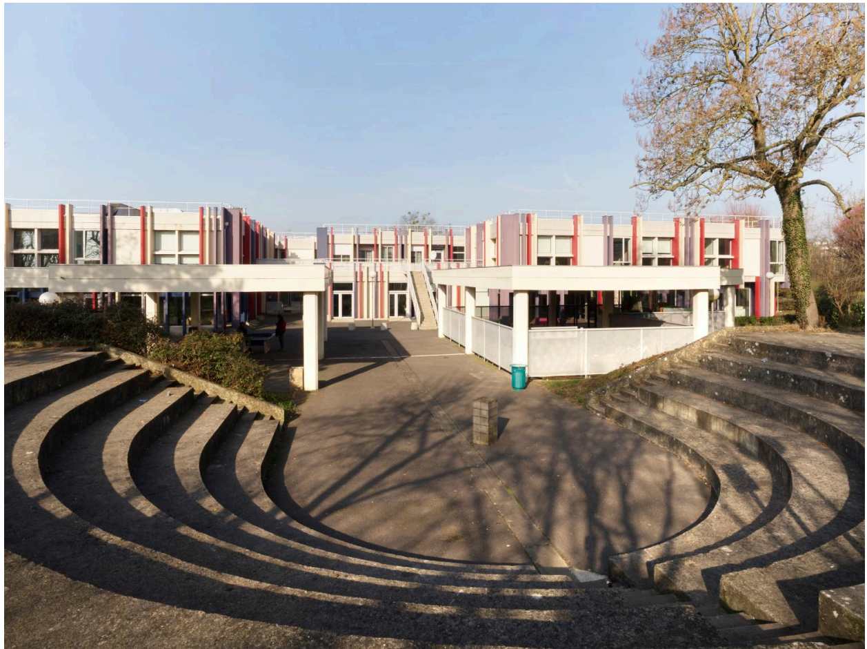
Vue générale du théâtre de plein air, au sud-est de la parcelle.
