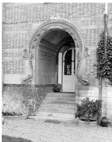
Façade latérale, entrée. Phot. Vialles Jean-Bernard IVR11_19867800611X
