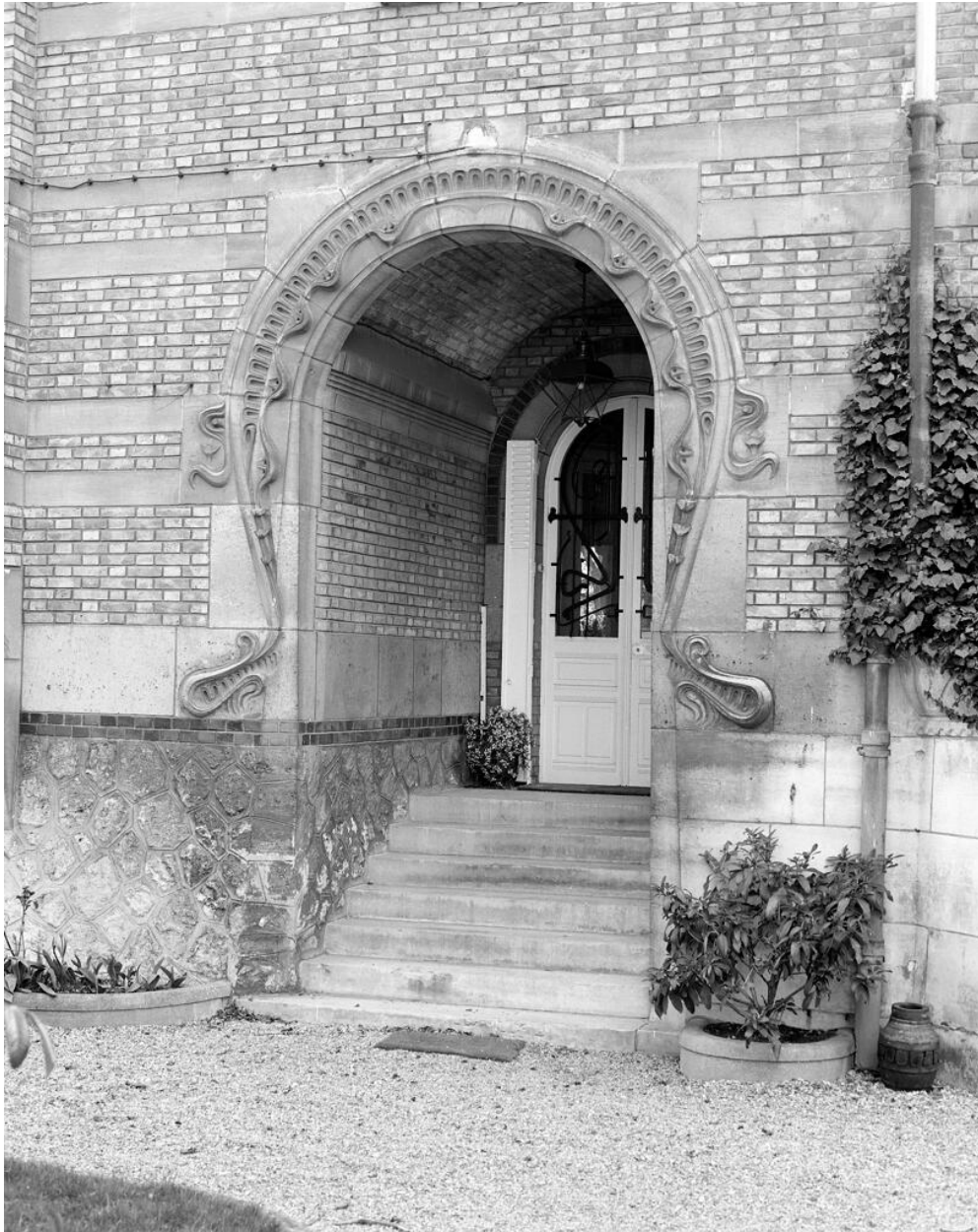
Façade latérale, entrée.
