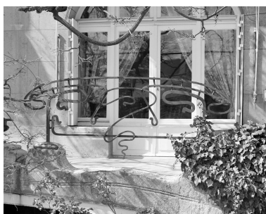
Façade antérieure, détail d'un garde-corps en fer forgé. Phot. Vialles Jean-Bernard IVR11_19867800613X
