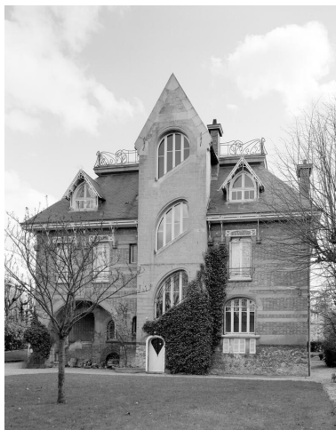
Façade postérieure. Phot. Décamps Christian IVR11_19867800609V
