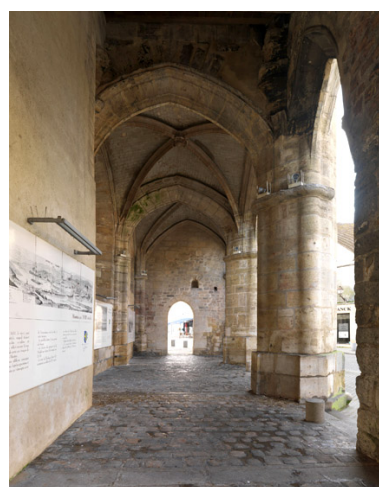
vestiges du collatéral de la nef. La pile qu'on aperçoit est une pile quadrilobée caractéristique de l'architecture flamboyante. Phot. Laurent Kruszyk IVR11_20167800079NUC4A
