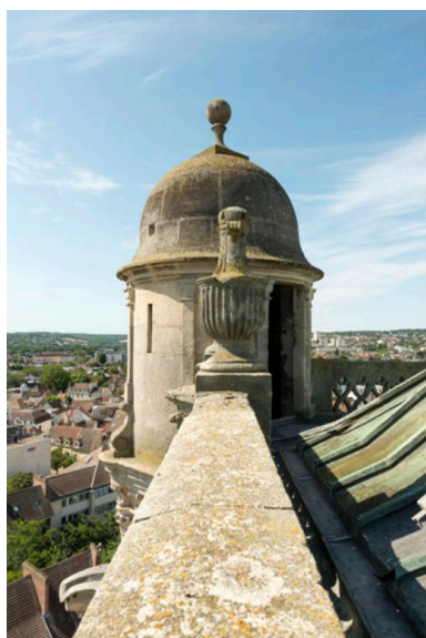
La tourelle de l'escalier est couronnée d'un dôme en pierre.
