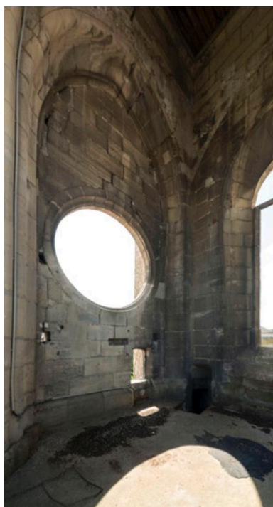
Oculus éclairant le premier étage. Phot. Laurent Kruszyk IVR11_20177800853NUC4A
