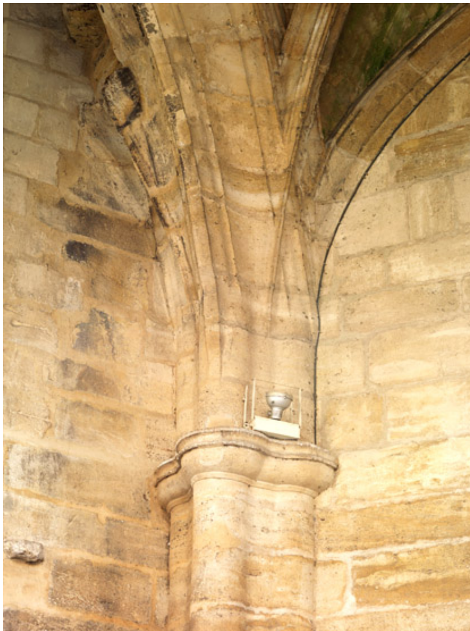
La retombée de voûtes en pénétration directe et faisceaux entrecroisés sur les piles.
