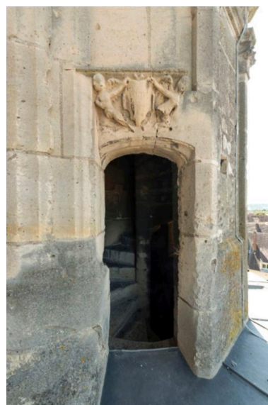
Escalier en vis à marches formant noyau desservant la tour. Phot. Laurent Kruszyk IVR11_20177800857NUC4A
