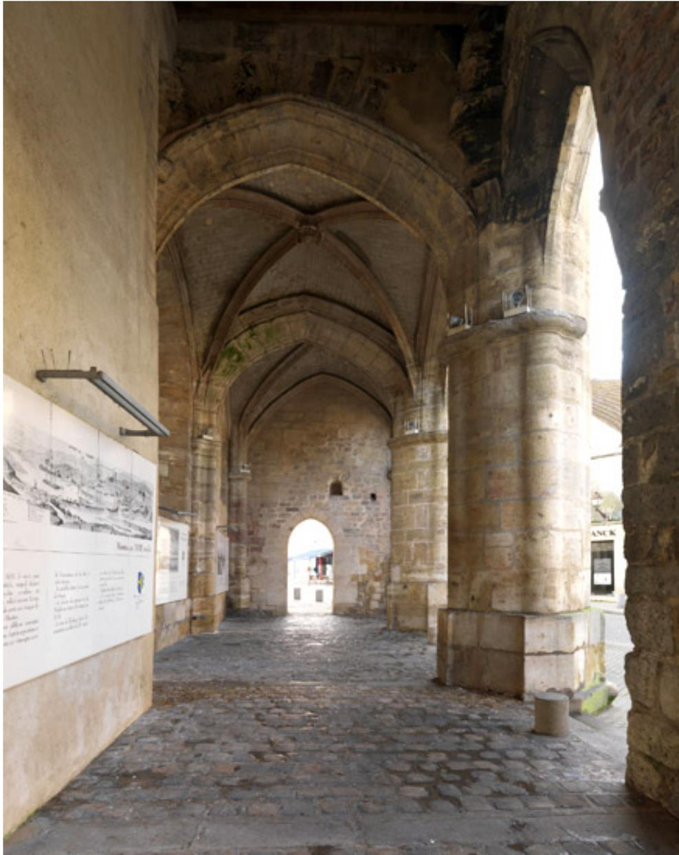
vestiges du collatéral de la nef. La pile qu'on aperçoit est une pile quadrilobée caractéristique de l'architecture flamboyante.
