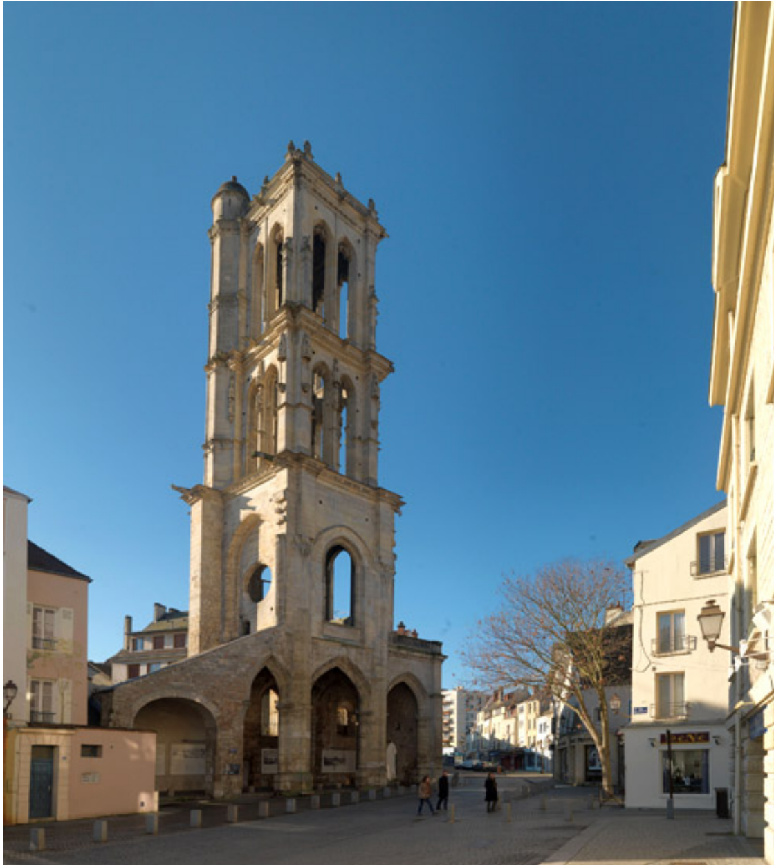
Vue d'ensemble de la tour prise depuis la place Saint-Maclou. La tour et les travées qu'elle surmonte correspondent à l'ancien collatéral sud de la nef et du chœur.
