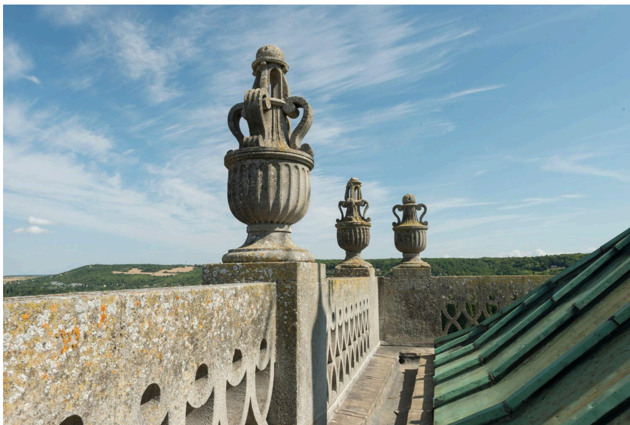
La balustrade du sommet de la tour et les vases qui l'ornent.
