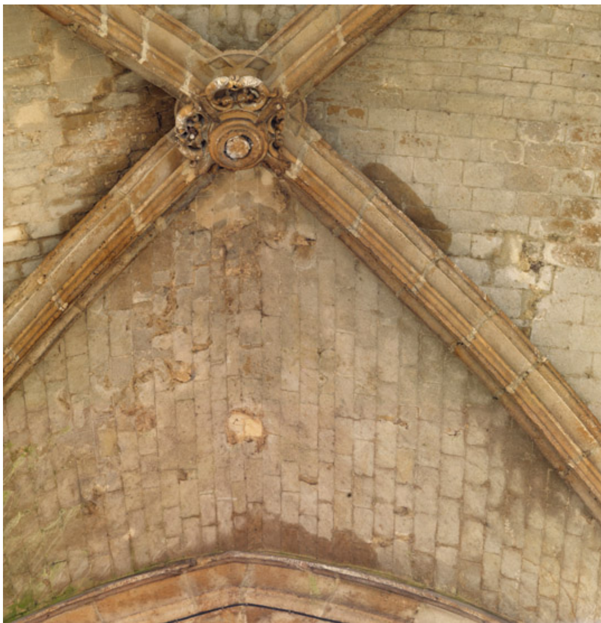
Vue des ogives de de la clé de voûte de la travée centrale.
