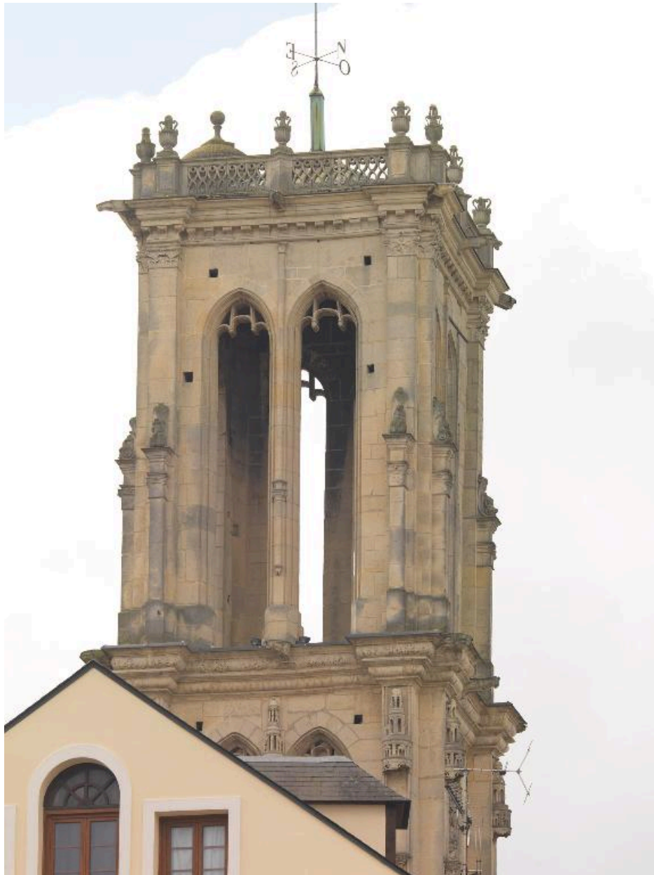
Vue de la façade nord de l'étage supérieur de la tour.
