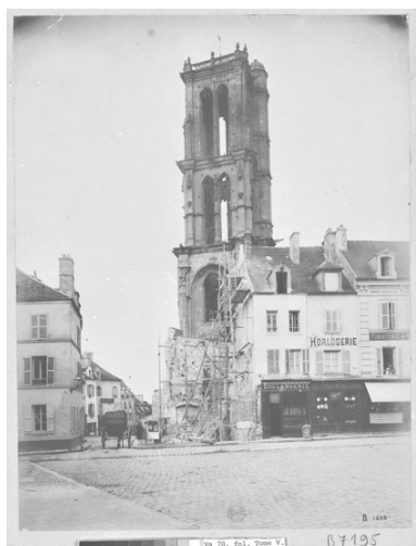
La tour Saint-Maclou. Photographie (BNF. Topo Va 78, fol. tome V. B 7195). IVR11_20157800168Z
