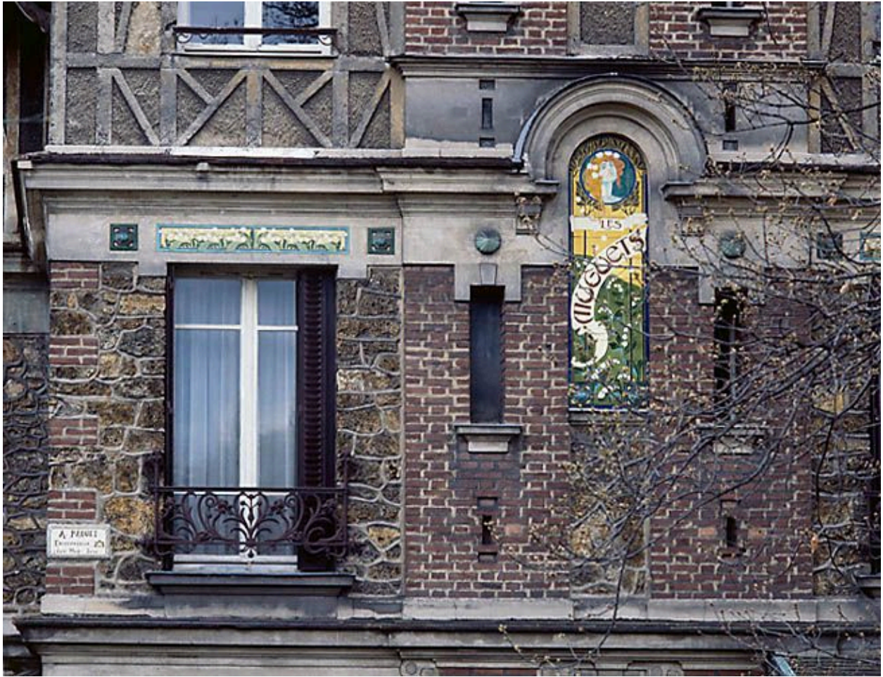
Détail de la façade antérieure avec décor de céramique.
