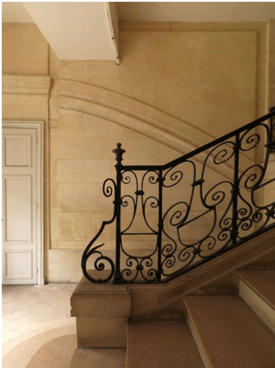
Départ de rampe et vestige du limon de la volée disparue.
