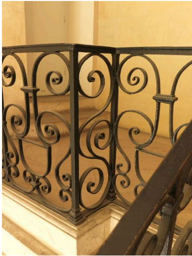
Détail du décrochement de la rampe. Phot. Philippe Ayrault IVR11_20107500467NUC4A
