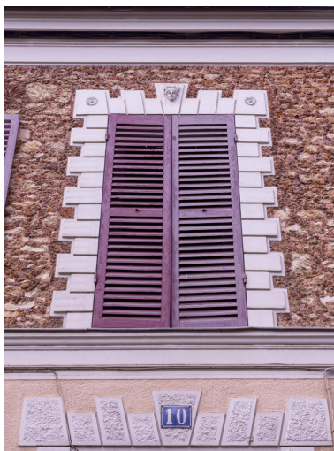
Vue de détail d'une baie de l'étage. Phot. Asseline Stéphane IVR11_20259100828NUC4A
