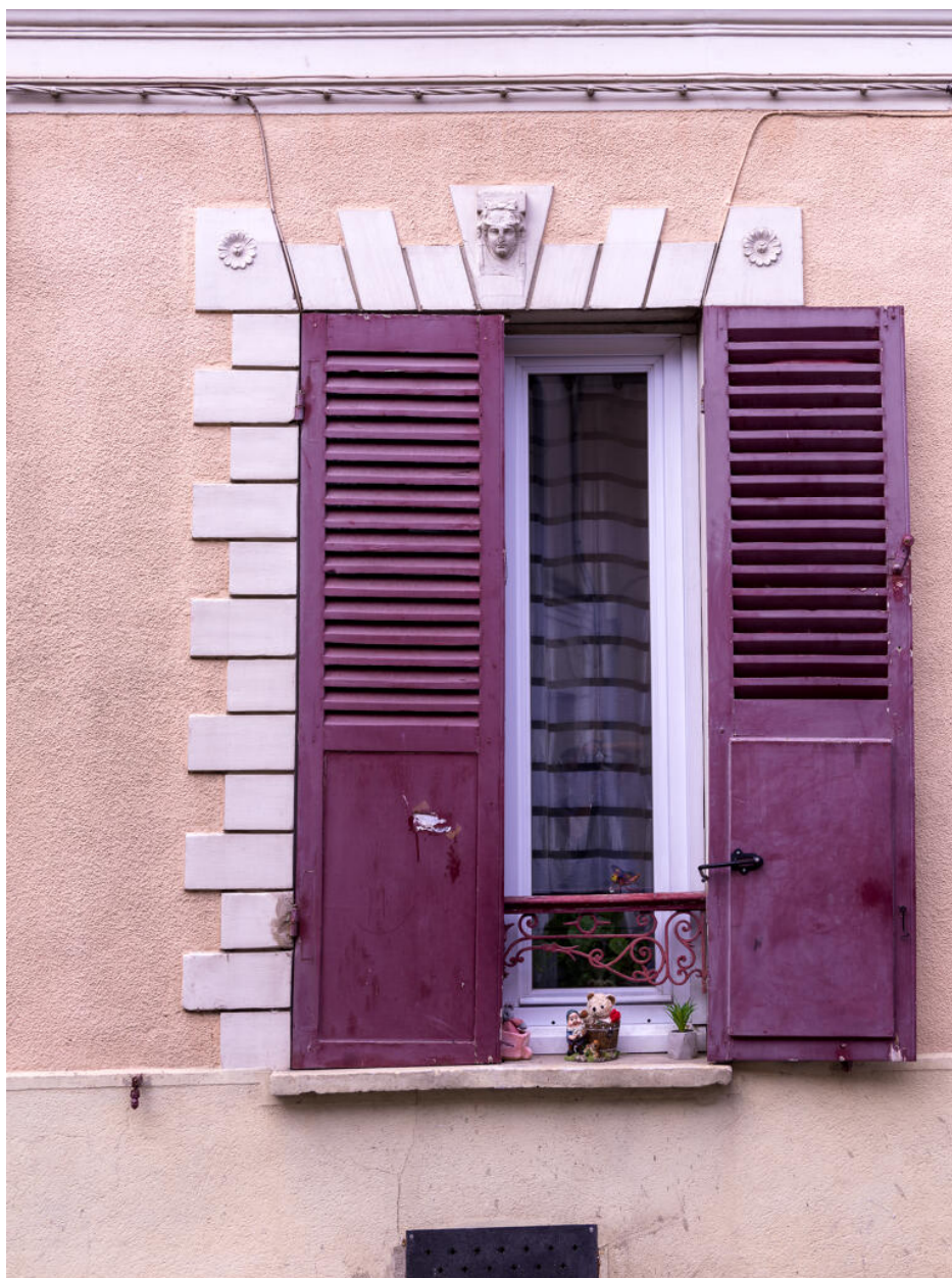
Vue de détail d'une baie du rez-de-chaussée.
