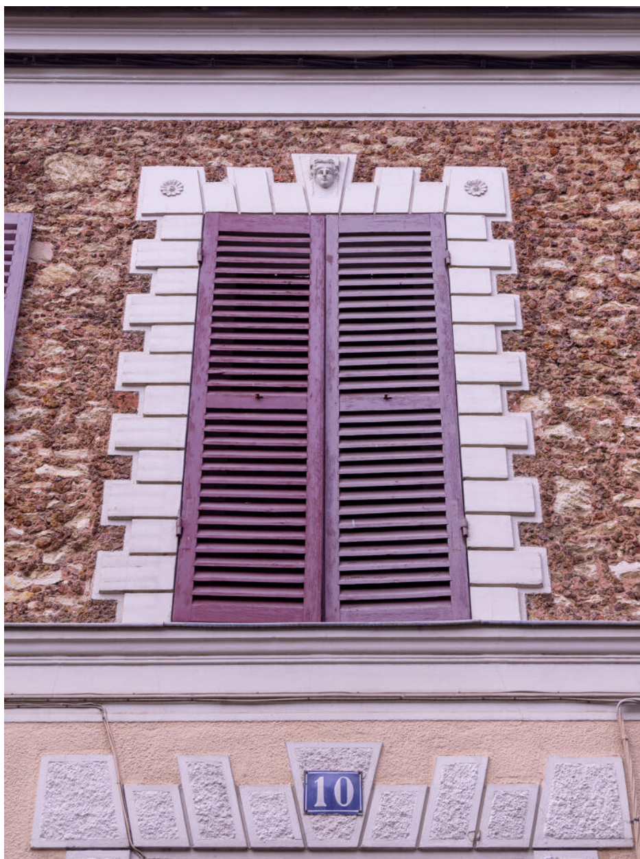
Vue de détail d'un baie de l'étage.
