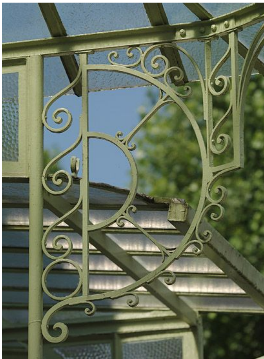
Marquise du logement patronal, décor de ferronnerie.
