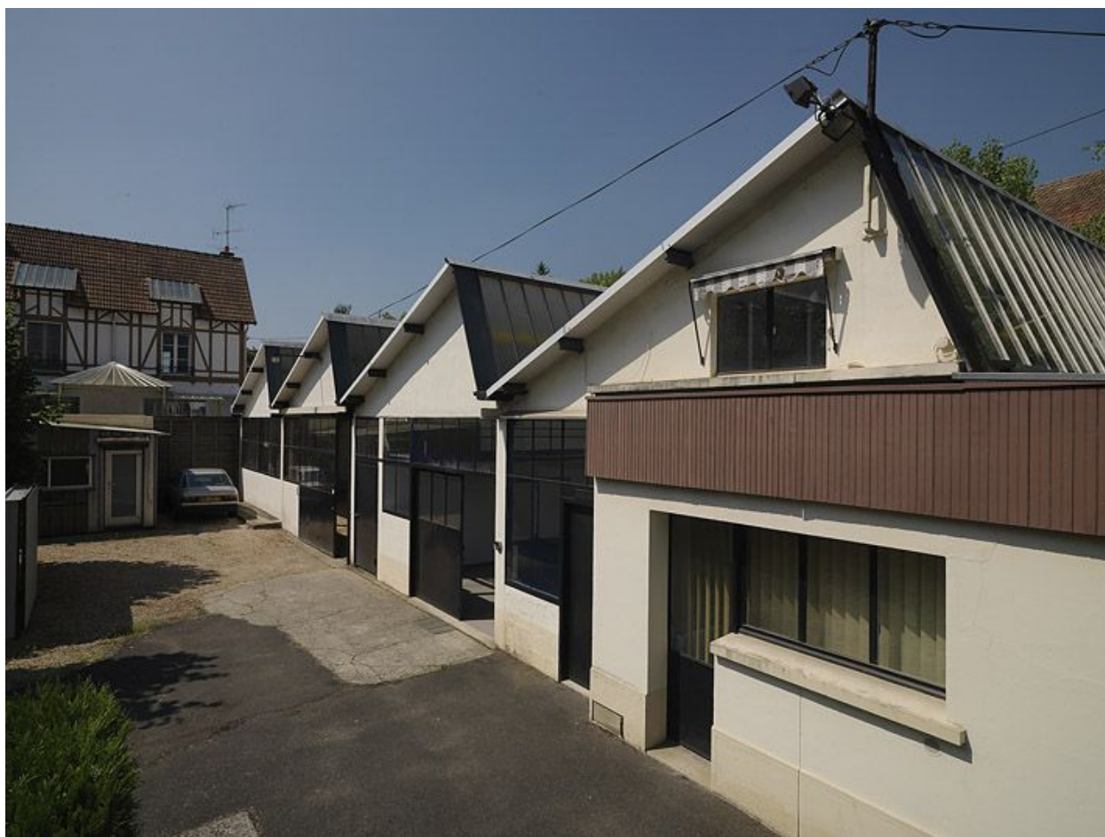
Vue générale de l'usine de serrurerie dite serrurerie Lefevre, ateliers et logement patronal.
