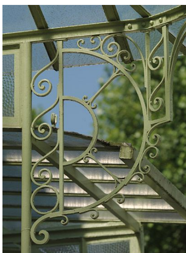
Marquise du logement patronal, décor de ferronnerie. Phot. Philippe Ayrault
