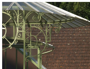
Marquise du logement patronal, décor de ferronnerie.
