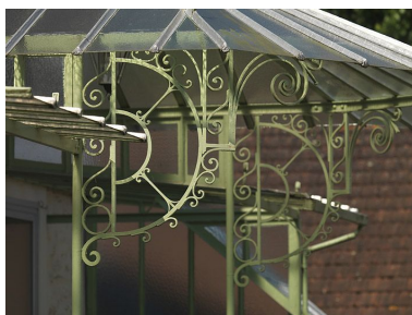
Marquise du logement patronal, décor de ferronnerie.
