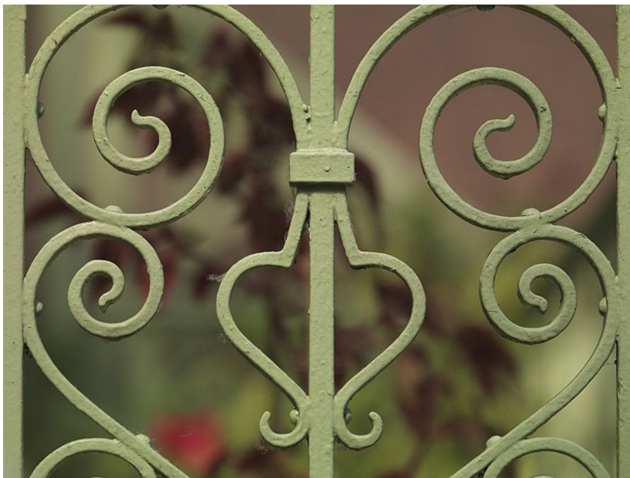
Marquise du logement patronal, décor de ferronnerie.
