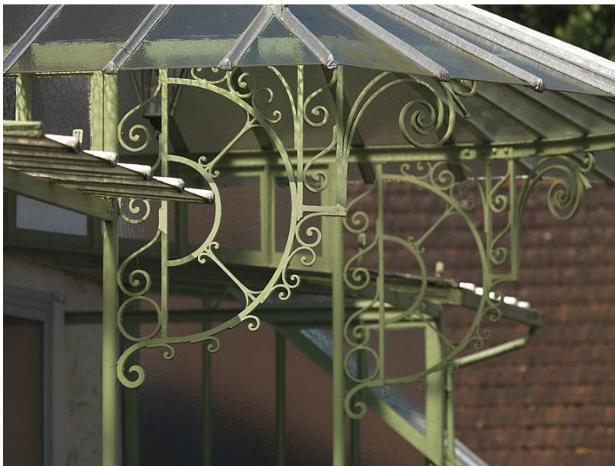
Marquise du logement patronal, décor de ferronnerie.
