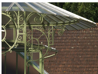
Marquise du logement patronal, décor de ferronnerie. Phot. Philippe Ayrault IVR11_20097700904NUC4A
