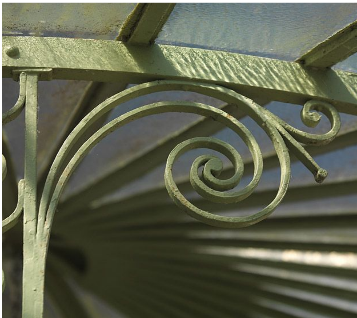
Marquise du logement patronal, décor de ferronnerie.
