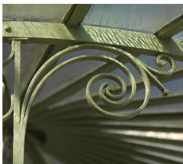
Marquise du logement patronal, décor de ferronnerie.
