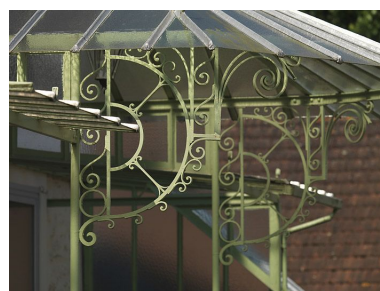
Marquise du logement patronal, décor de ferronnerie. Phot. Philippe Ayrault IVR11_20097700903NUC4A
