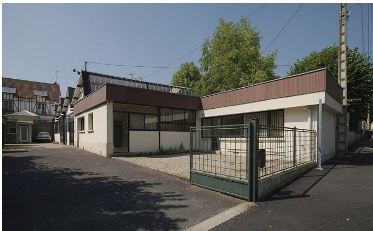
Vue générale de l'usine de serrurerie dite serrurerie Lefevre.
