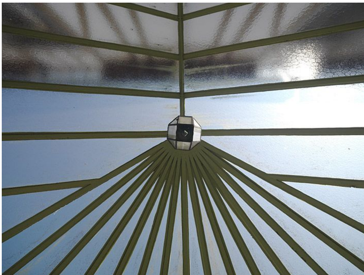
Marquise du logement patronal, verrière.
