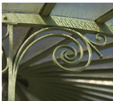
Marquise du logement patronal, décor de ferronnerie.
