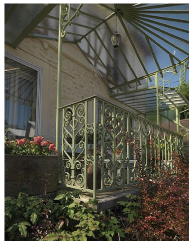
Marquise et garde-corps du logement patronal, décor de ferronnerie. Phot. Philippe Ayrault IVR11_20097700911NUC4A
