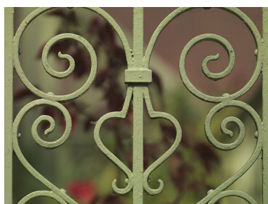
Marquise du logement patronal, décor de ferronnerie. Phot. Philippe Ayrault IVR11_20097700909NUC4A
