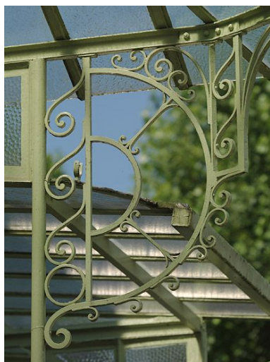
Marquise du logement patronal, décor de ferronnerie.
