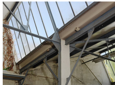
Atelier de fabrication, détail de la couverture en shed. Phot. Philippe Ayrault IVR11_20097700916NUC4A
