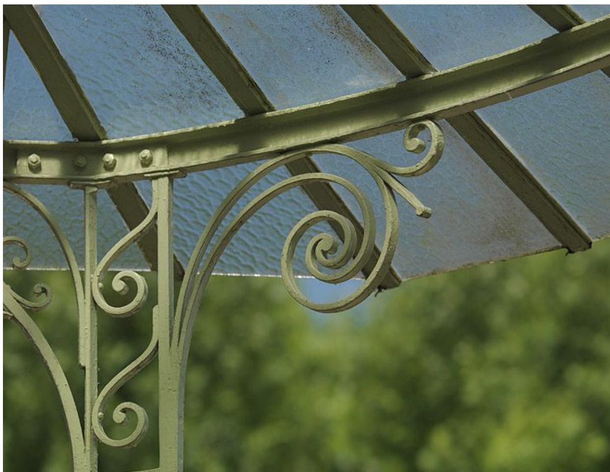
Marquise du logement patronal, décor de ferronnerie.
