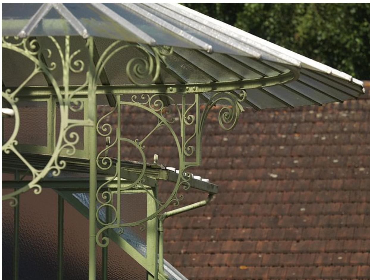
Marquise du logement patronal, décor de ferronnerie.
