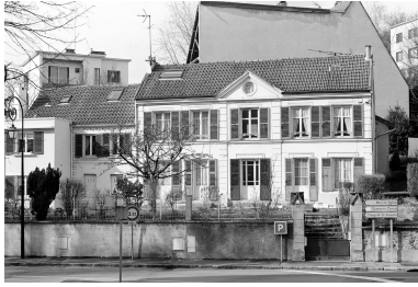
Vue de la façade antérieure. Phot. Christian Décamps IVR11_20007800118X
