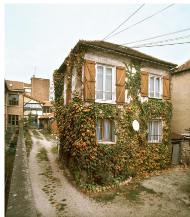
En milieu de parcelle, le pavillon d'habitation coiffé d'un toit à croupe. IVR11_20059300641XA
