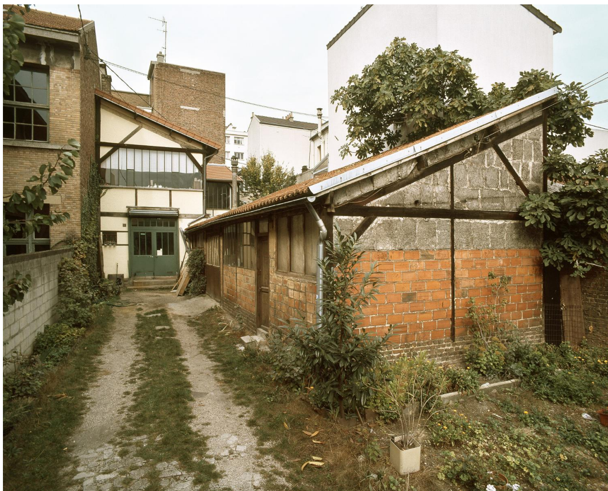
A droite, l'ancien dépôt de carrelage (élevé avant 1937) converti en atelier de literie (1946). Au fond à gauche, l'atelier de tapisserie construit en 1946.
