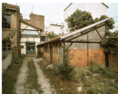
A droite, l'ancien dépôt de carrelage (élevé avant 1937) converti en atelier de literie (1946). Au fond à gauche, l'atelier de tapisserie construit en 1946. IVR11_20059300643XA
