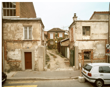
L'entrée de l'ancienne parcelle agricole en lanrière est marquée par deux pavillons à un étage, en matériaux traditionnels : moellons de gypse et enduit de plâtre. IVR11_20059300638XA
